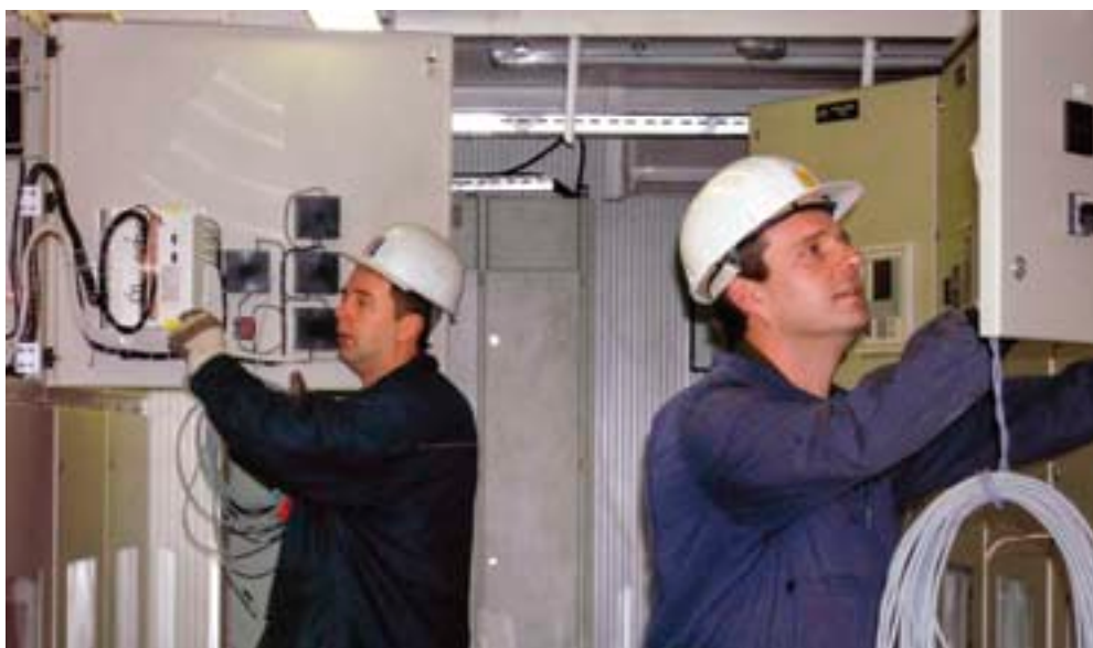
Emil Novaković i Siniša Brajnov pri radovima na novom 10 kV postrojenju
