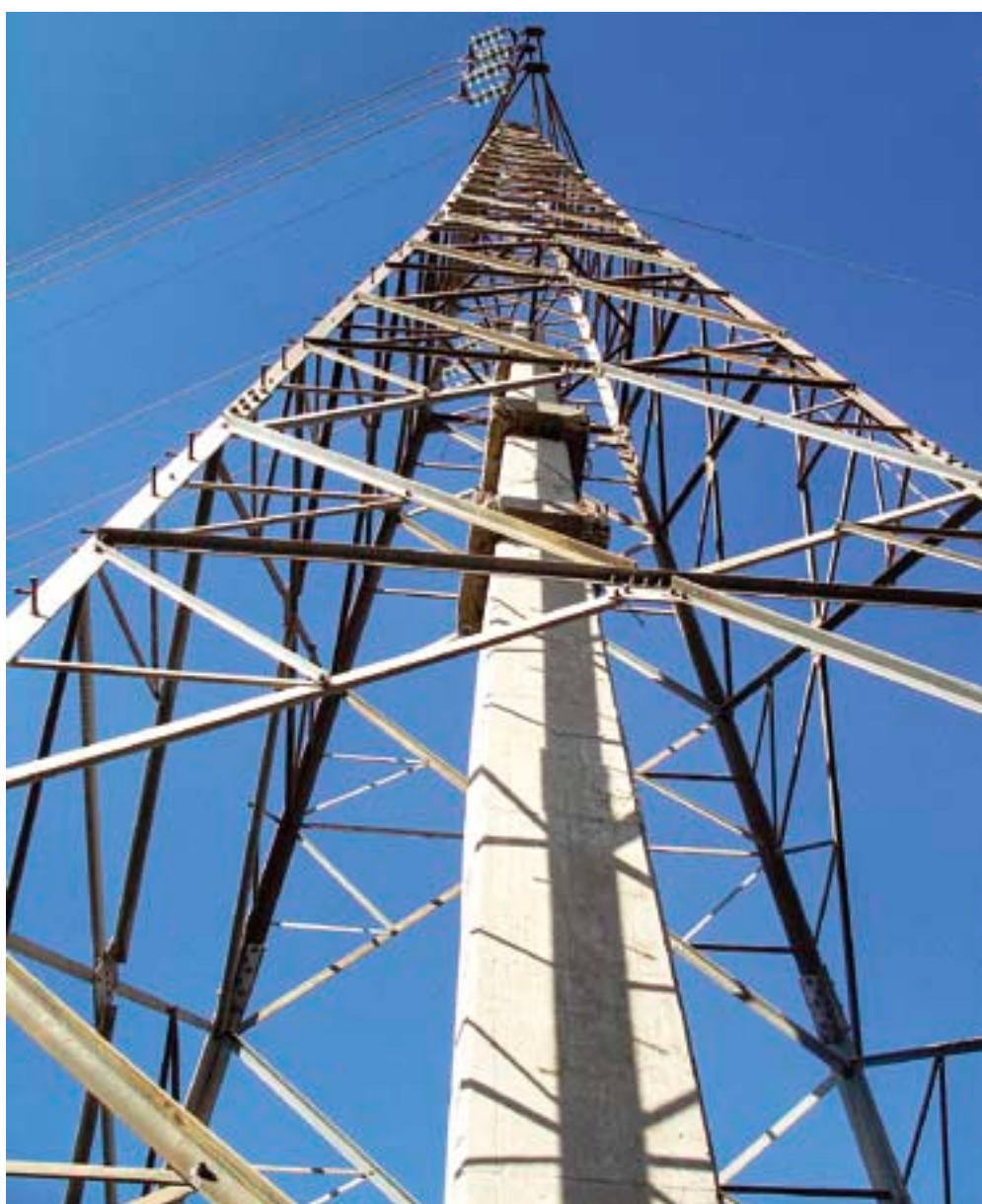
Jedno od rješenja bez rušenja betonskog stupa bio je čelično-rešetkasti stup – bačva
