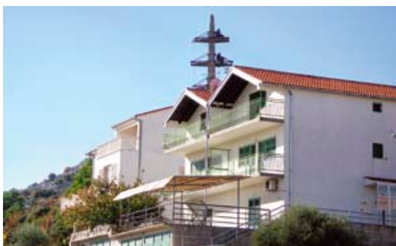
Jedno od rješenja bez rušenja betonskog stupa bio je čelično-rešetkasti stup – bačva
