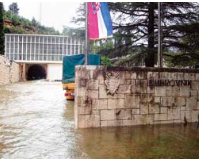
Netipičan i neprirodan prizor – poplavljeni ulaz u pristupni tunel postrojenju HE Dubrovnik
