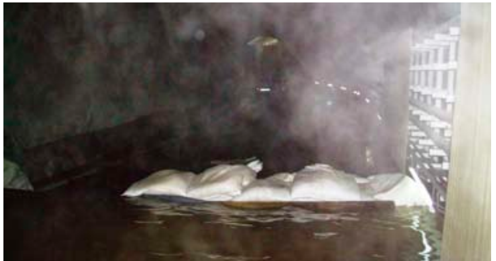
Zečji nasip u pristupnom tunelu za sprječavanje otjecanja vode prema strojarnici: vreće – voda – para, apokalipsa na platski način
