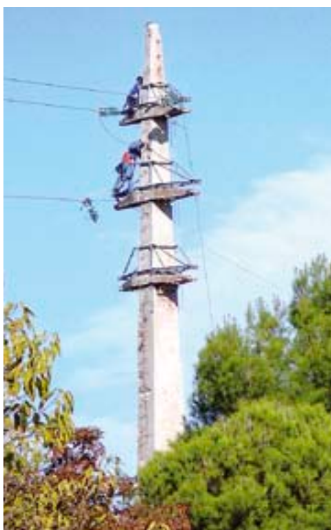
Zaposlenici tvrtke Dalekovod skidaju vodiče s jednog od 12 betonskih stupova starog dalekovoda
