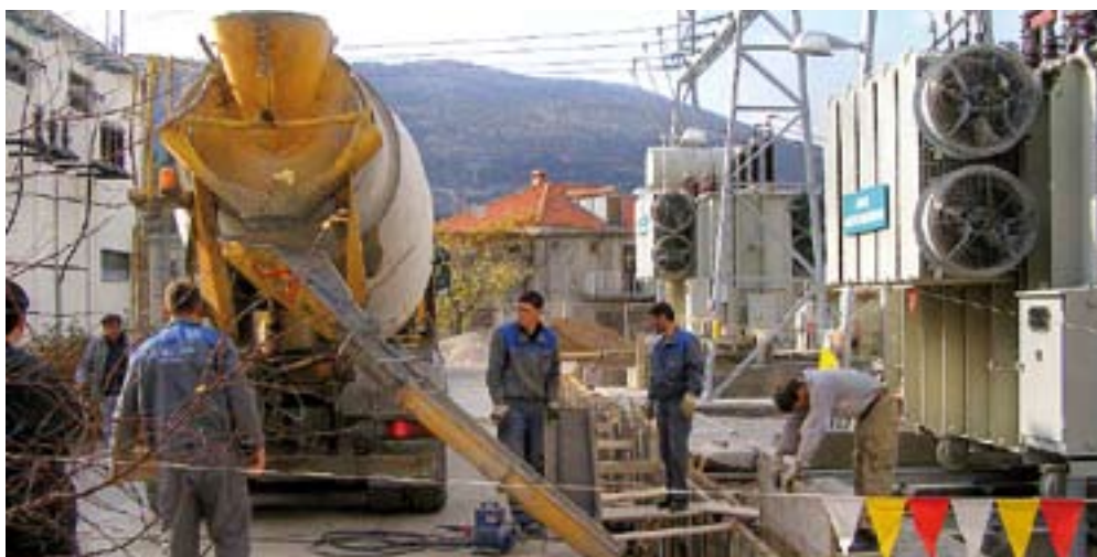
Radovi na kabelskim kanalima i...
