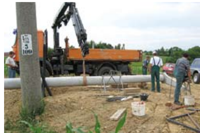
Pripremni radovi za podizanje novog stupa
