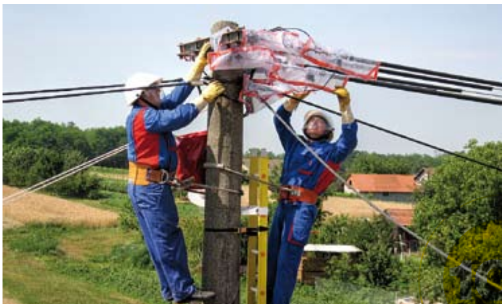
Šest obučeni čakovečkih elektraša rade – pod naponom
