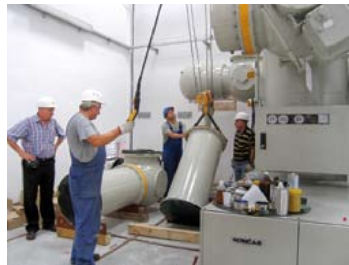
Končareva ekipa pri ugradnji 110 kV postrojenja
