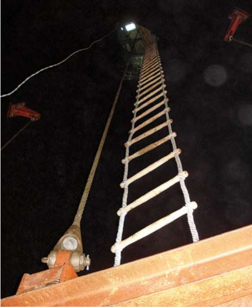
Montaža opreme za pregled tlačnog cjevovoda agregata A u gornjem koljenu
