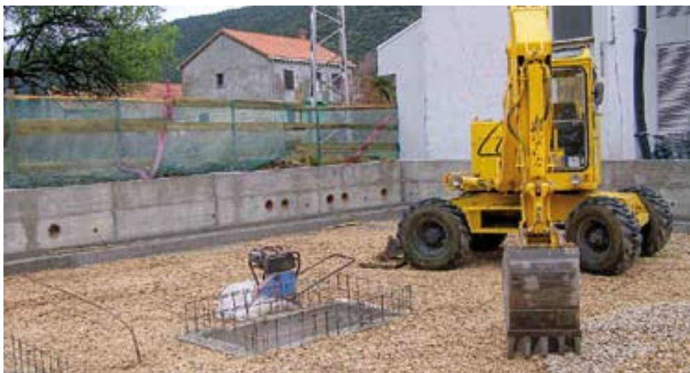
... na platou i temeljima za kontejner
