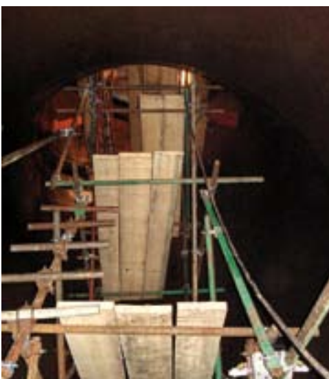
Montažna skela u donjnjem koljenu tlačnog cjevovoda
