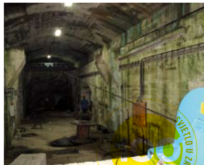
Pregled dovodnog tunela
