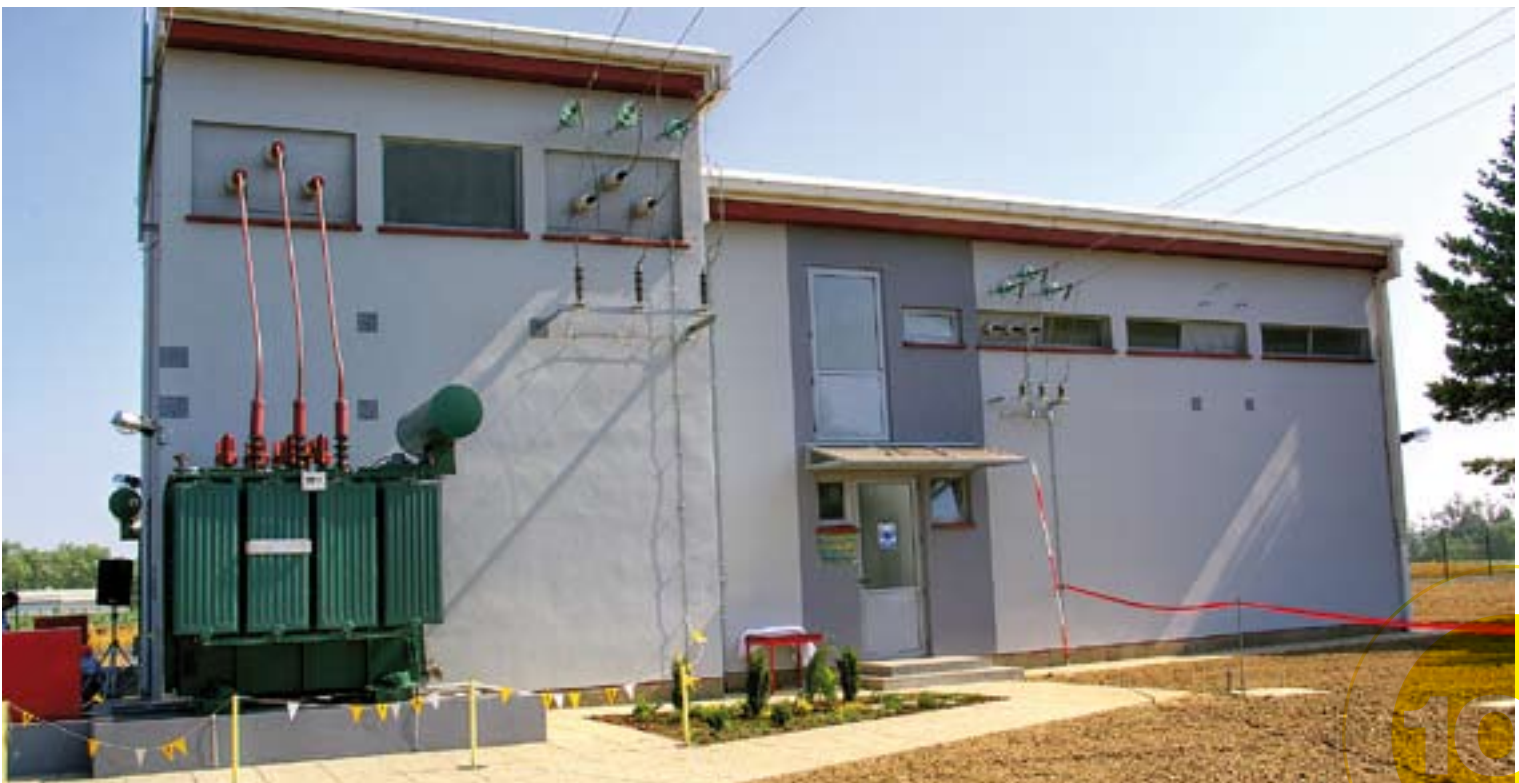
Obnovljena TS 35/10 kV Šenkovec, osim za sigurno napajanje kupaca sjeverozapadnog dijela Međimurske županije, postaje i prigradska trafostanica grada Čakovca
