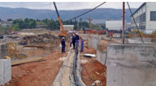
Gradilište sredinom studenoga
