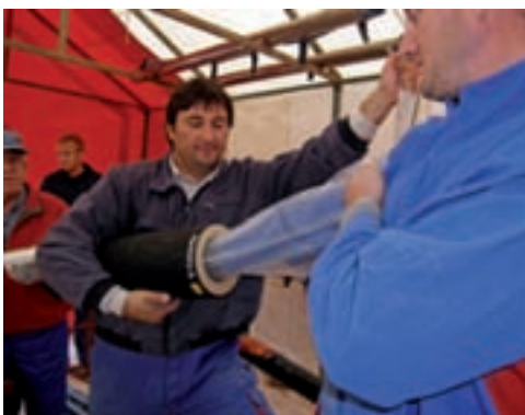
Zoran i Joško čiste dijelove spojnice
