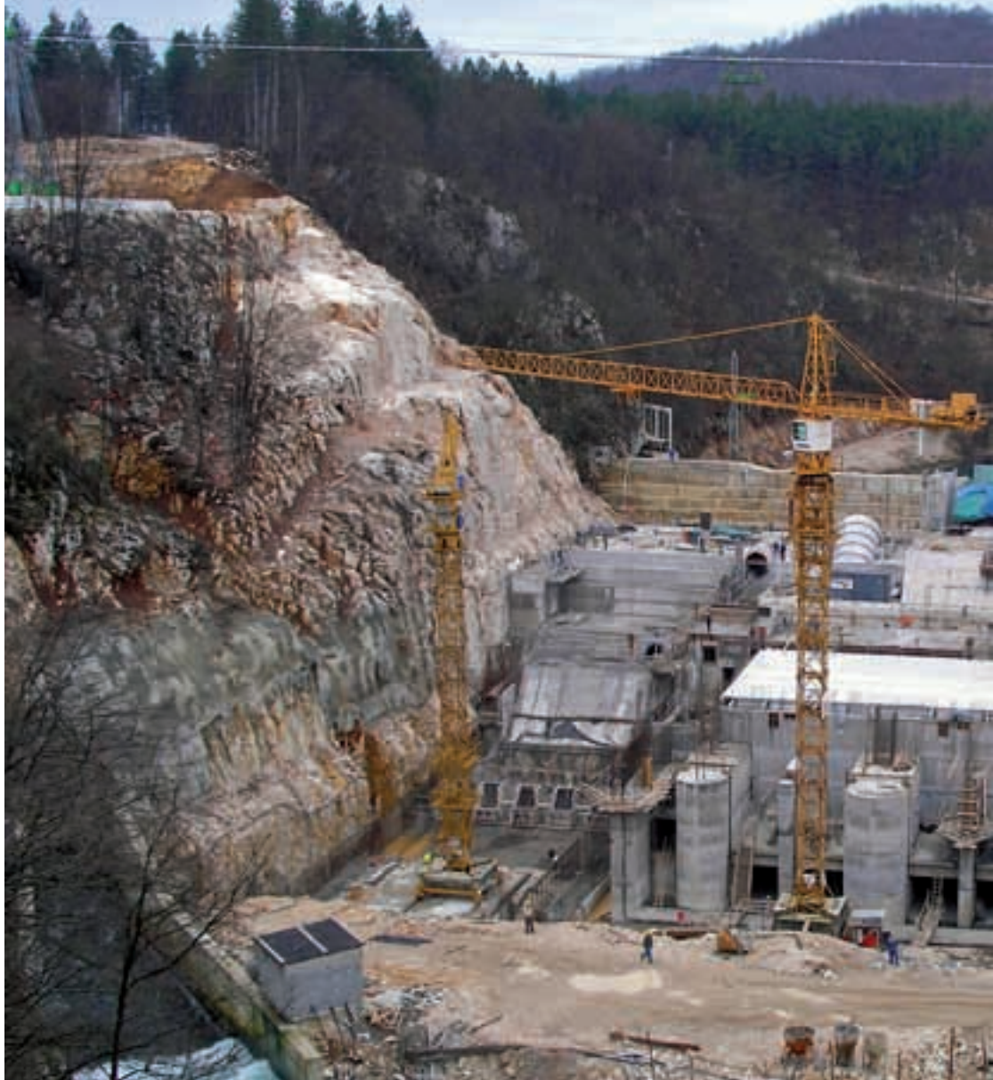
Gradilište HE Lešće krajem siječnja – niču prepoznatljive sastavnice hidroenergetskog objekta
