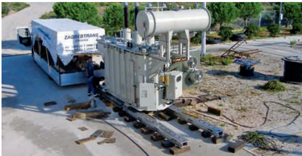
Navlačenje transformatora na temelje
