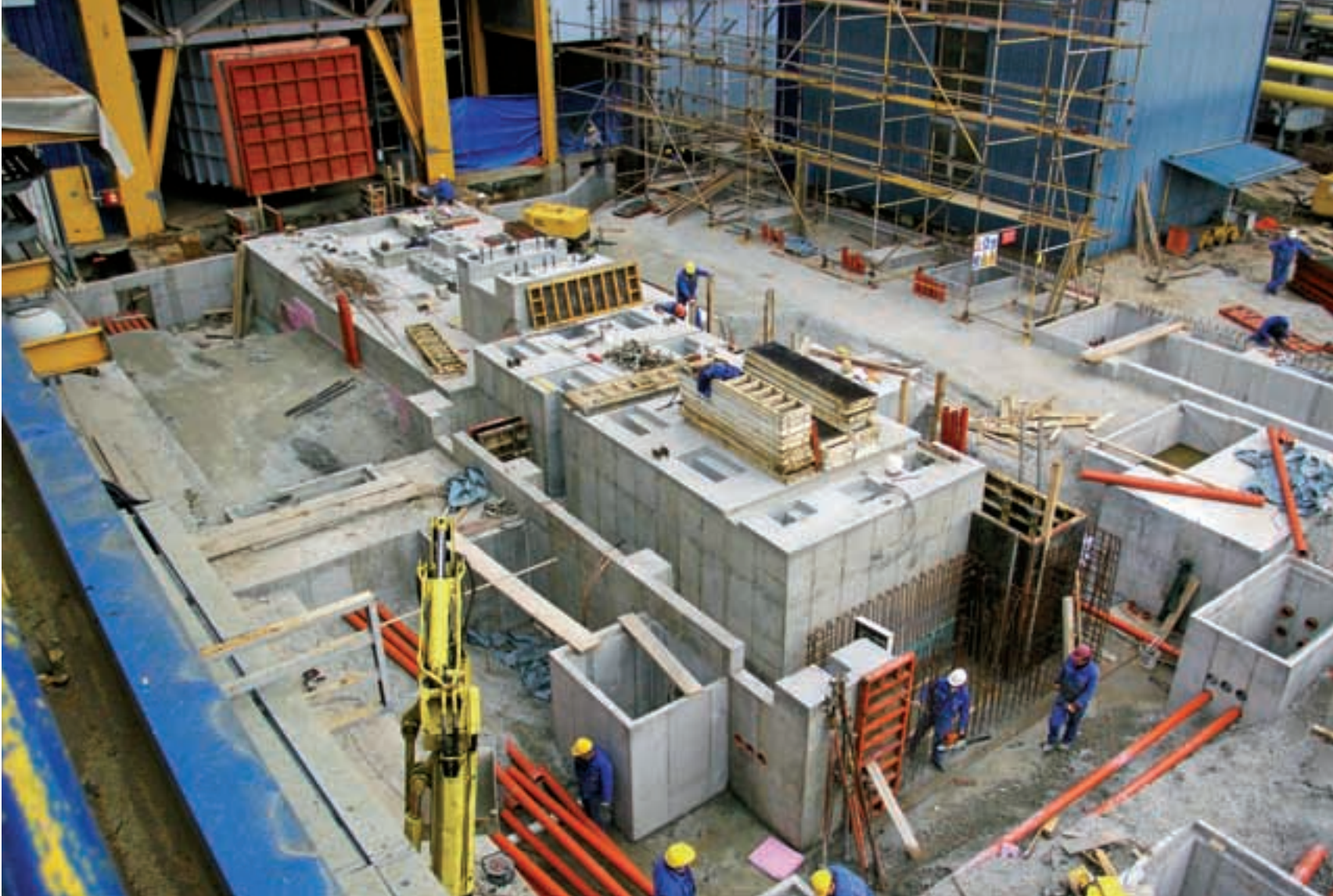
Postolje plinske turbine s generatorskim dijelom i reduktorom - iz ptičje perspektive
