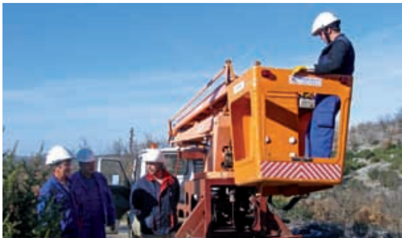
Dečki iz šibenske Službe održavanja na izgradnji nove niskonaponske mreže u zaseoku Bakotići
