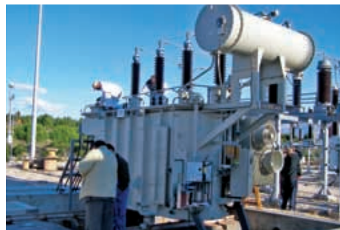
Završni radovi na transformatoru
