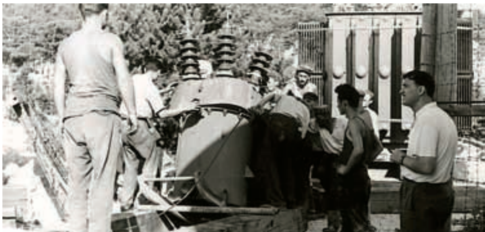
Radovi u TS Kalun – postavljanje uljnog prekidača na postolje (prvi s desna je dipl. ing. Neven Milun, tadašnji tehnički direktor Elektre Šibenik)
