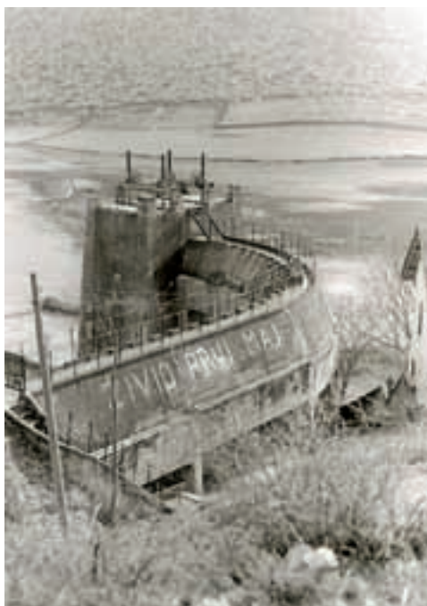
Dovod vode „slobodnim licem“ do turbina HE Roški Slap
