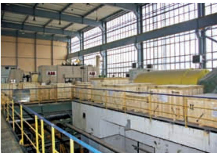
Nova oprema čeka na ugradnju
