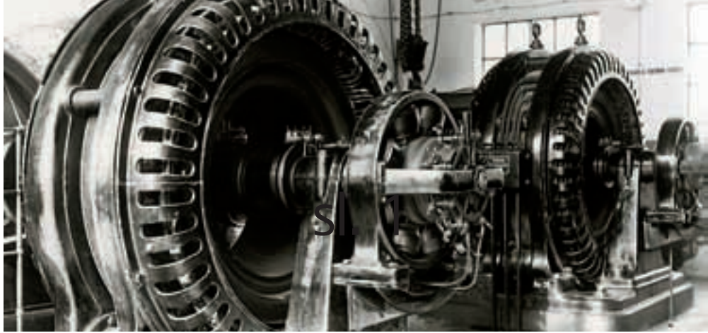
Dva generatora po 500 kVA u HE Roški Slap
