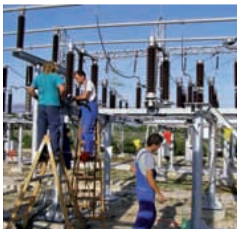
Ugradnja 110 kV opreme
