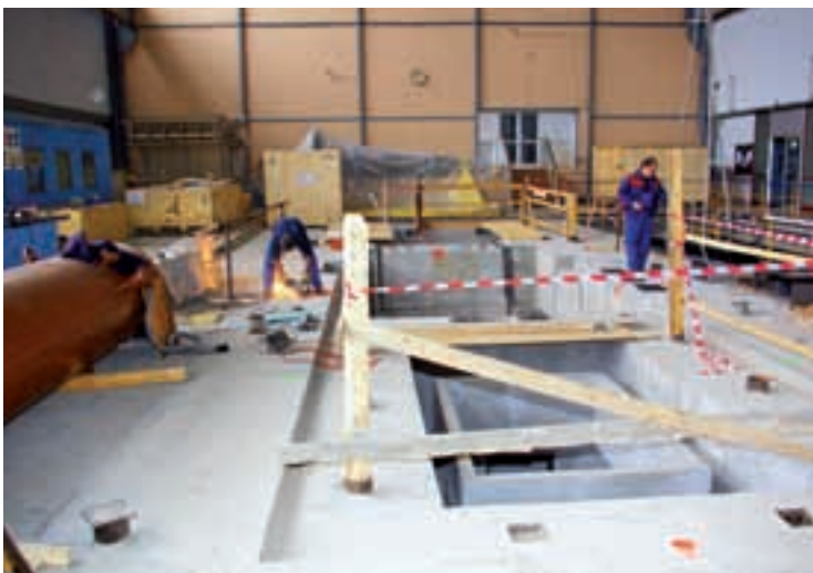
Dovršava se stol parne turbine
