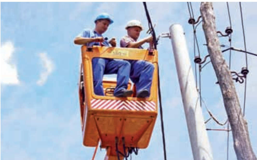
Sanacija uništenog vodiča i stupa nakon nepogode
