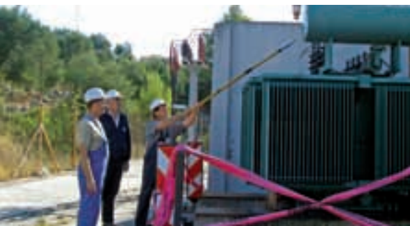
Ivan, Jure i Damir ispituju beznaponsko stanje transformatora
