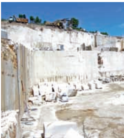
Jedan od nekoliko kamenoloma za koje se ubrzo grade tri trafostanice
