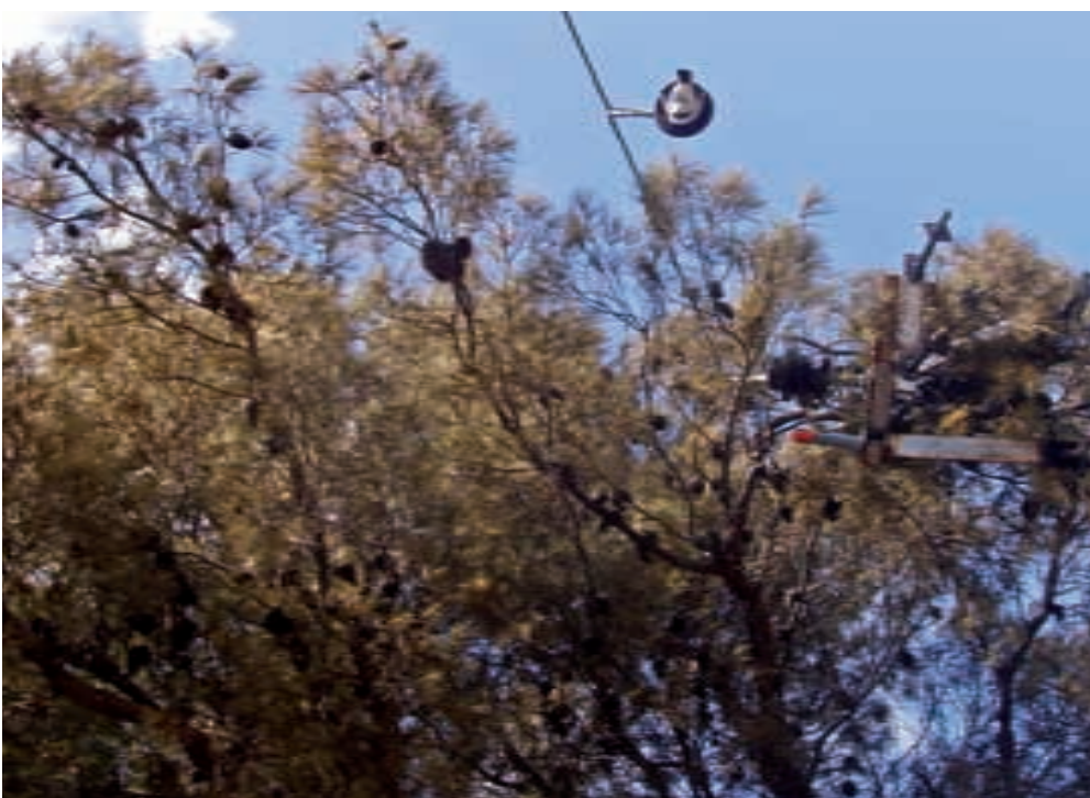
Oprema stupa zapletena u granju
