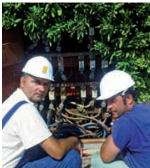
Monteri Tomislav Kelava i Željko Radočaj ljeta provode ugrađujući nove priključke
