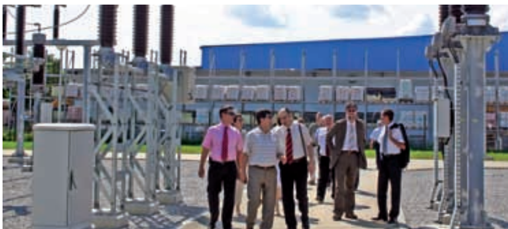
U šetnji uz postrojenja, gosti su se uvjerali da je izgradnja odavno planirane trafostanice pred završetkom i skorim puštanjem postrojenja u probni rad
