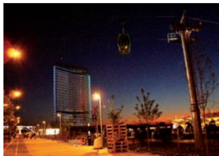
Pogled noću na Vodeni toranj, najvišu građevinu EXPO-a, i žičaru
