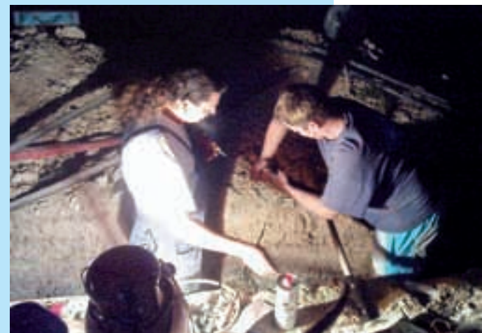
Monteri Vedran Martinić i Toni Kevešić proslavili su noć povećanja cijene električne energije ponoćnom ugradnjom spojnice
