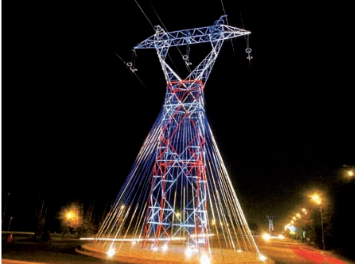
Instalacija u prirodi: metamorfoza 34 metar visokog 225 kV stupa u osvjetljeni umjetnički objekt u mjestu Amnéville-les-Thermes u Francuskoj
