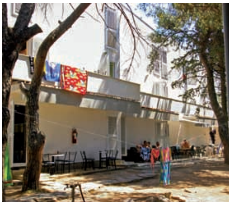
Pakoštane - ogledni primjer za pristup i način obnove i ostalih objekata za odmor HEP-a
