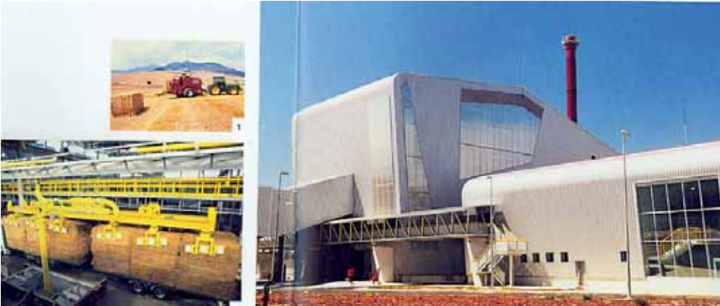
Termoelektrana na biomasu-slamu (investicija 50 milijuna eura, snaga 25 MW, godišnja proizvodnja 200 GWh, potrošnja slame 160.000 tona)
