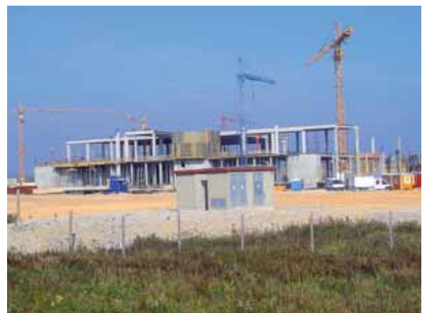
Prva faza novog Trgovačkog centra Zagreb je u izgradnji, a u završnici će se prostirati na 15 hektara i trebat će približno čak 15 MW snage
