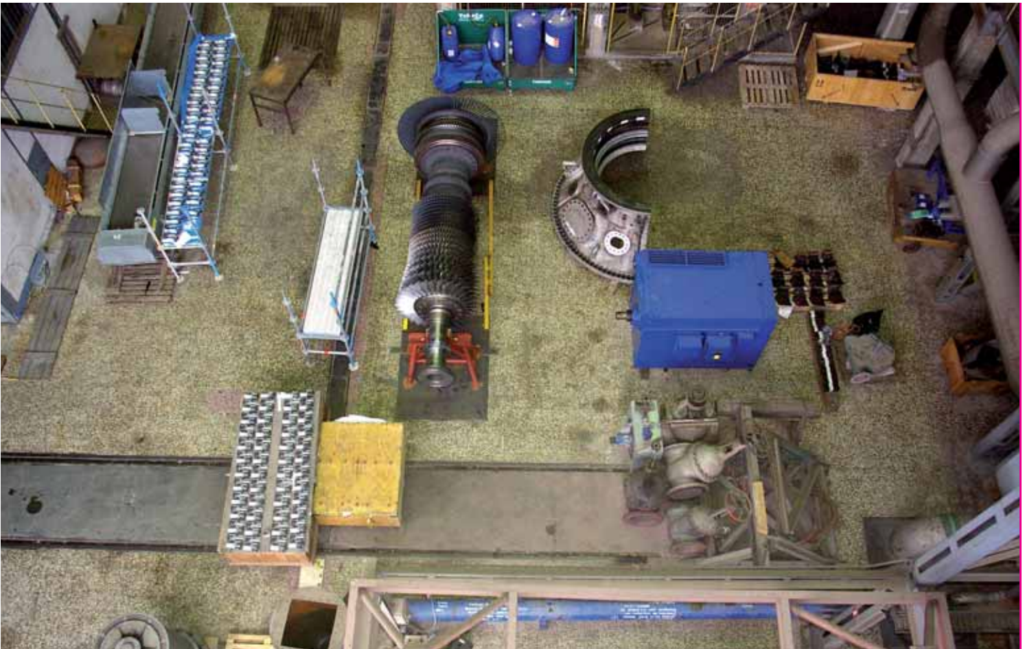
Rotor 1 plinske turbine privremeno u strojarnici parne turbine Bloka C, spreman je za zamjenu lopatica 1. i 2. turbinskog stupnja
