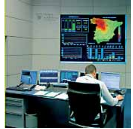
Dispečerski centar Operatora prijenosnog sustava Red Eléctrica
