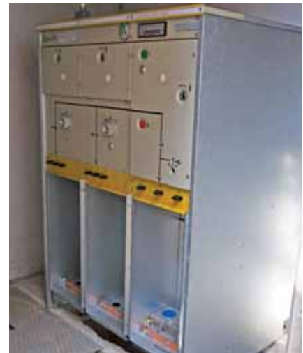
Kompaktna sklopna aparatura Sigma 24-2VT, s tvorničkim brojem 0001, u TS Lanište
