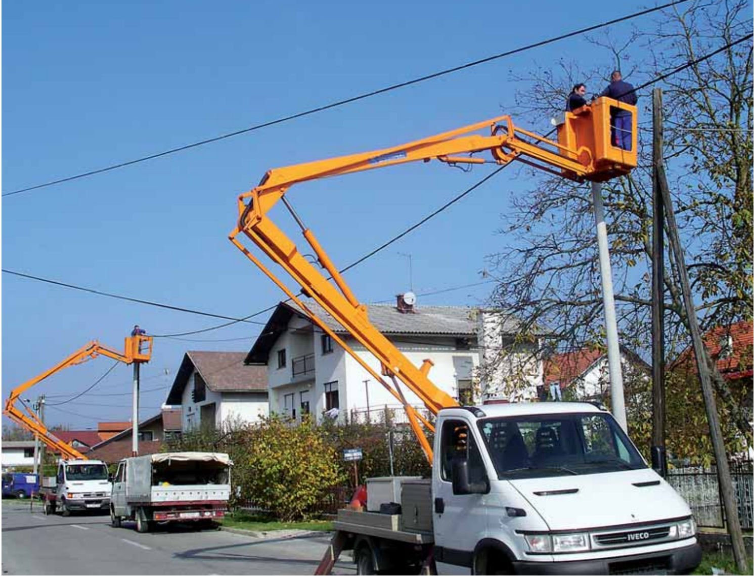
Monteri Robert Kovačić, Tomica Palaić (u prvoj košari) te Dean Tomašec i Vlado Porodec (u drugoj košari) završavaju rekonstrukciju niskonaponske mreže u ulici Ilije Grgovića
