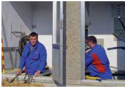
U novoizgrađenoj TS 20/04 kV Kalamiri Ivica Kovač, VKV monter i Gordjan Ferenčak, KV monter izvode stanično uzemljenje u niskonaponski razvod
