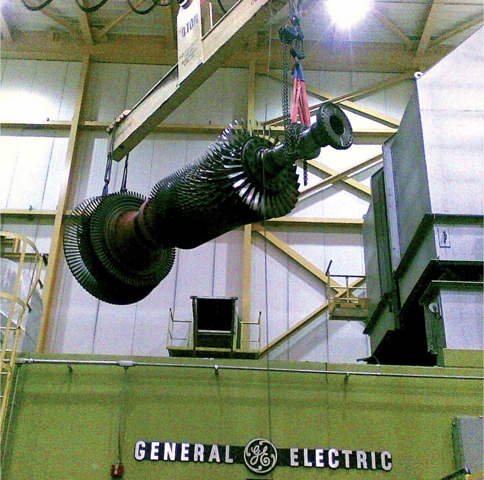
Demontaža rotora plinske turbine ključni je trenutak remonta (zabilježen je u tri sata ujutro)
