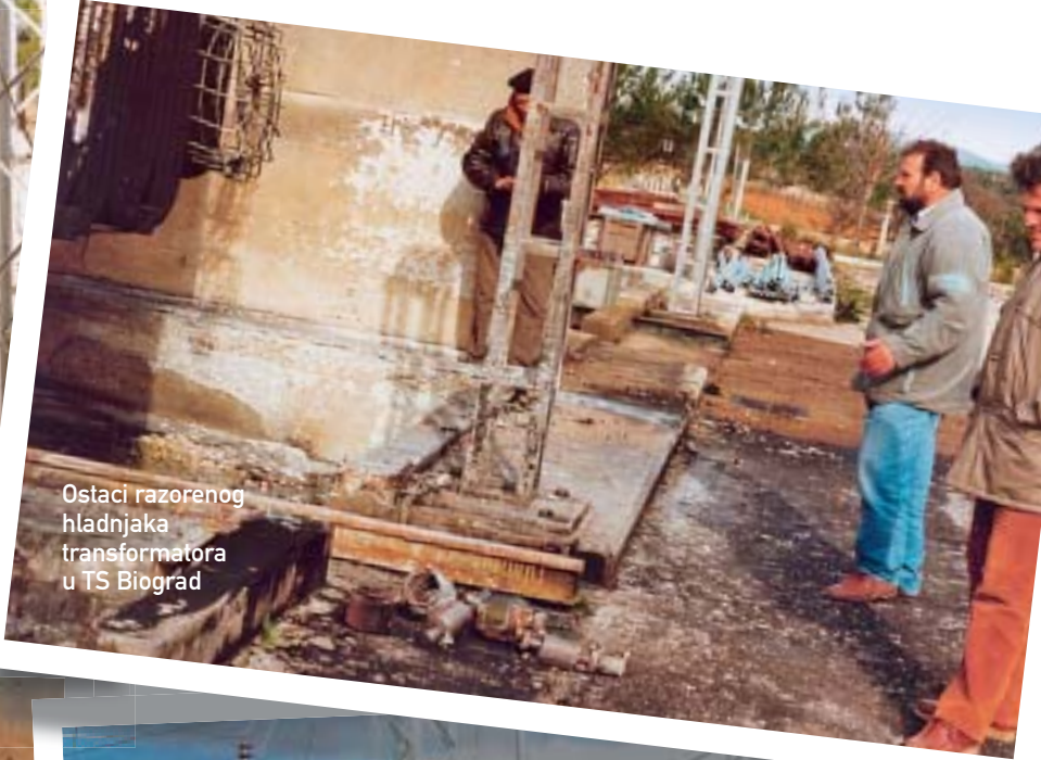
Temeljito oštećeni 110/45 kV transformator u TS 110/35/10 kV Biograd
