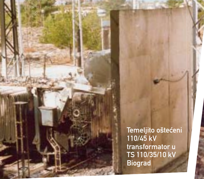
Ostaci razorenog hladnjaka transformatora u TS Biograd
