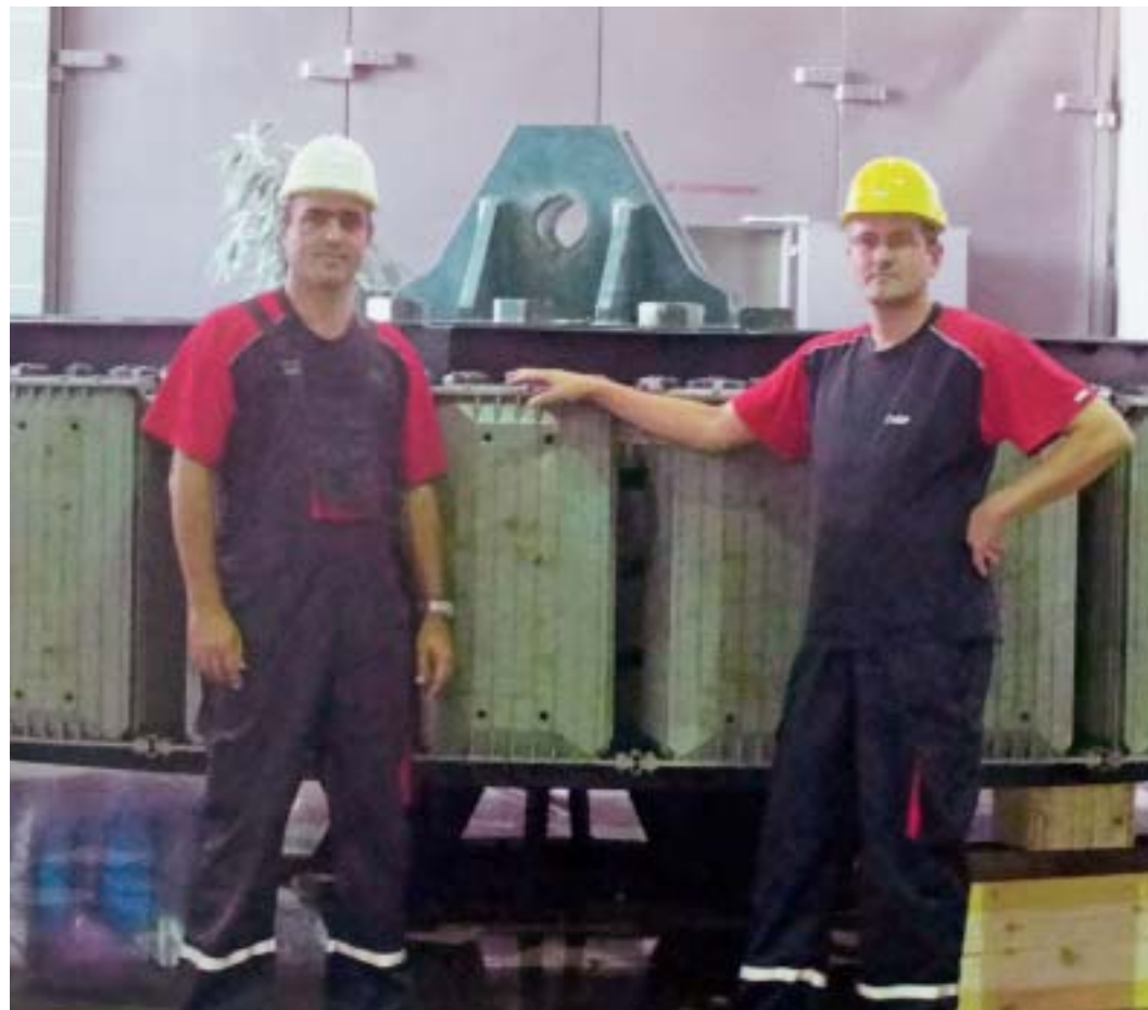
Glavni nadzorni inženjer Zvonimir Jakelić i nadzorni inženjer Metod Jurić Šolto pokraj izvađenog rotora generatora A
