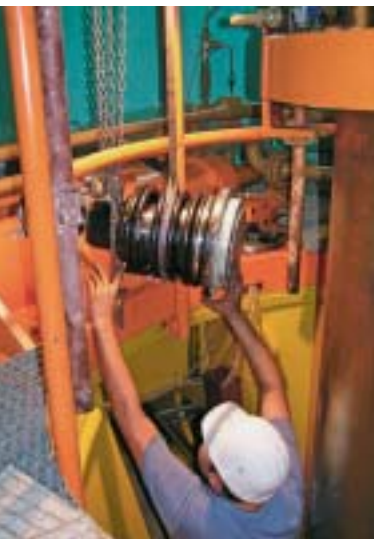
Priprema za montažu zračnog ventila
