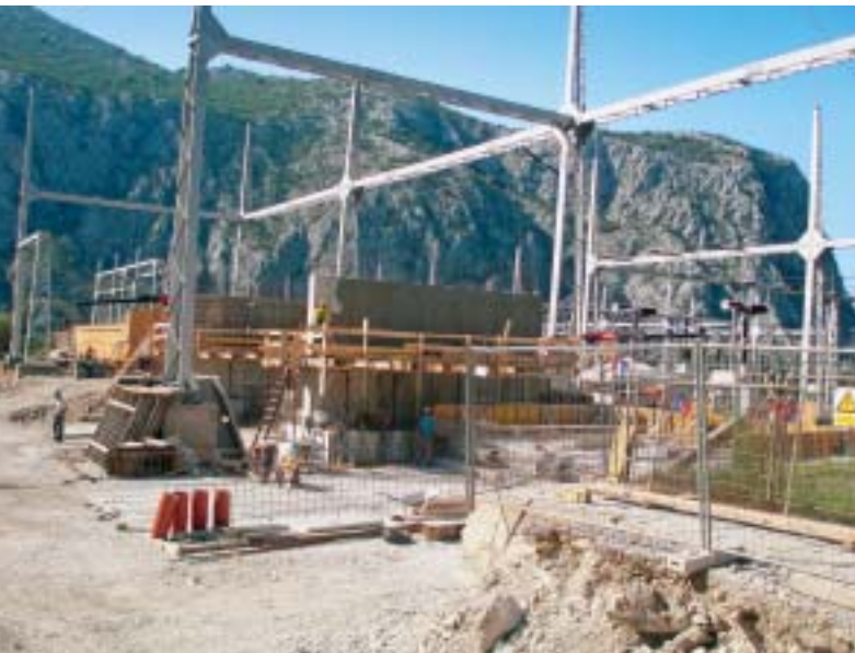
Izvedba novih temelja u rasklopnom postrojenju – stvaranje uvjeta za mrežni transformator 220/110 kV, 150 MVA
