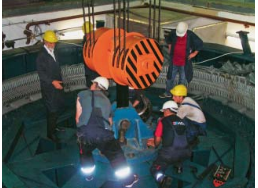
Montaža naprave za vađenje rotora generatora
