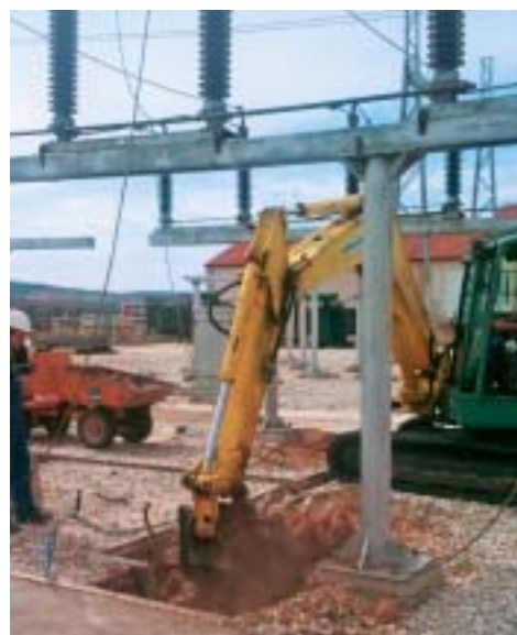
Zbog složene prilagodbe novih pogona rastavljača HAPAM MT100, za elektromontažne i građevne radove angažirani su vanjski izvođači
