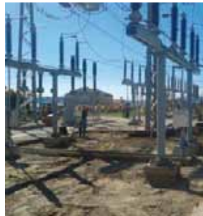
Radovi u transformatorskom polju 2 za zamjenu prekidača i pogona rastavljača
