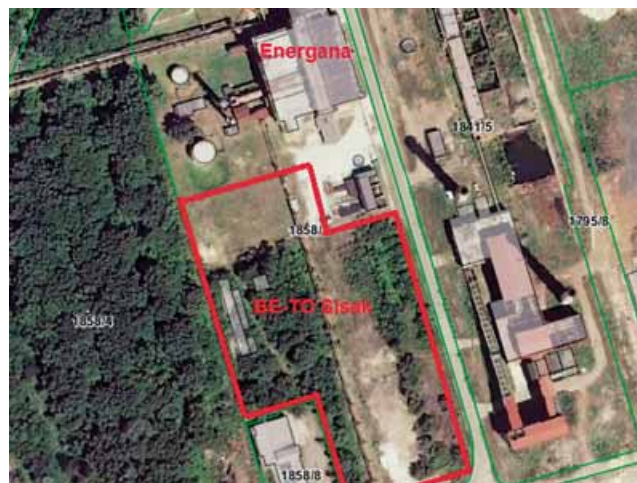
...nove BE-TO Sisak na lokaciji Energane Željezare Sisak
