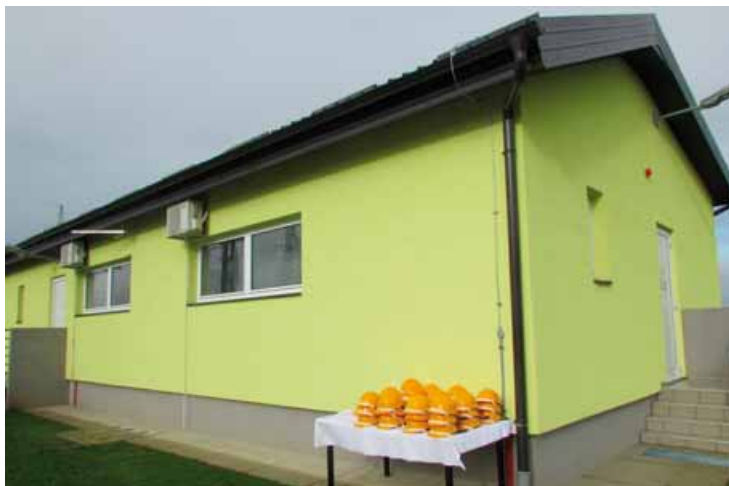
Zaštitne kacige čekaju sudionike svečanosti puštanja u pogon novog postrojenja
