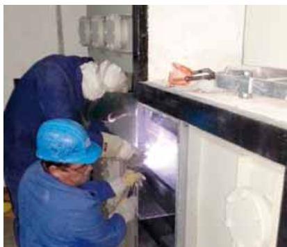
Sanacija oklopljenih spojnih vodova generator-blok transformator
