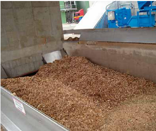
Drvena sječka spremna na put prema ložištu...
