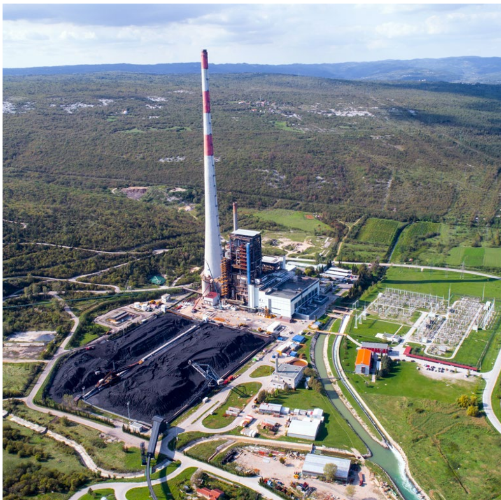
↑ Novo DeNOx postrojenje na plominskoj lokaciji
