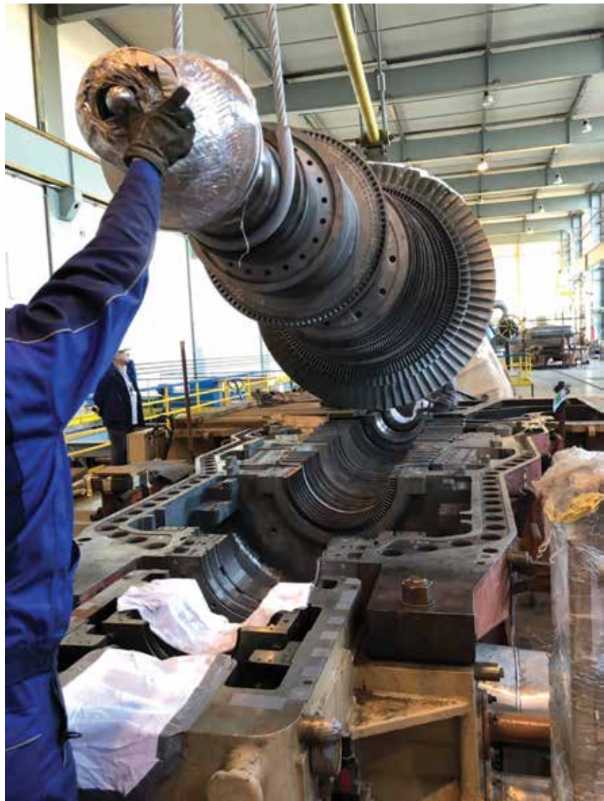
↑ Rotor parne turbine prije montaže u kućište turbine
