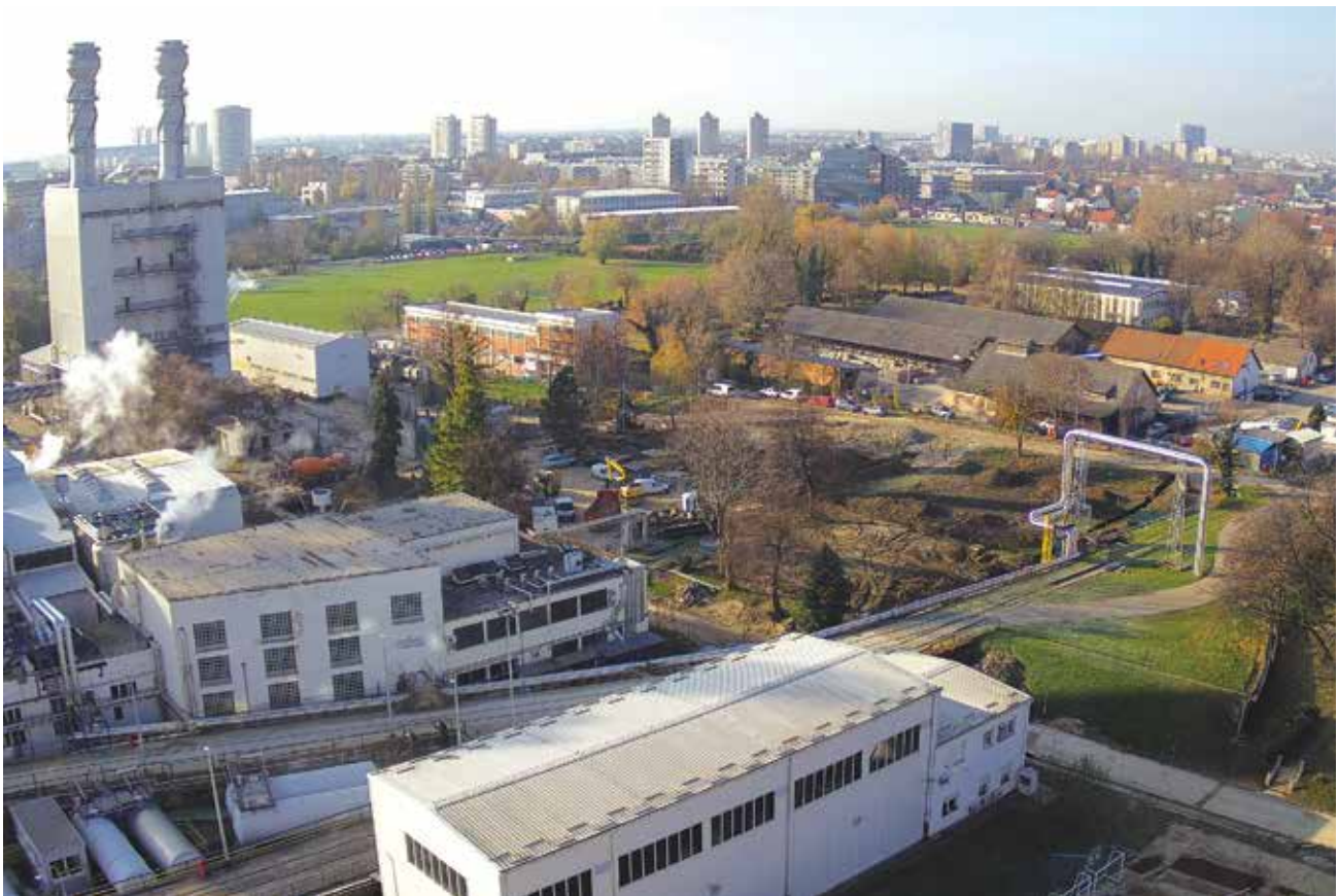
↑ Pripremljeno je mjesto za novo postrojenje te se priprema priključak za njegovo spajanje na postojeću infrastrukturu
