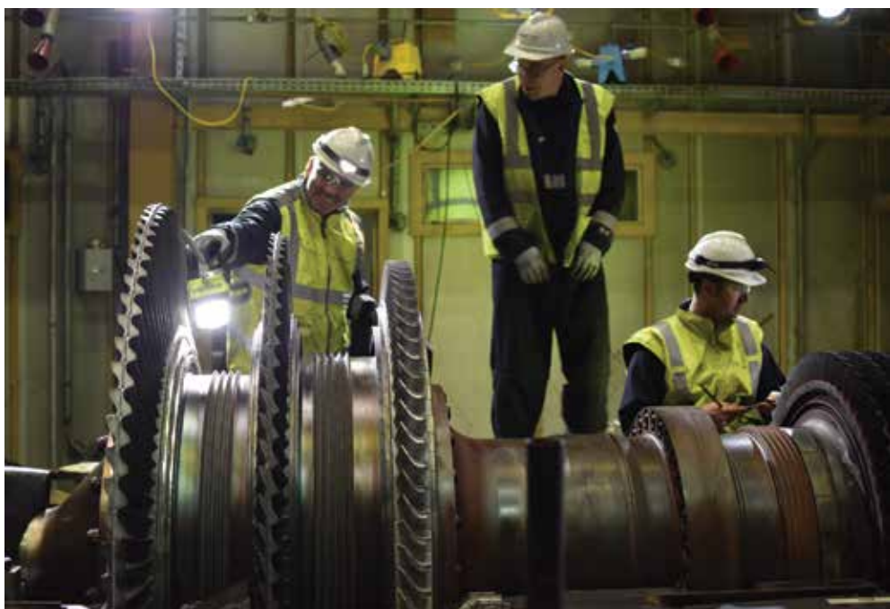
↑ Radovi na remontu plinske turbine Bloka L
