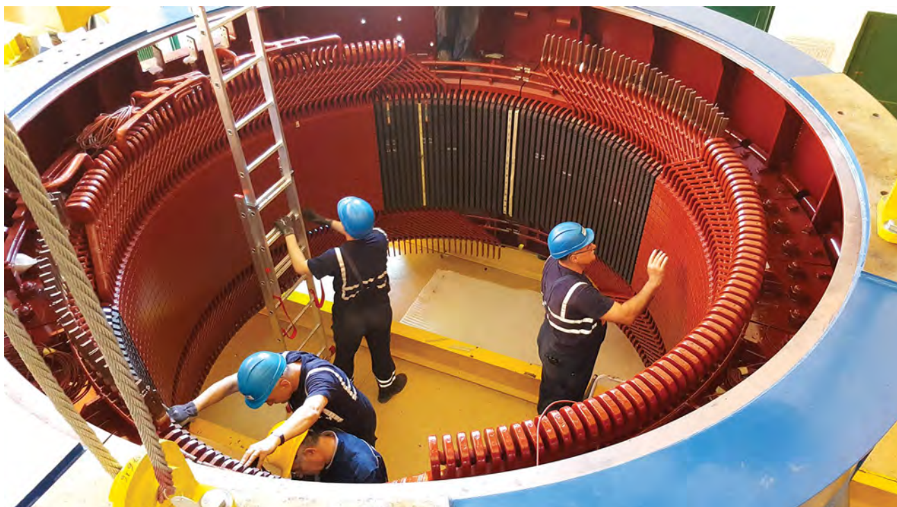
↑ Spajanje statora u jednu cjelinu u strojarnici HE Gojak
