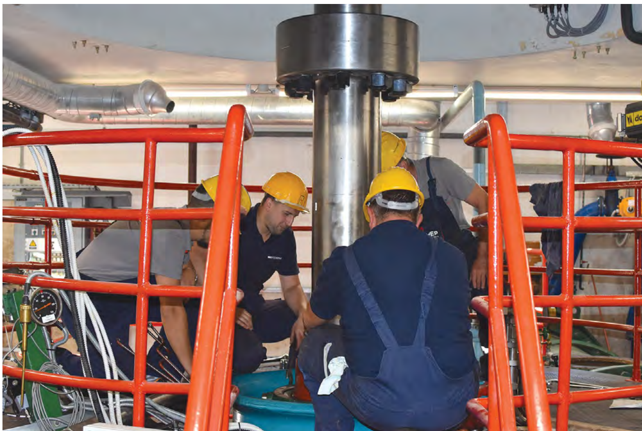
↑ Remontni radovi u Crpnoj hidroelektrani Fužine
