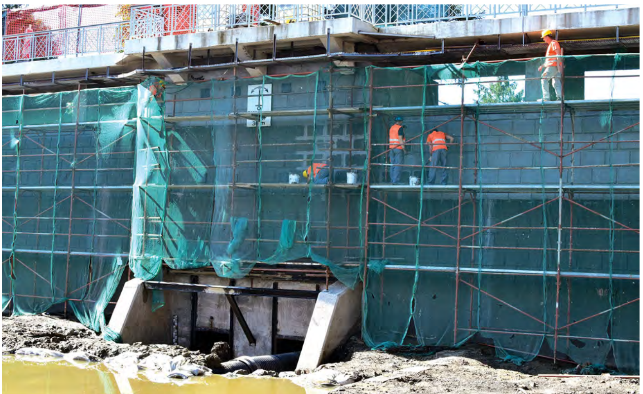
↑ Sanacija uzvodnog lica brane Bayer
