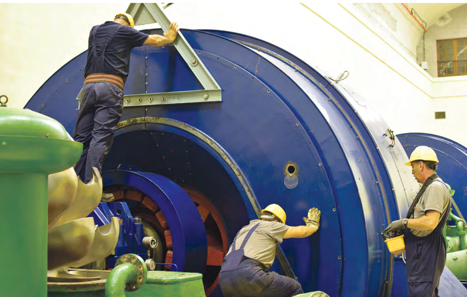
↑ Montaža kućišta generatora agregata C u HE Vinodol
