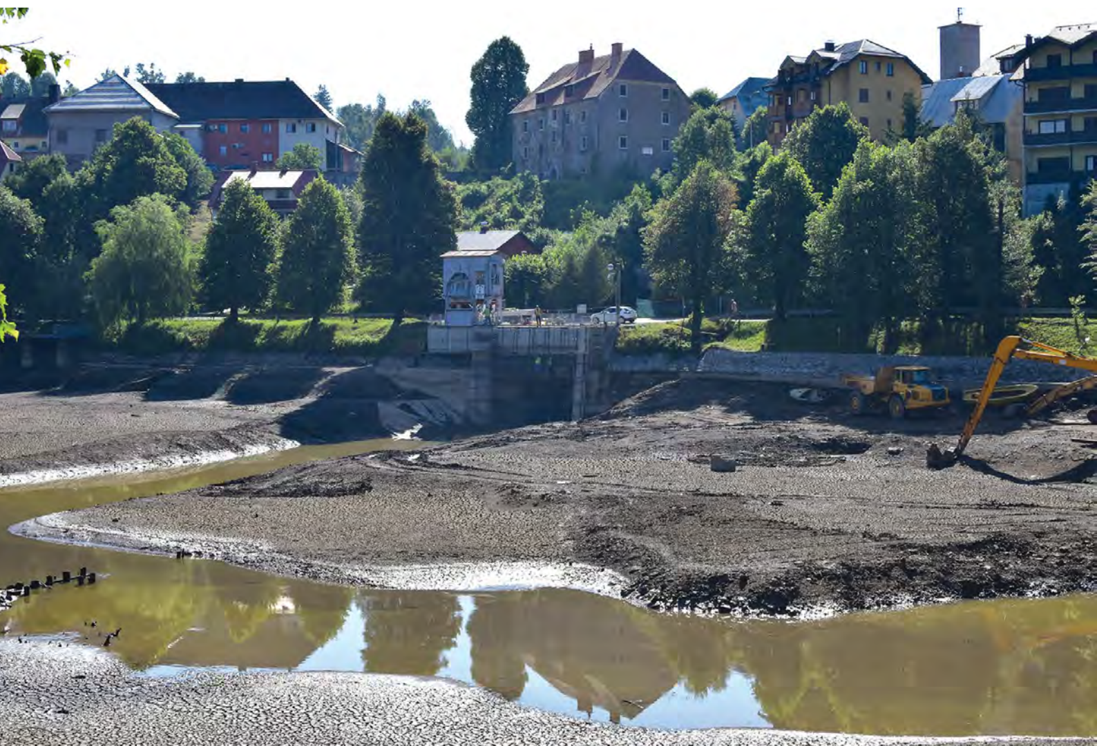
↑ Sanacija ulazne građevine koja vodi od Bajera prema HE Vinodol
