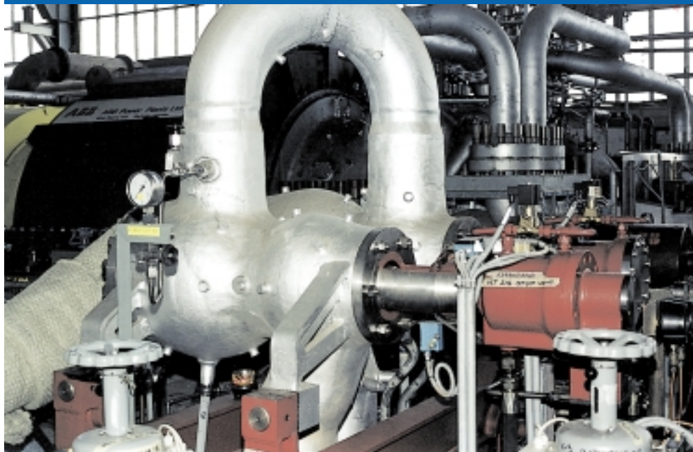
Ventil na niskotlačnoj pari iz kotla utilizatora
