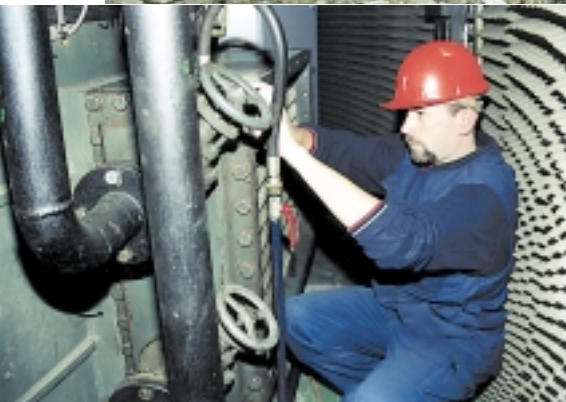
Nenad Šćuric: čišćenje hladnjaka generatora
