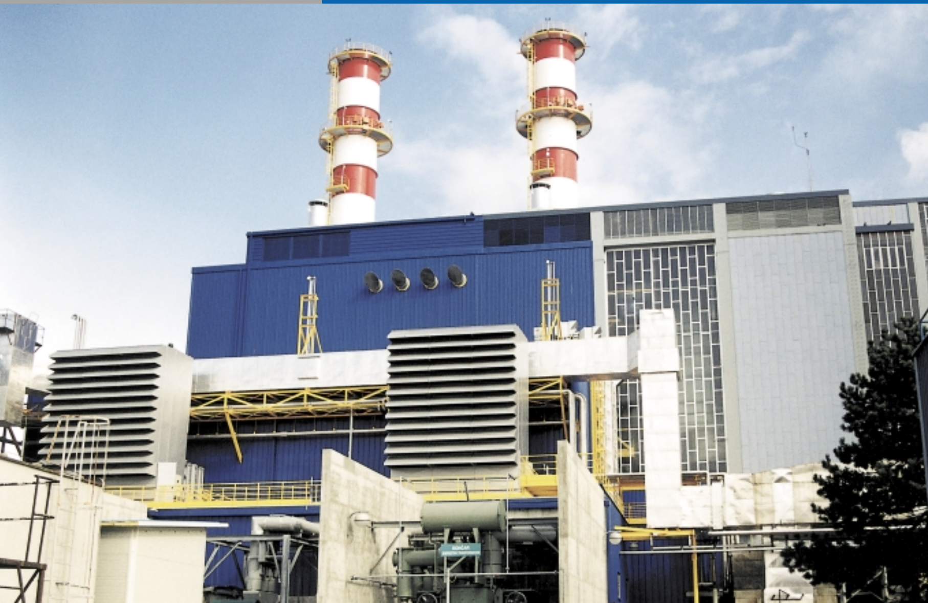
Novo postrojenje – plinski turbinski agregati, naslanja se na staro
