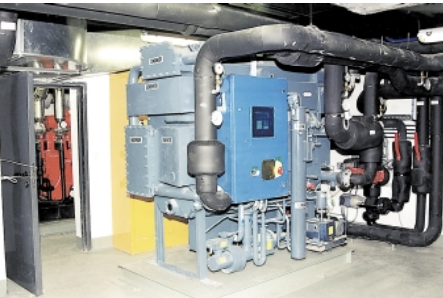
Sustav grijanja, ventilacije i klimatizacije: toplinska podstanica...
