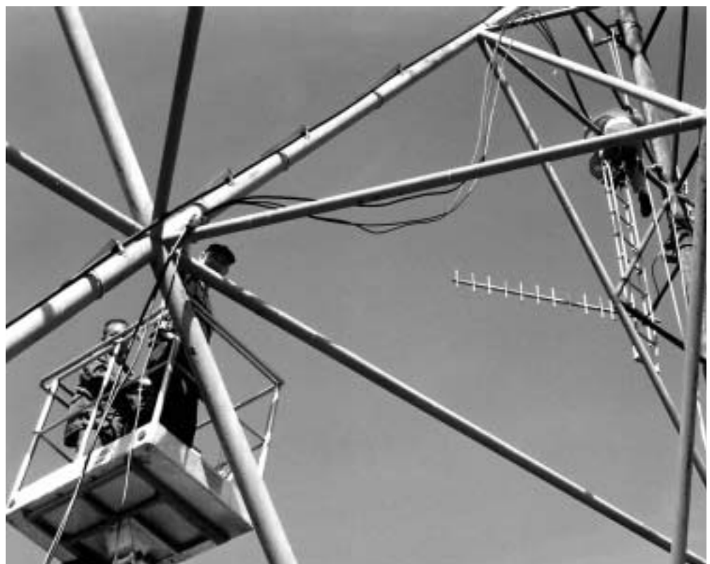
Montaža antena na antenskom stupu Košarevac - u košari Dario Lovreković i Željko Barić, radnici DP Elektra SlavonSKI Brod, a na stupu Antun Dretvić iz tvrtke "Komteh"
