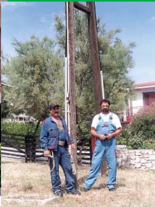
Josip Kurilić i Goran Tauzer promijenili su spojnice na A stupu
