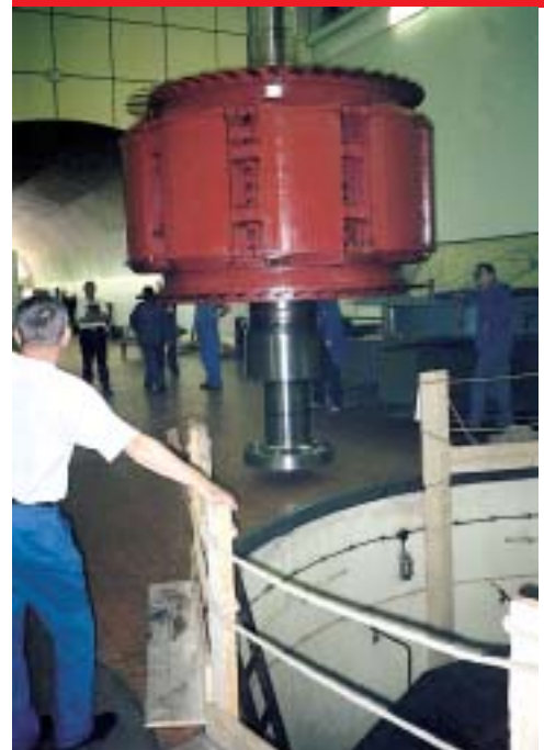
Vađenje sklopa radnog kola i turbinske osovine u HE Rijeka
