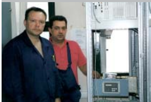
O ugradnji novih sinkronizatora za agregat u HE Gojak pobrinut će se Zvonimir Lipovšća i Branko Puškarić
