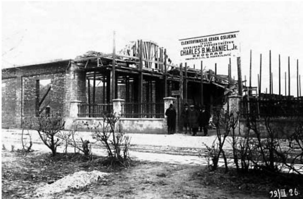
Stanje na gradilištu 19. ožujka 1926. godine
