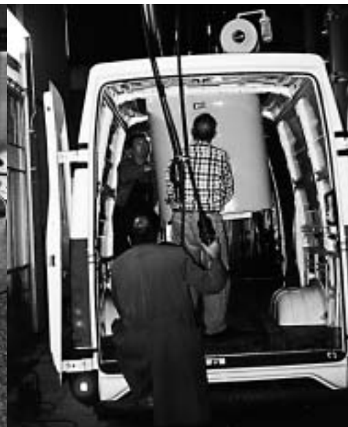
Ispitni transformator u novom ruhu - ugradnja u novo vozilo
