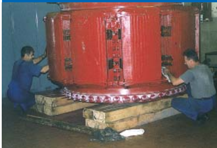
Radnici MG Servisa uređuju rotor generatora agregata 2 u HE Rijeka
