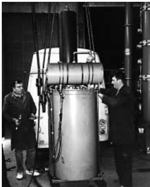
Radovi su počeli - srce ispitne stanice predstavlja visokonaponski ispitni transformator (250 V/200 000 V, snaga 50 kVA)
