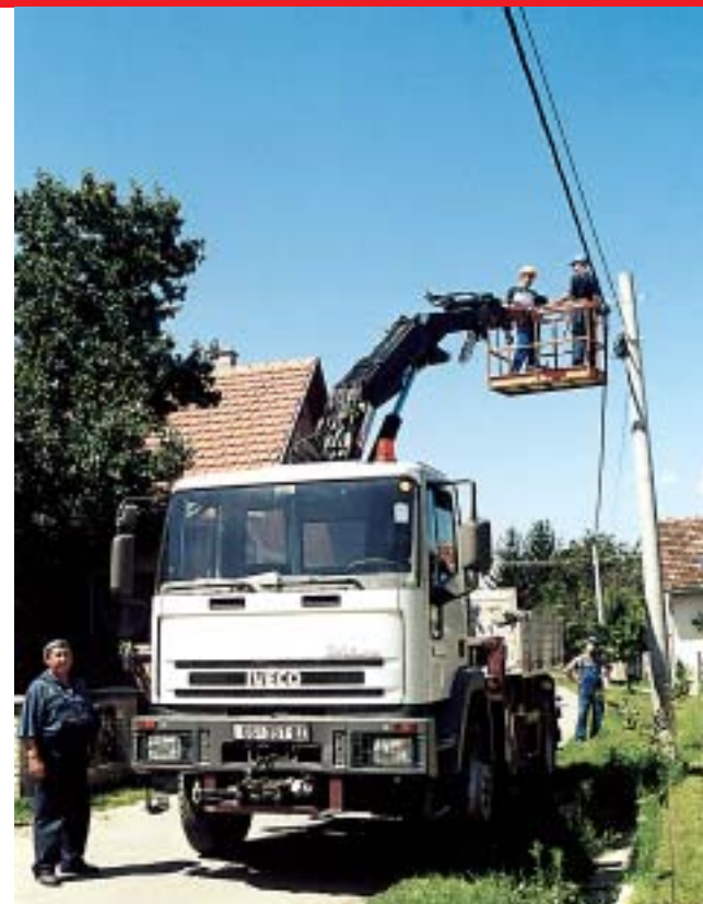
Monteri Elektroslavonije Osijek na djelu u Aljmašu
