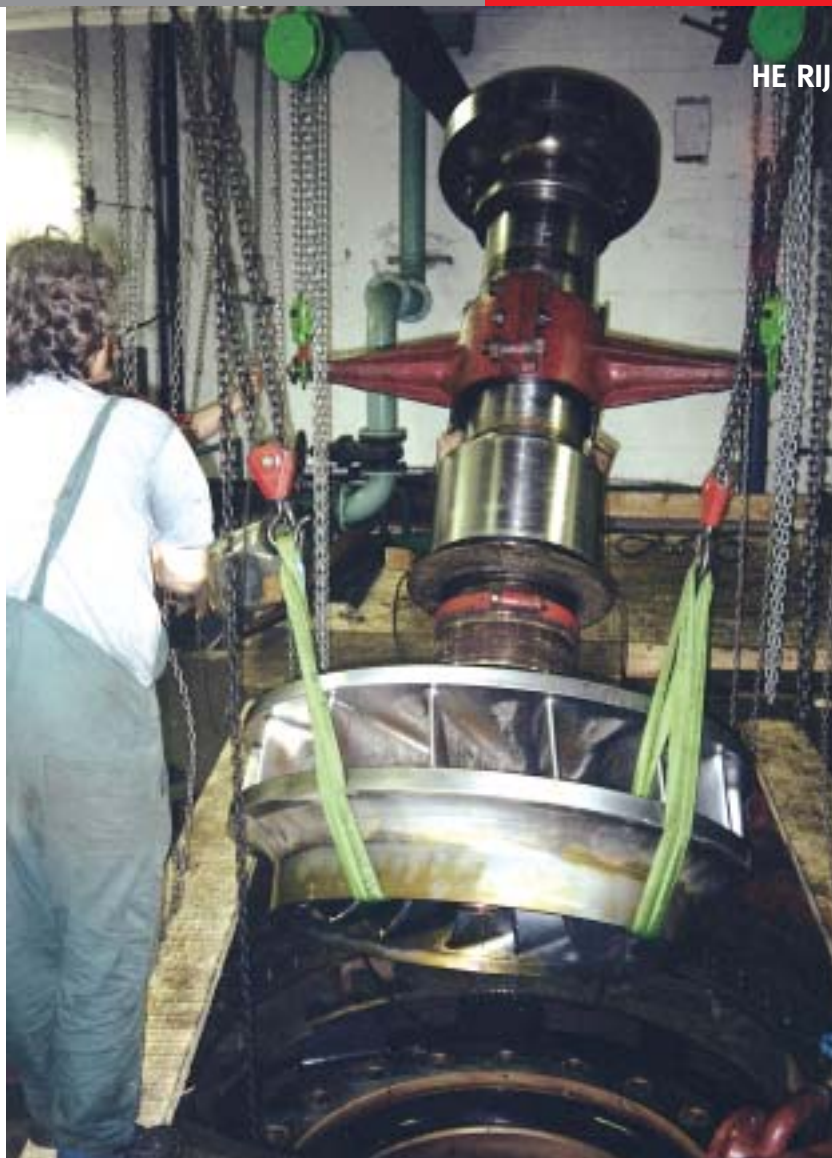
Vađenje rotora generatora agregata 2 u HE Rijeka
