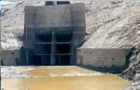
Kroz ovaj otvor jezero putuje u ponore, a kada se on zatvori rječica Lokvarka se pobrine za ponovno punjenje 35 milijuna prostornih metara vode, koliko stane u jezero i koliko popije hidroelektrana za samo četiri mjeseca rada
