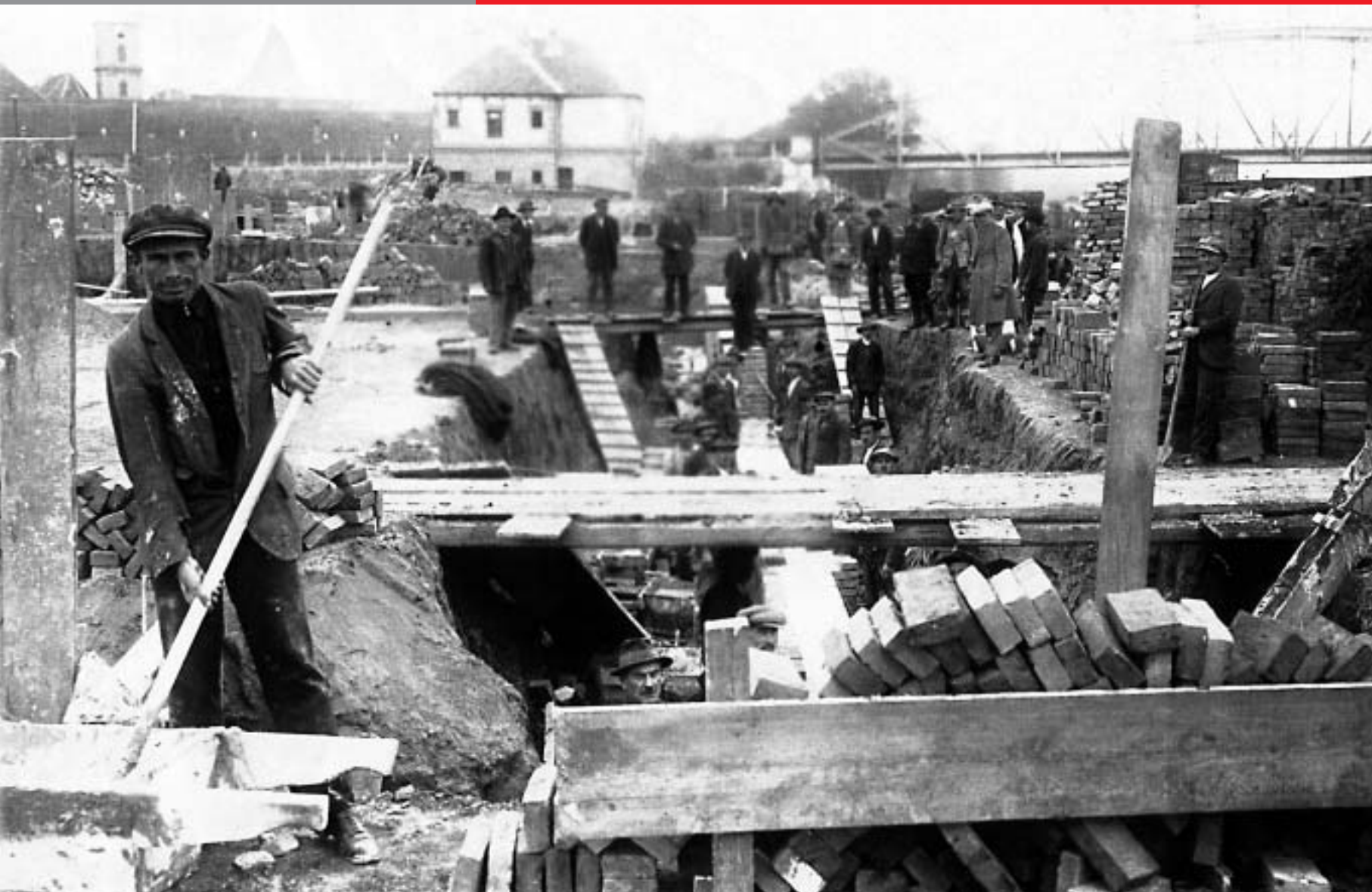
Početna etapa izgradnje Elektrane
