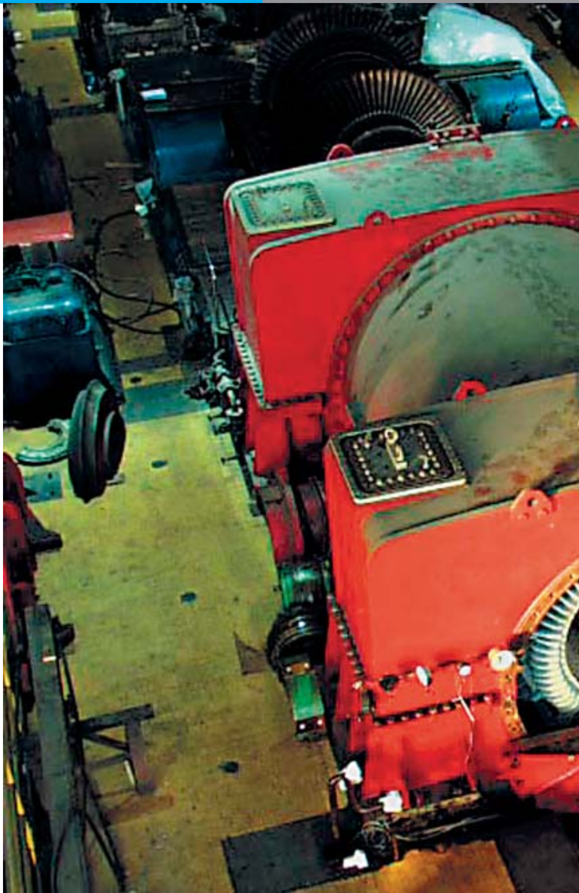
Generator turbine prije remonta - izvlačenje rotora
