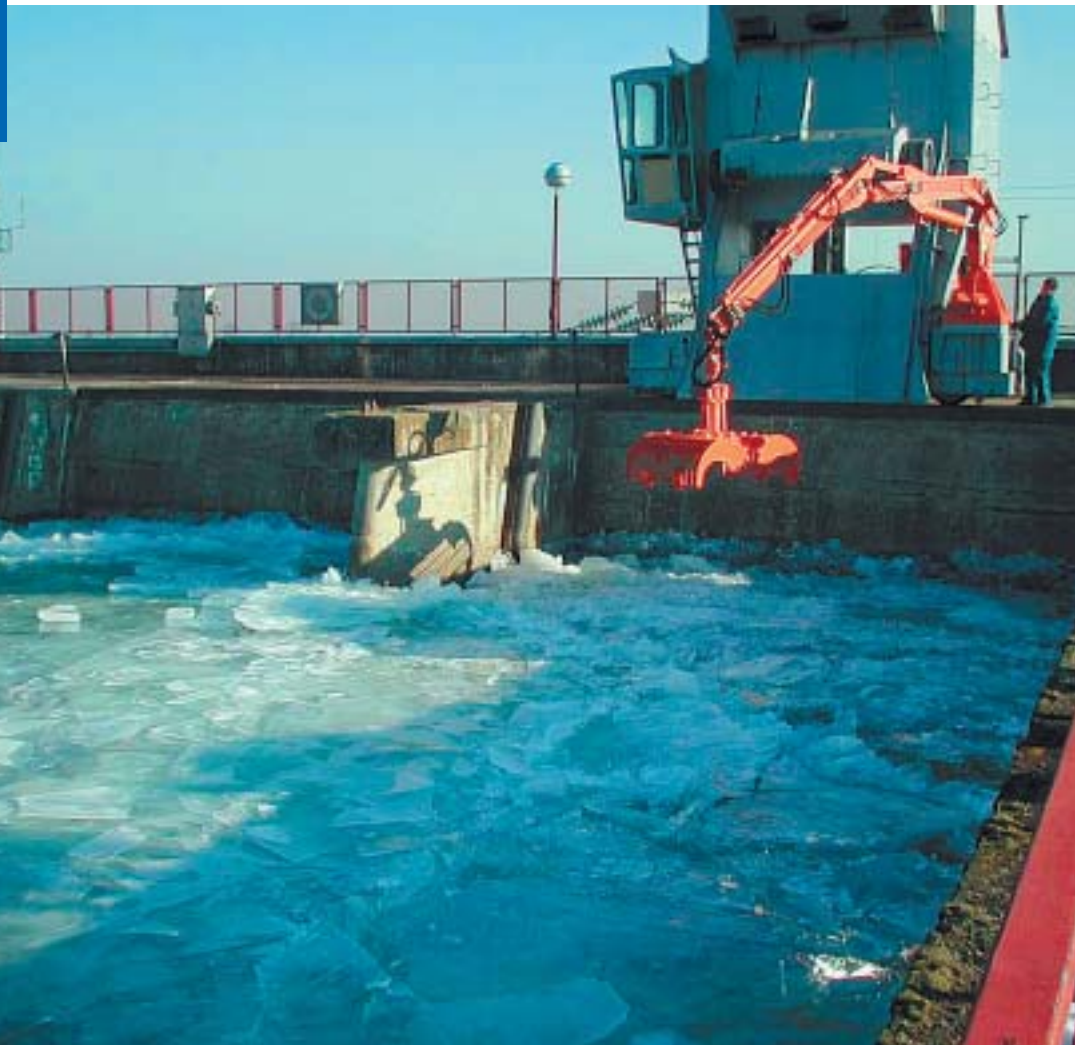
Led je zarobio HE Varaždin prvog dana remonta
