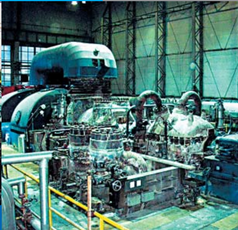
S turbine je skinuta izolacija, pa remont može početi
