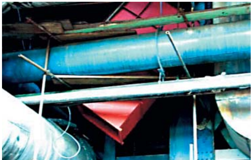
Jedan od važnih poslova tijekom remonta TE Plomin 1 bila je i zamjena kanala toplog zraka za mlinove ugljena
