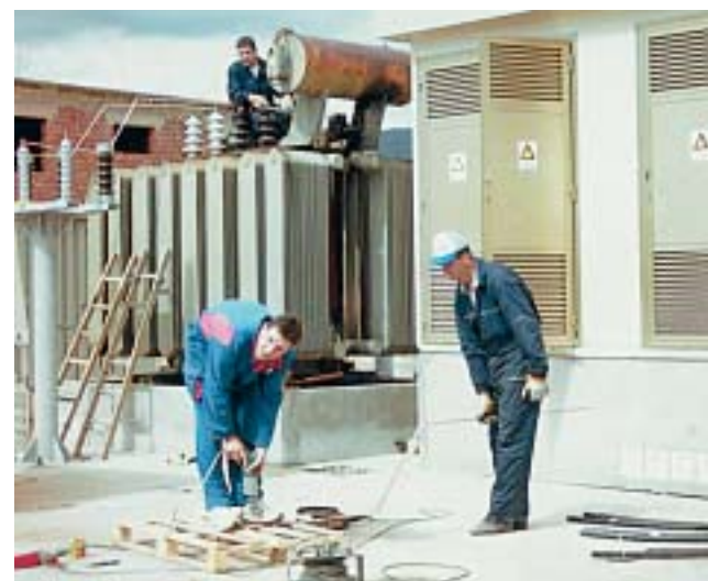
Uređuje se provizorno postrojenje 35/10 kV koje će prihvatiti dio potrošnje za trajanja obnove TS Sinj 1
