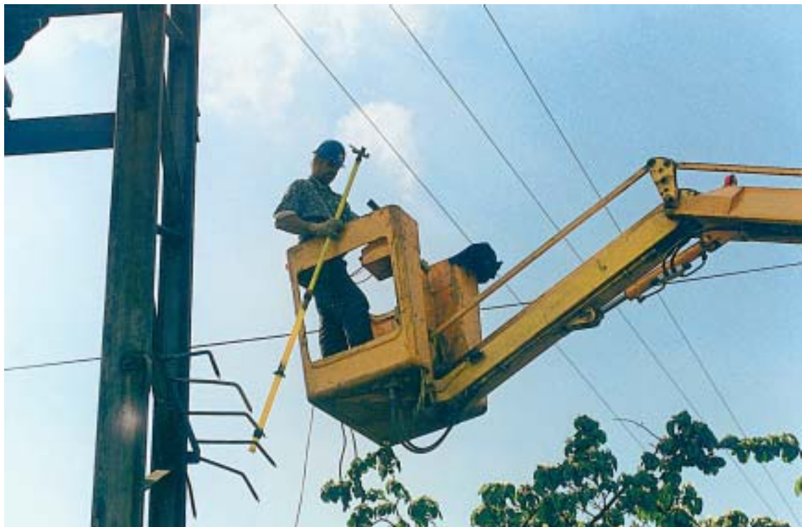
Darko Moher skida visokonaponsko uzemljenje
