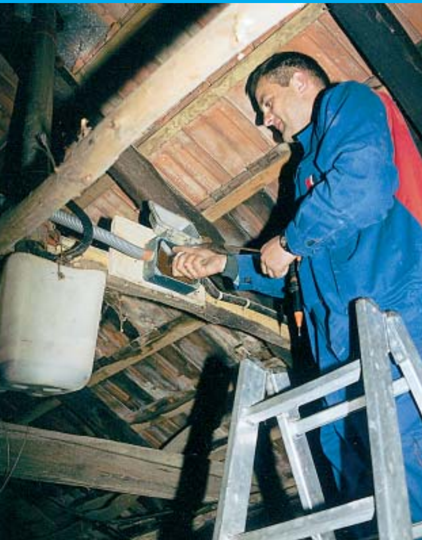
Danijela Božu, montera Pogona Virovitica, snimili smo na tavanu jednog potrošača u selu Novaki, pri rekonstrukciji glavnog voda
