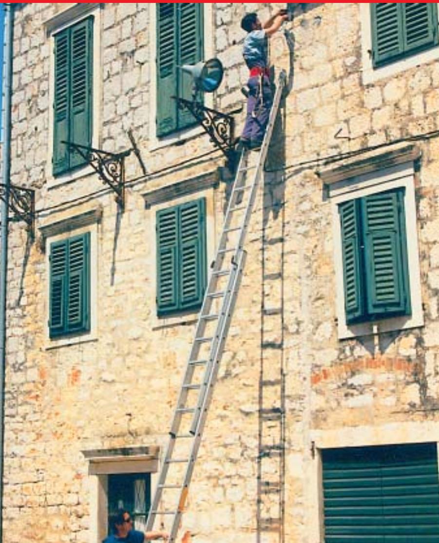
Nikola Franetović i Robert Barić skidaju stare zračne priključke i postavljaju November
