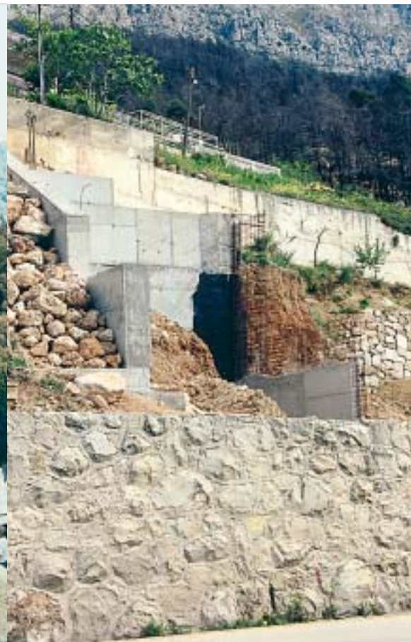
Nakon osiguranja tla, uskoro će niknuti TS Ruskamen 3
