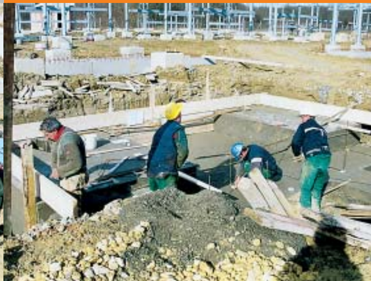
Radovi na temelju drugog transformatora 20 MVA
