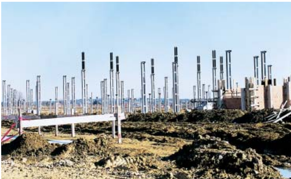
Montirani potporni izolatori za 400 kV sabirničke sustave
