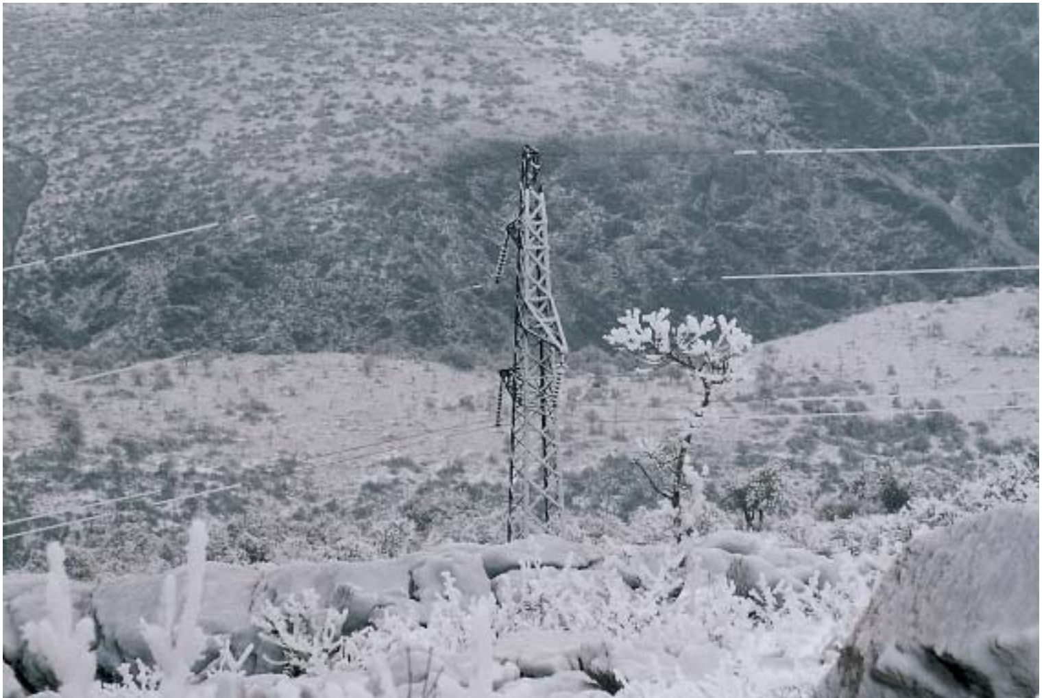
Snježnoledeni prizor sa stupom DV 110 kV Obrovac - Gračac
