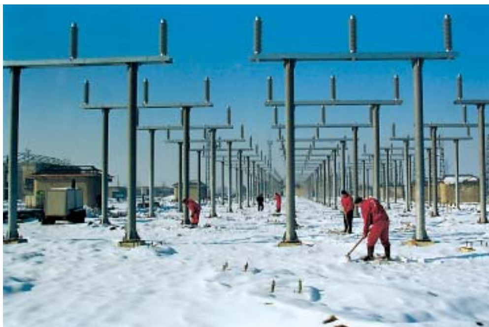
Priprema temelja postolja za bušenje
