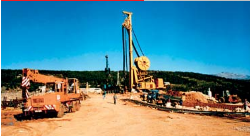
Kran-gusjeničar posebno je konstruiran za opsluživanje rezača, a postavljen je tako da se kreće usporedno s rovom za dijafragmu
