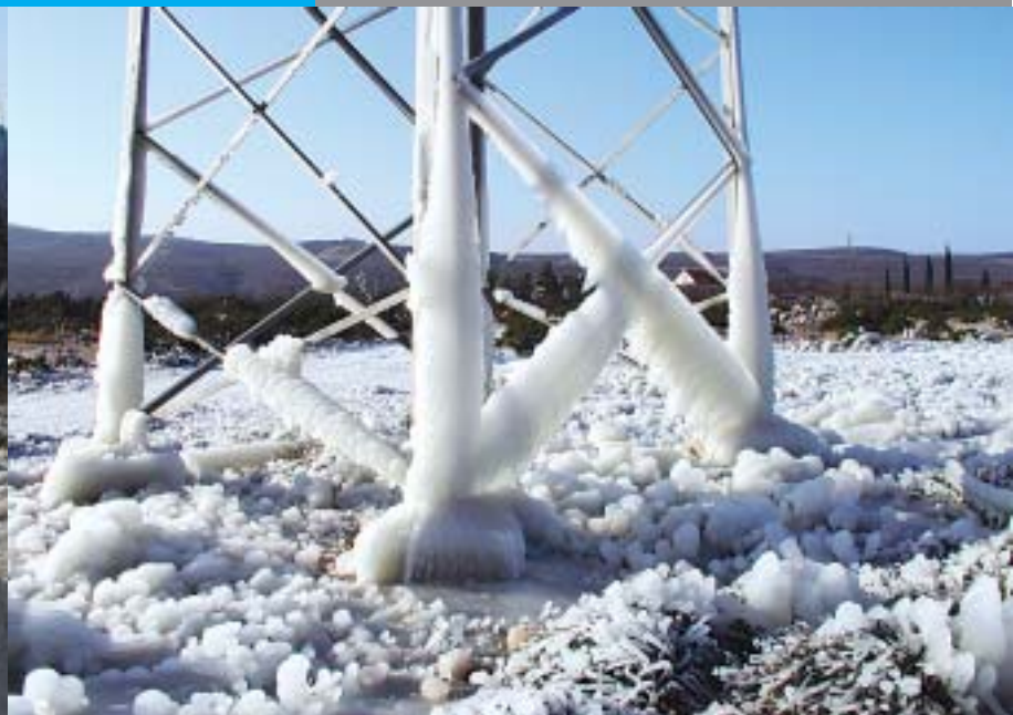
Led na čelično-rešetkastom stupu
