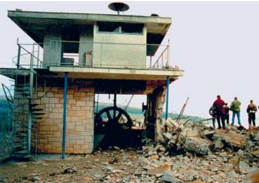
Eksplodija je inicirana klasičnim uređajem, a s obzirom da su rušitelji bili sigurni u uspjeh, nisu minirali okolne dijelove
