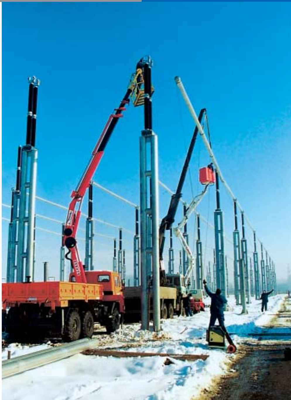
Montaža cijevi glavnih 400 kV sabirnica
