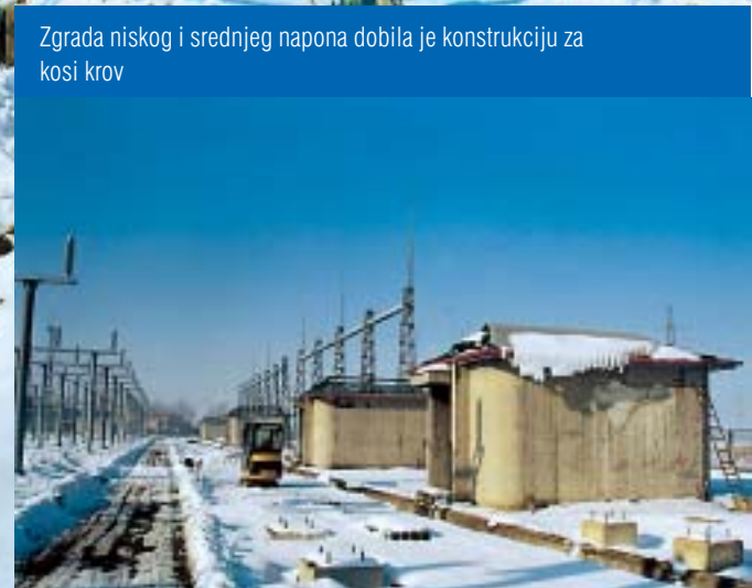
Montaža pokrova relejnih kućica zbog zime i snijega priremeno je prekinuta
