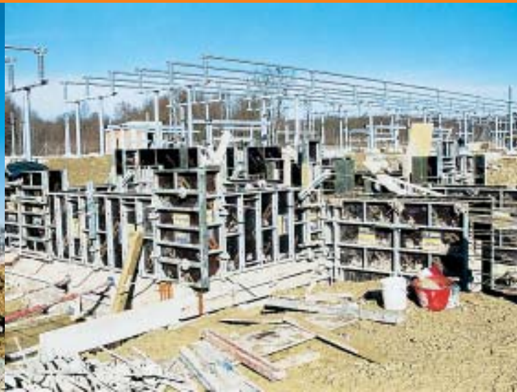
Temelj transformatora 20 MVA i..
