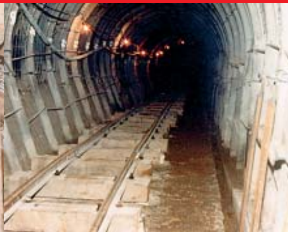
Galerija je osigurana podupiranjem čeličnim lukovima
