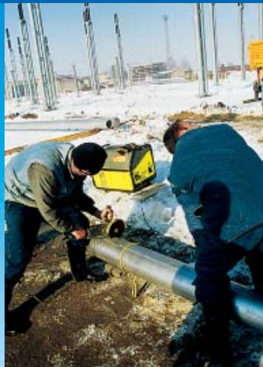
Sabirničke cijevi pripremaju se na tlu
