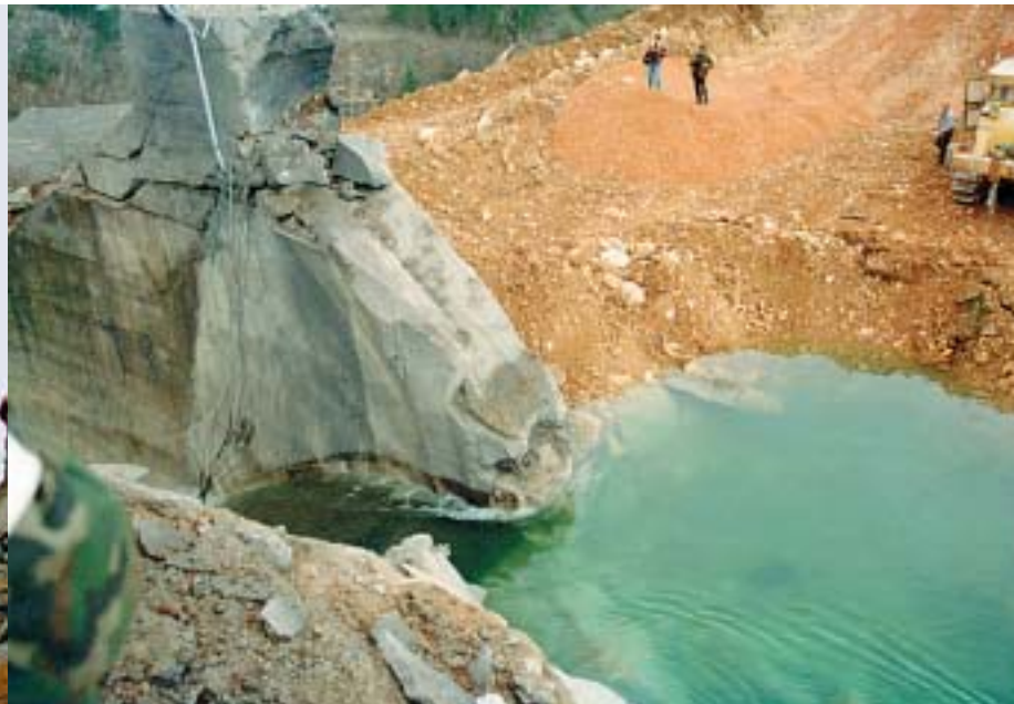
Više od 30 tona eksploziva postavljeno je znalački, srušen je preliv, spoj brane s prelivom, a desni zid namjerno su ostavili čitavim, kako bi držao zatvorenim zatvarač koji je čuvao "vodenu bombu"
