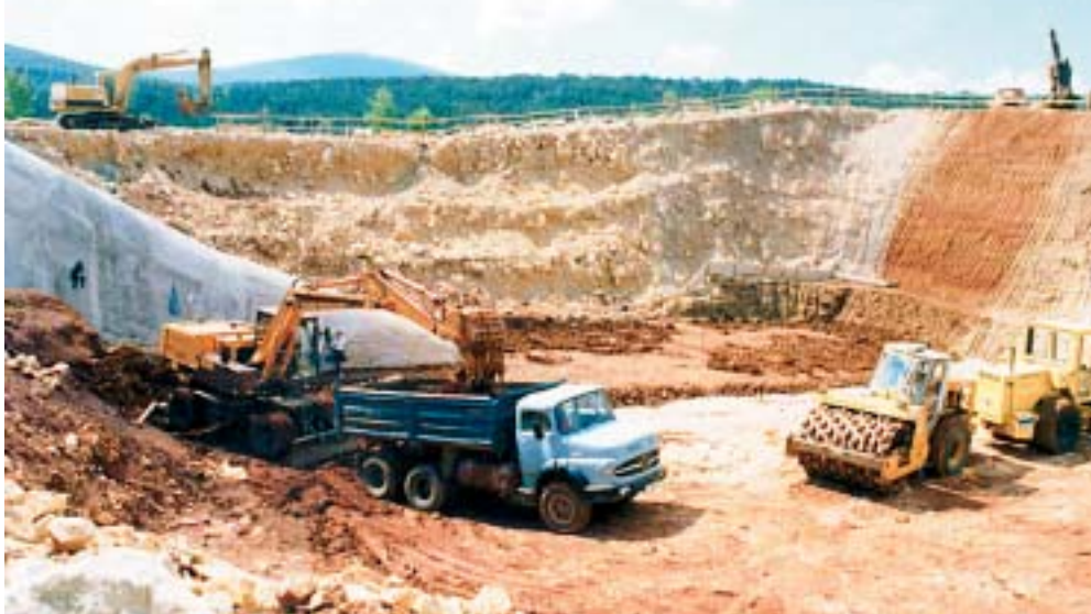
Ukupno je iz tijela brane iskopano i odvezeno 124.672 m 3 gline, filtarskog i kamenog materijala, što je 14 posto njezina ukupnog volumena
