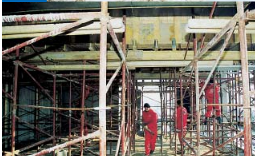
Nakon betoniranja rastavljaju se skele
