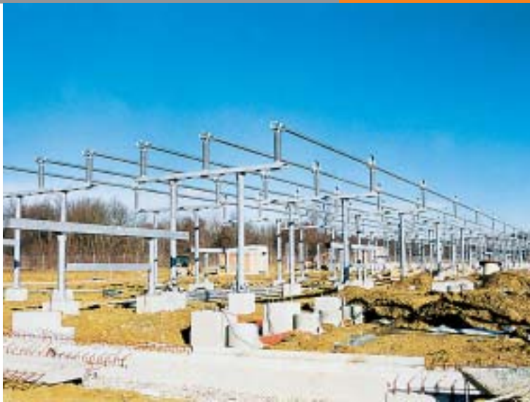
Montirane 110 kV sabirnice
