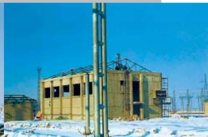
Zgrada niskog i srednjeg napona dobila je konstrukciju za kosi krov
