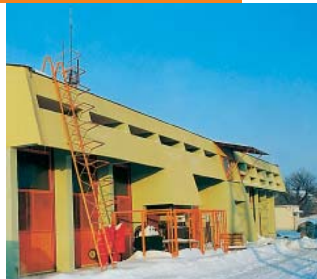
Tijekom prošlogodišnje rekonstrukcije sanirana je i zgrada TS Zdenčina
