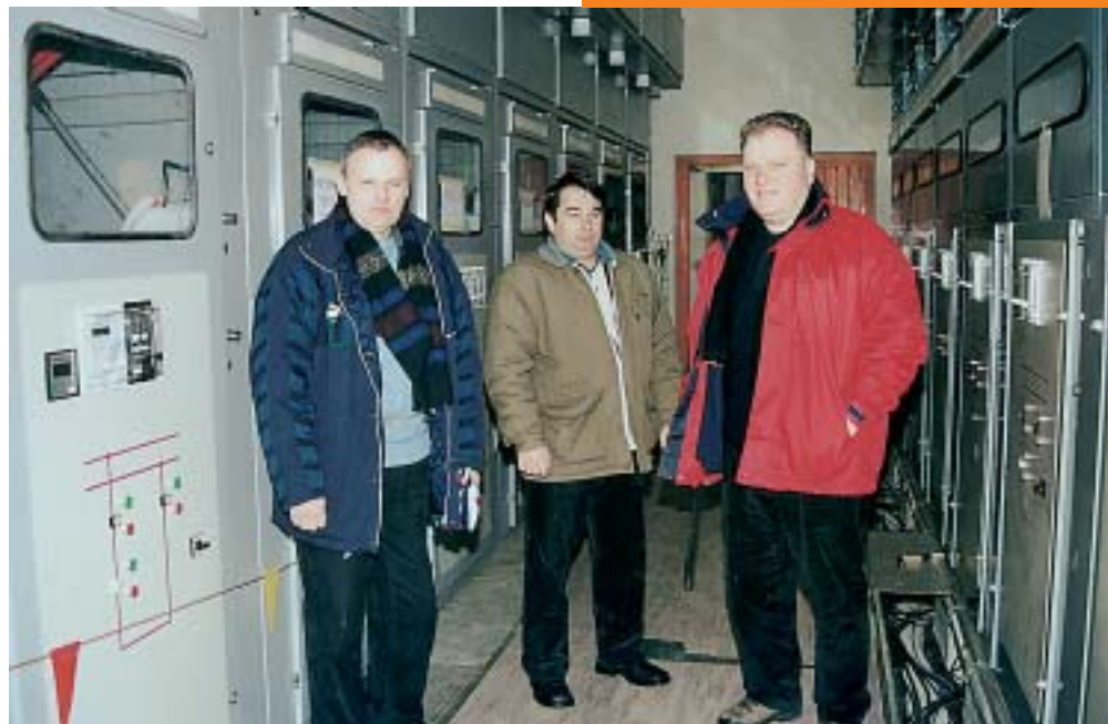
Boris Ožanić, rukovoditelj Odjela održavanja, Josip Kekić, nadzorni inženjer i Dubravko Dragovoljac, koordinator u Odjelu održavanja u rekonstruiranom 20 kV postrojenju TS 110/10 kV Zdenčina
