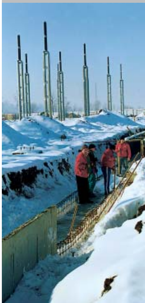
Obnova kableskih kanala bez obzira na studen
