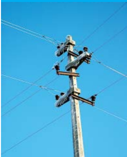
Led na odcjepnom 10 kV stupu
