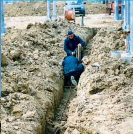
... na polaganju uzemljivača 400 kV
