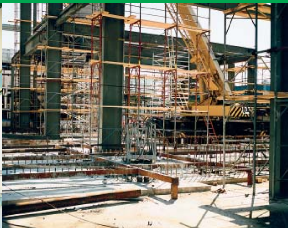
Spajanje starog i novog - noseća konstrukcija kotla
