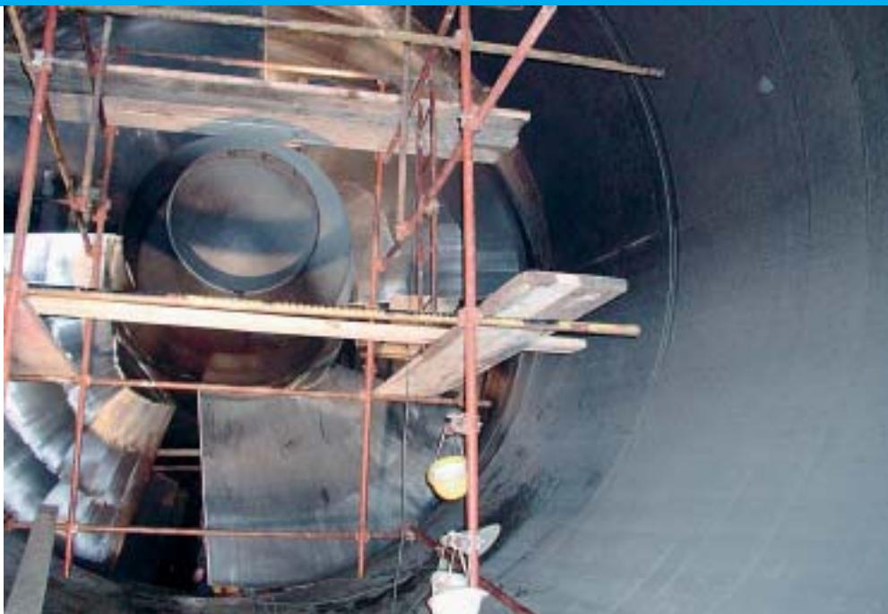
Poliranje radnog kola prigodom remonta u HE Čakovec
