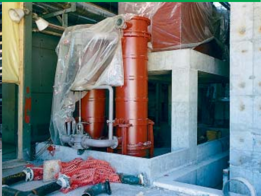
Dio uljnog postrojenja
