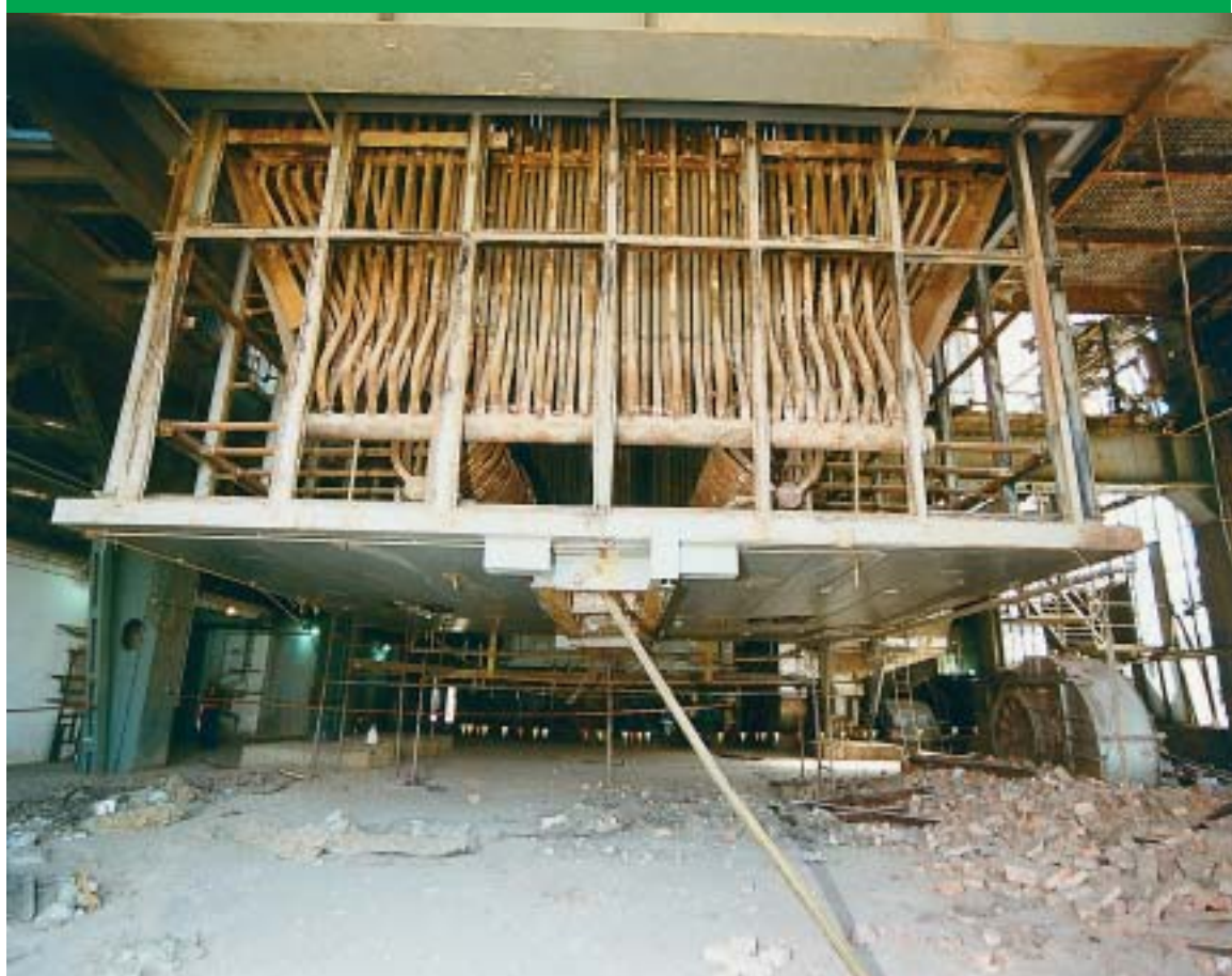
Započelo je rezanje starog kotla postrojenja 32 MW
