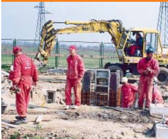
Dovršava se još nekoliko novih temelja nosača aparata u 110 kV postrojenju
