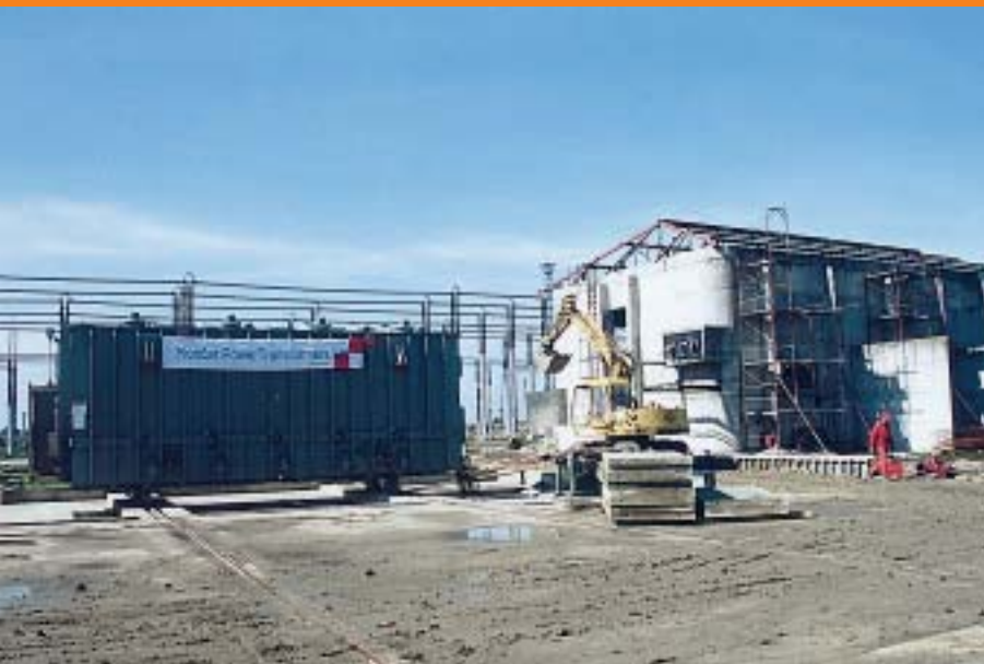
Prvi transformator je postavljen na svoje mjesto
