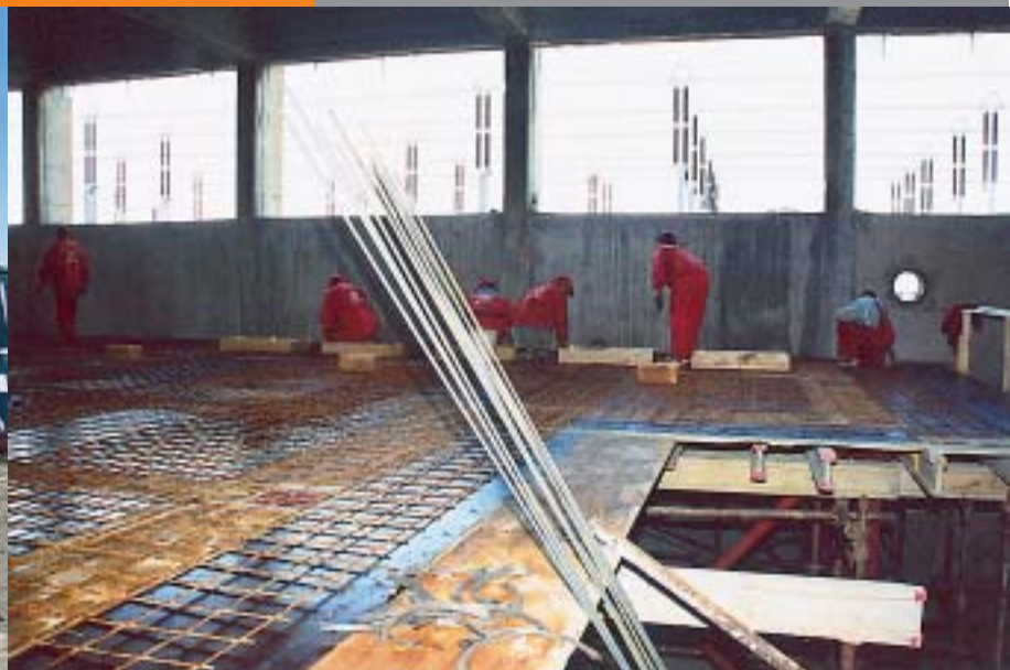
Gradi se gornja galerija u zgradi srednjeg i niskog napona
