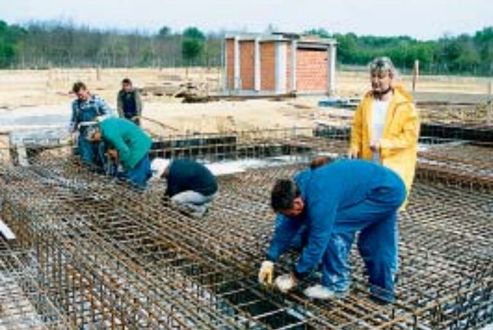
Višnja Mešić nadzire radove radnika ARGIT-a na temelju transformatora 400/220 kV
