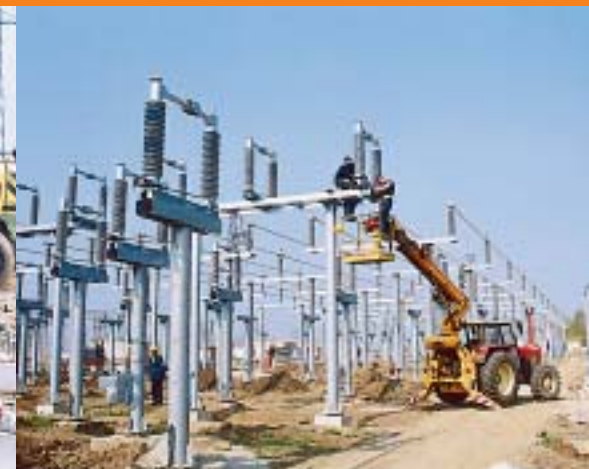
Postavljanje rastavljača u postrojenju 110 kV
