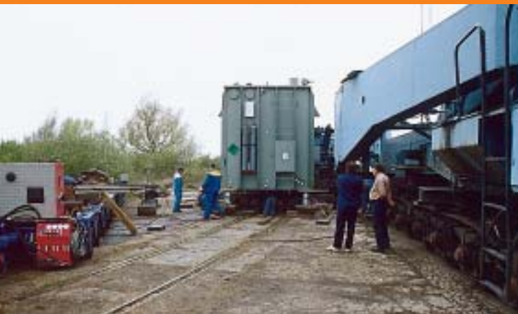
Pretovar drugog transformatora iz vlaka na posebno cestovno vozilo, tzv. labudicu
