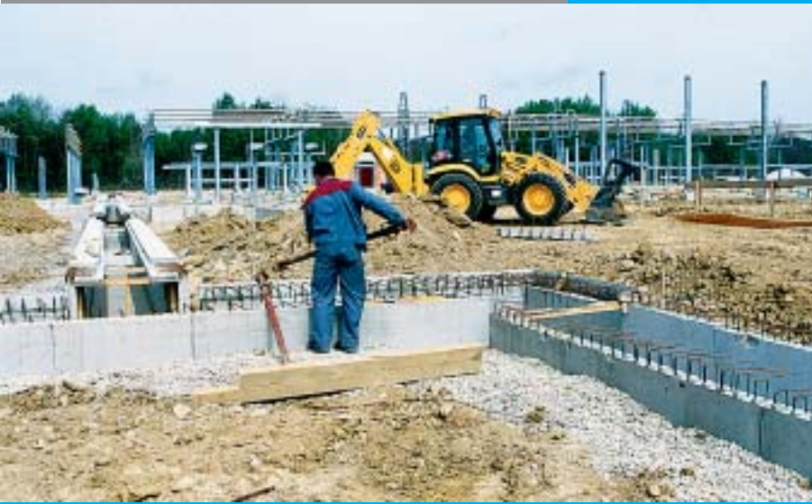
Izrađen je spoj kablskih kanala 110 i 400 kV postrojenja...
