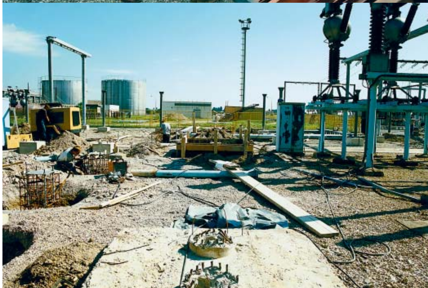
Rasklopište nakon demontaže starih 110 kV sabirnica
