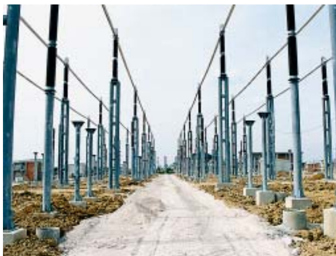
Izgradnja prometnica za lakši pristup postrojenju
