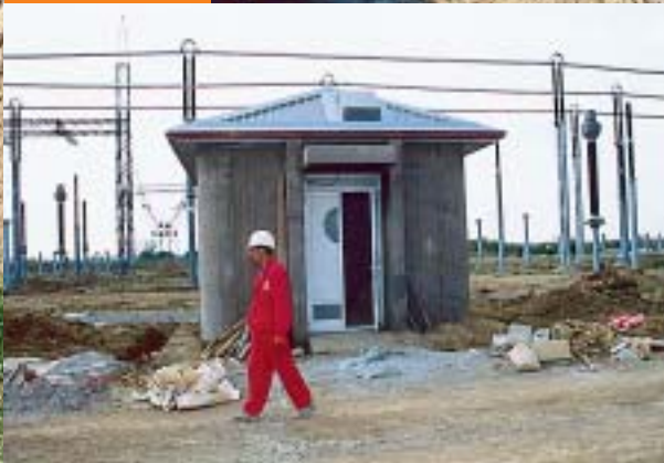
Sve stare relejne kućice već su obnovljene
