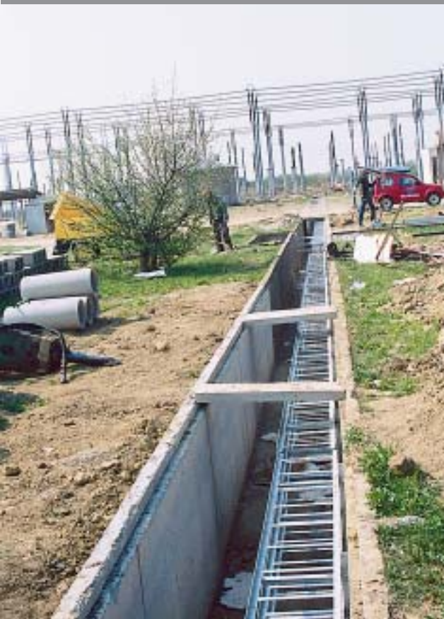
Završeni su skoro svi kabelski kanali
