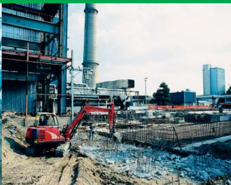
Temelji za strojarnicu plinske turbine
