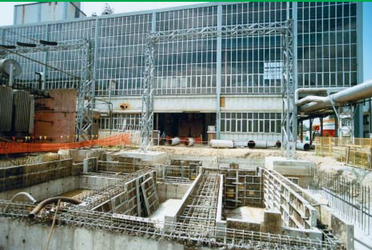
Priprema sabirničkih jama za ulje za ulje novog transformatora novog postrojenja
