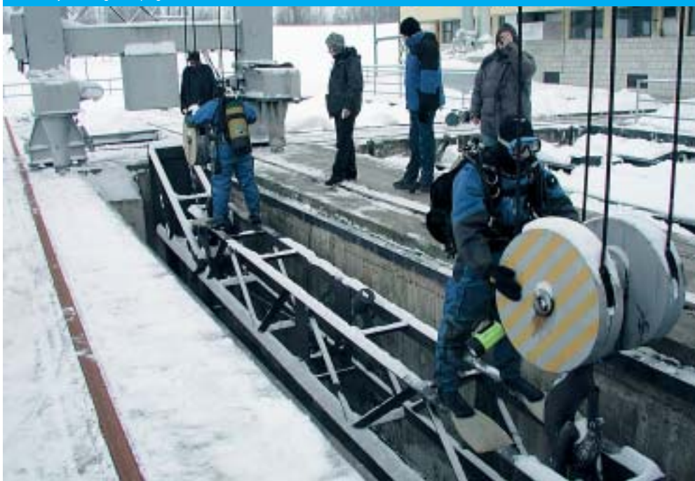
Pregled pragova nizvodnog remontnog zatvarača
