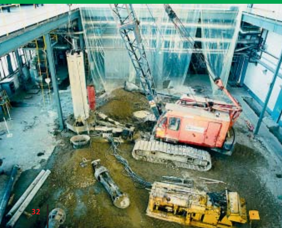
Izrada pilota za temelj parne turbine
