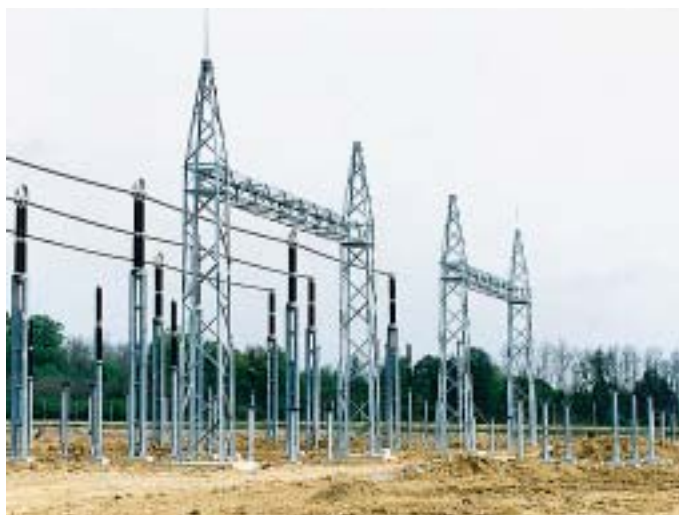
Montirani su portali za prihvat 400 kV dalekovoda Heviz 1 i Heviz 2, kao i...
