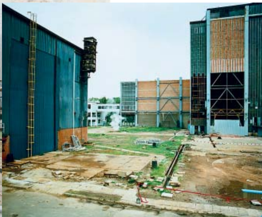
Priprema se prostor za novo postrojenje
