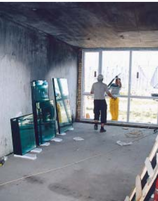
Ugrađuje se PVC stolarija u upravljačkoj zgradi i...
