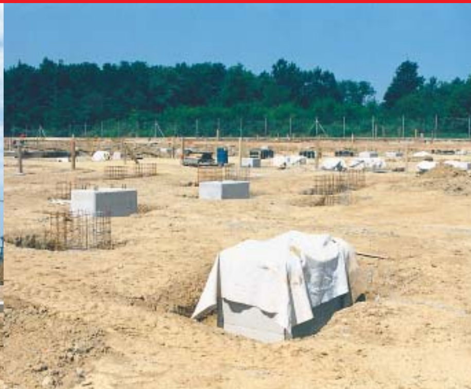
U postrojenju 220 kV od 153 temelja aparata dovršeno je 137
