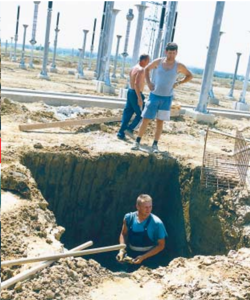
U postrojenju 400 kV u tijeku su radovi na temeljima rasvjetnih stupova
