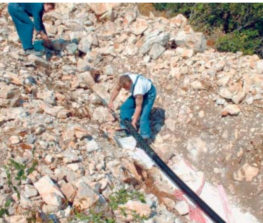
Priprema podmorskog kabela
