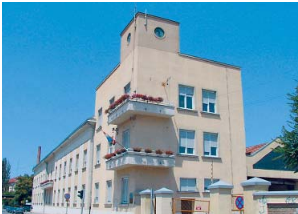
Zgrada HEP Plina u Osijeku izvana na neumoljivom ovogodišnjem lipanjskom suncu, ali unutra je temperatura vrlo ugodna zahvaljujući klima uređajima, dakako, na plin
