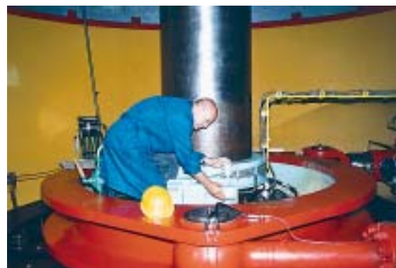
Uklopničar Miro Stančić također je uključen u poslove remonta na kontroli mjernih uređaja turbine 2
