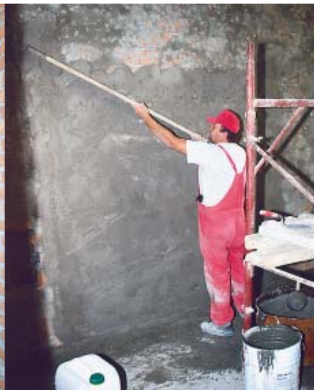
Uredi u upravljačkoj zgradi - u tijeku je žbukanje zidova
