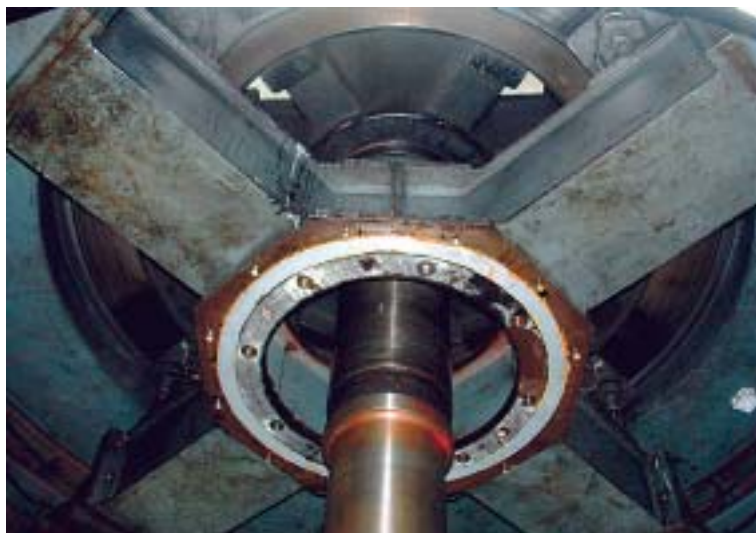
Demontaža generatora CHE Fužine - pogled na rotor s donje strane
