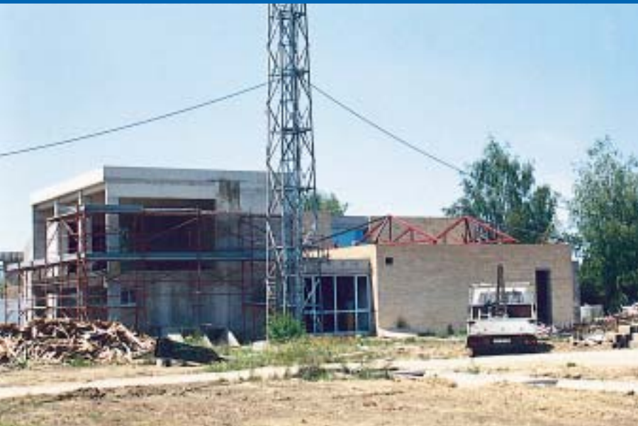
Postavlja se i kosi krov na upravljačkoj zgradi
