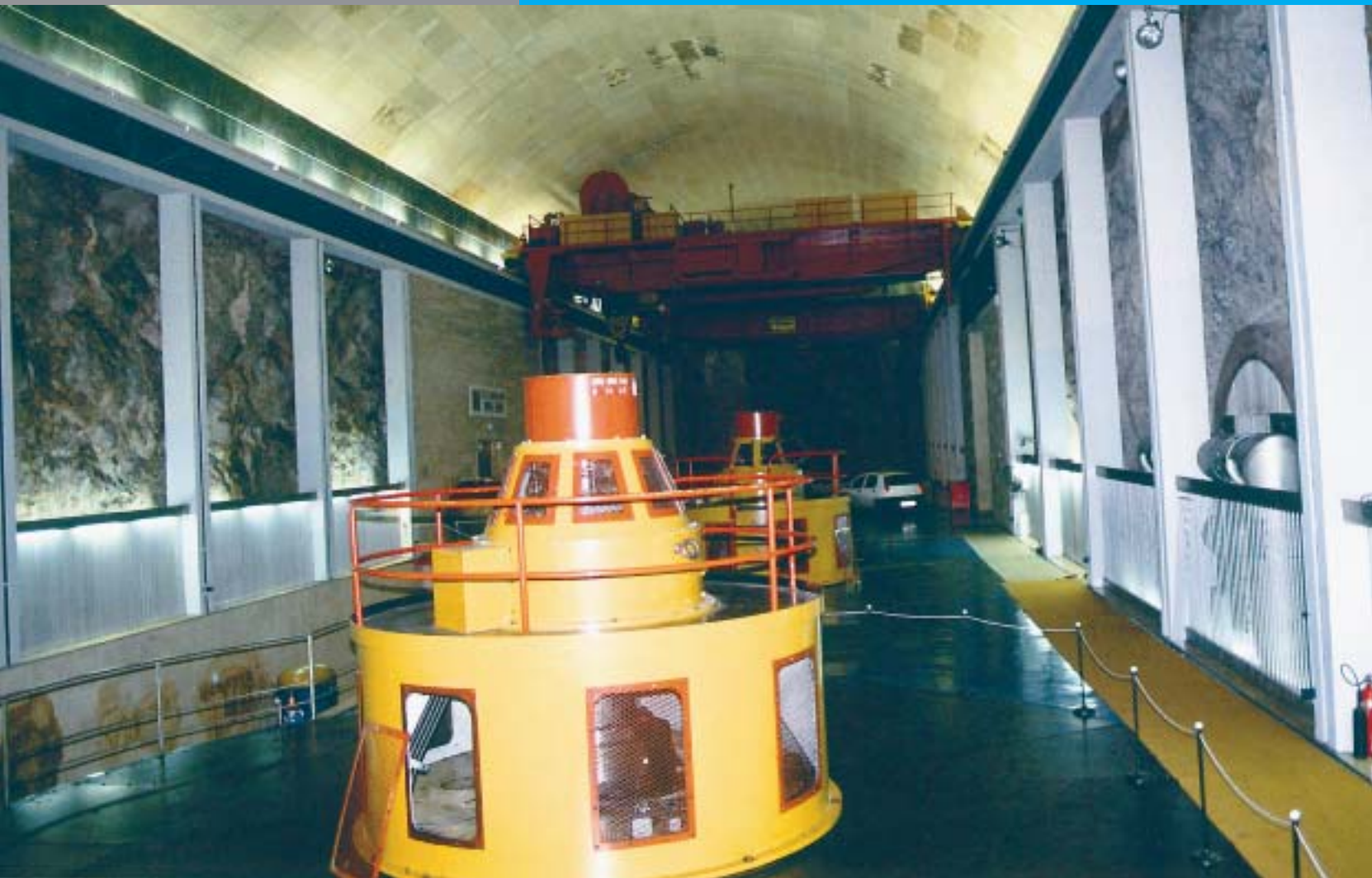
Na prvi pogled čine se da su svi radovi u strojarnici završeni...
