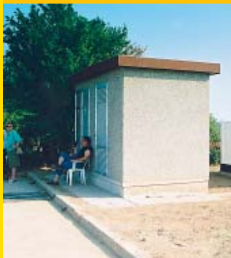
Naši su dežurali ispred nove trafostanice Zračna luka Osijek
