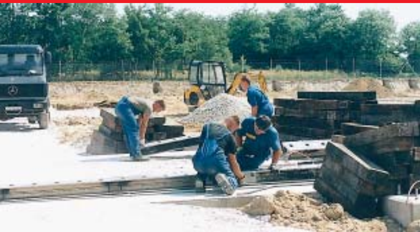
Pripreme za prihvat transformatora 400/220 kV
