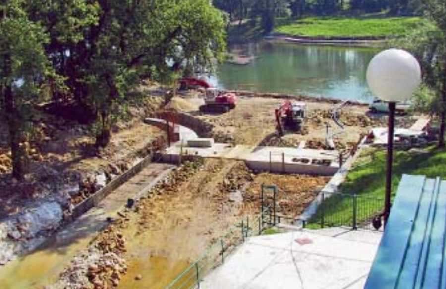
Gradilište nizvodno od HE Ozalj 1, na odvodnom kanalu
