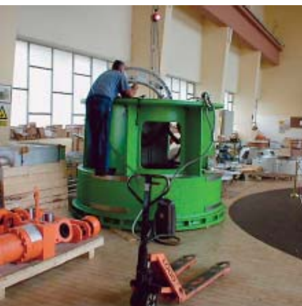
Nova oprema priprema se za ugradnju
