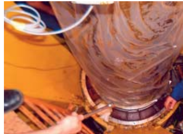
Montaža vodećeg turbinskog ležaja
