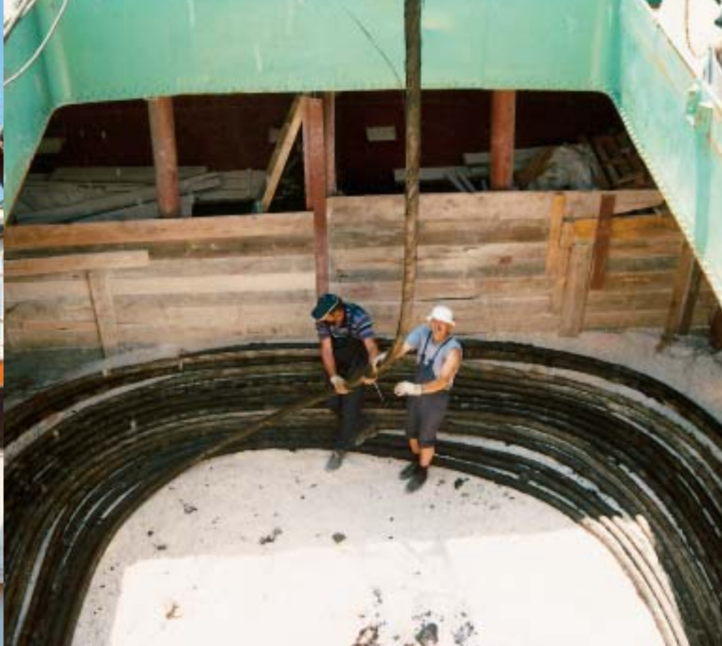
Do večeri na brodu je bilo kilometar i 200 metara kabela izvađenoga iz hvarskog podmorja
