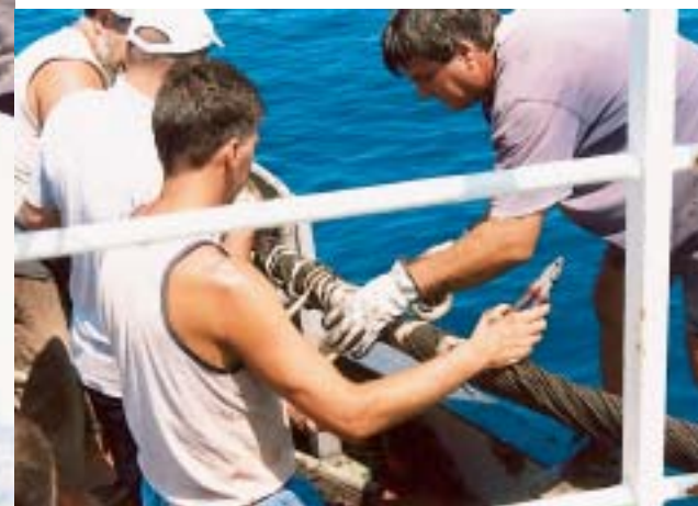
Raščupani kabel trebalo je izgladiti kako bi se mogao povlačiti gusjenicom
