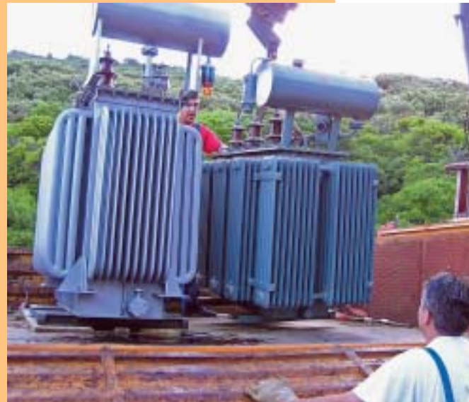
Vedran Toić i Lovro Gregorović, radnici Pogona Cres–Lošinj istovaruju s kamiona novi transformator za TS Slatina
