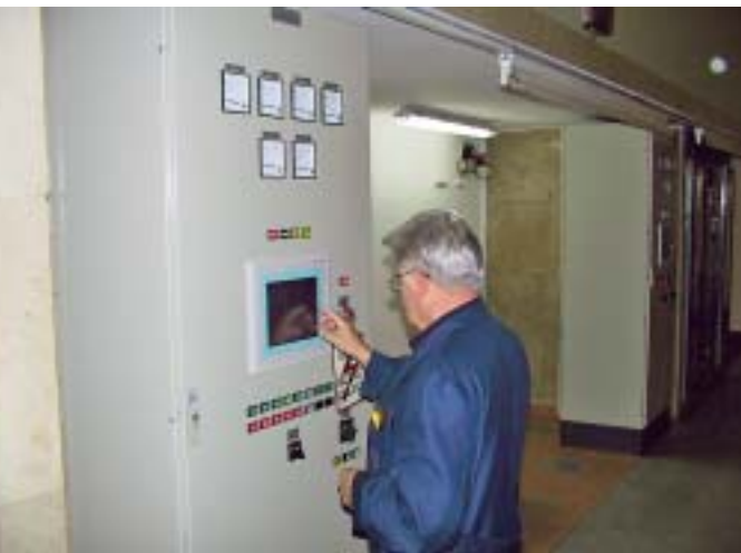
Tehnički rukovoditelj Josip Dragičević ispred jednog od sučelja novog sustava turbinske regulacije agregata 2
