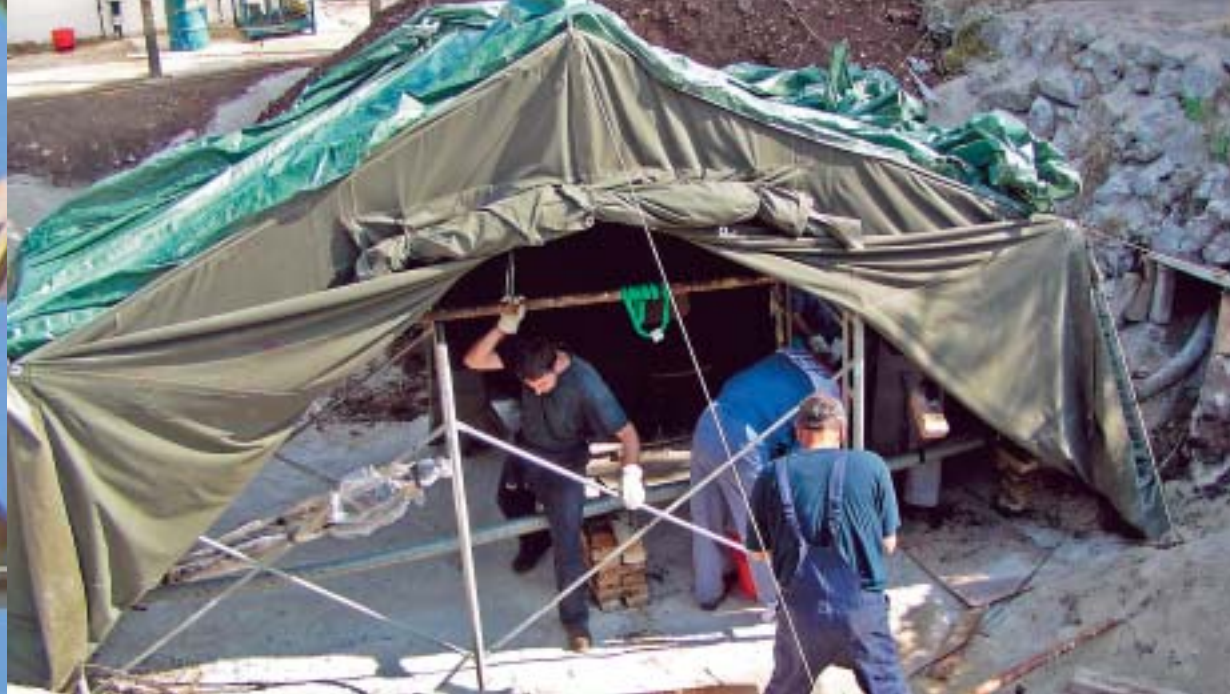
U neposrednoj blizini KS Prapatna, radnici Odjela održavanja splitskoga PrP-a podigli su šator kao zaštitu od u to vrijeme čestih kiša, pa se posao obavljao prema predviđenoj dinamici
