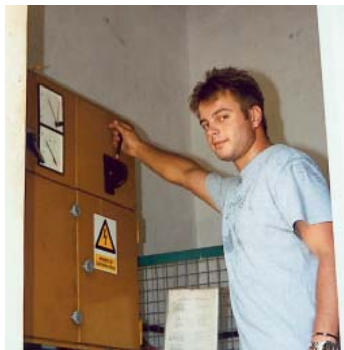
Obnovljeni dalekovod je u TS u šipanskoj luci u rad pustio rajonski elektromonter Igor Skračić
