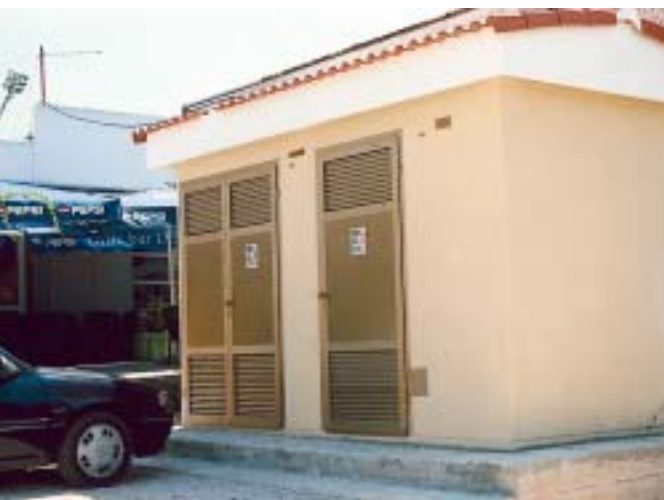
Gradska transformatorska stanica u Crnici, na zemljištu koji je osigurao Grad
