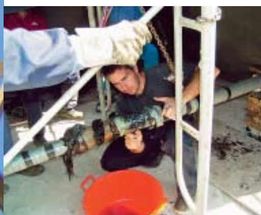
Oštećeni kabel popravljao se pod šatorom
