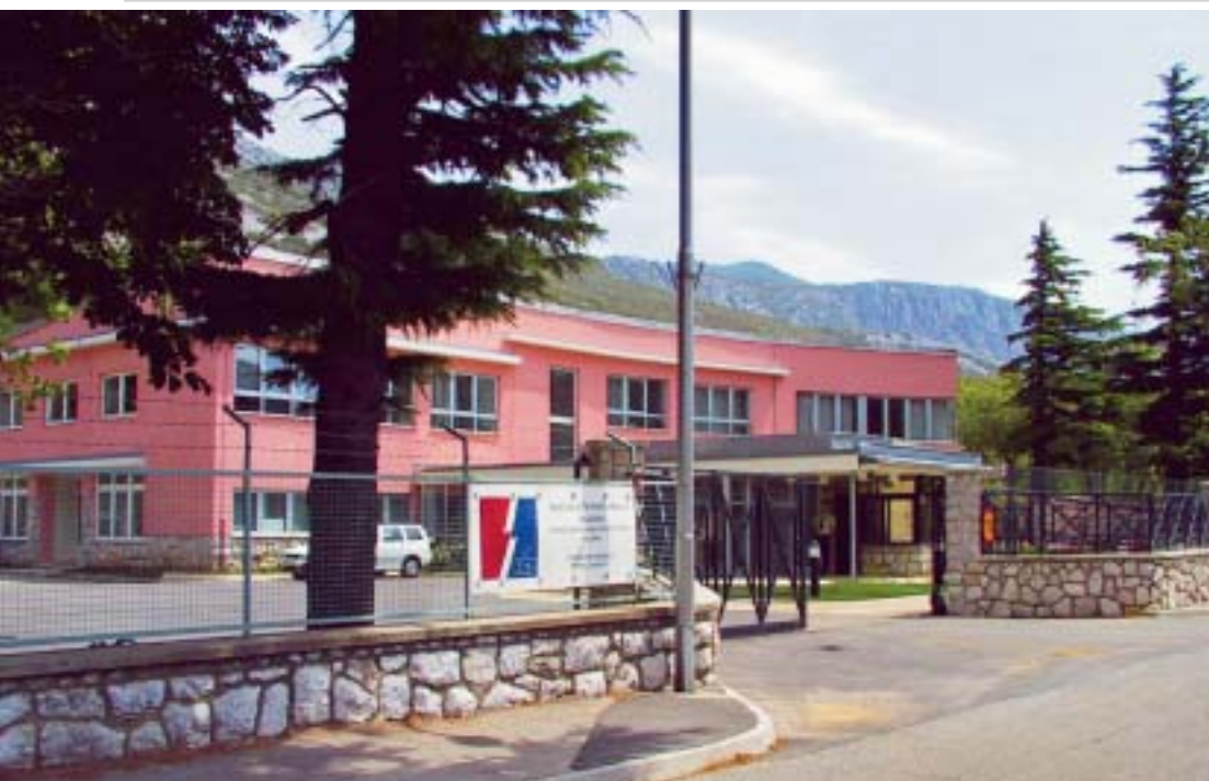
Upravna zgrada HE Vinodol u Triblju
