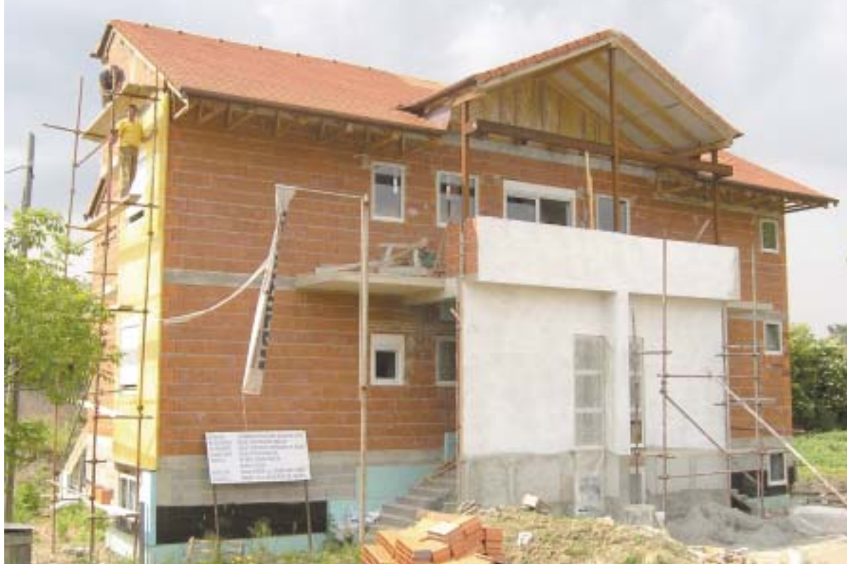
Izgradnja osječke energetske neovisne kuće bliži se kraju
