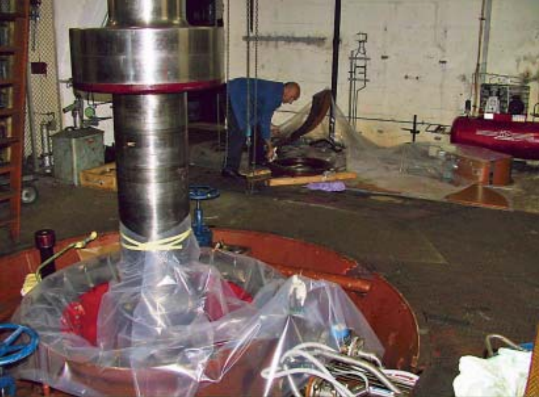
Rukovoditelj strojarskog održavanja Mijo Gregurić pregledava dijelove demontiranog turbinskog vodećeg ležaja agregata 1
