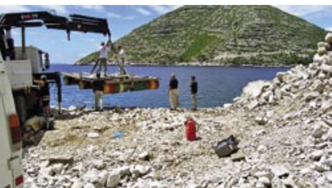
Splav, na kojoj će se obaviti popravak kabela, spušta se u more
