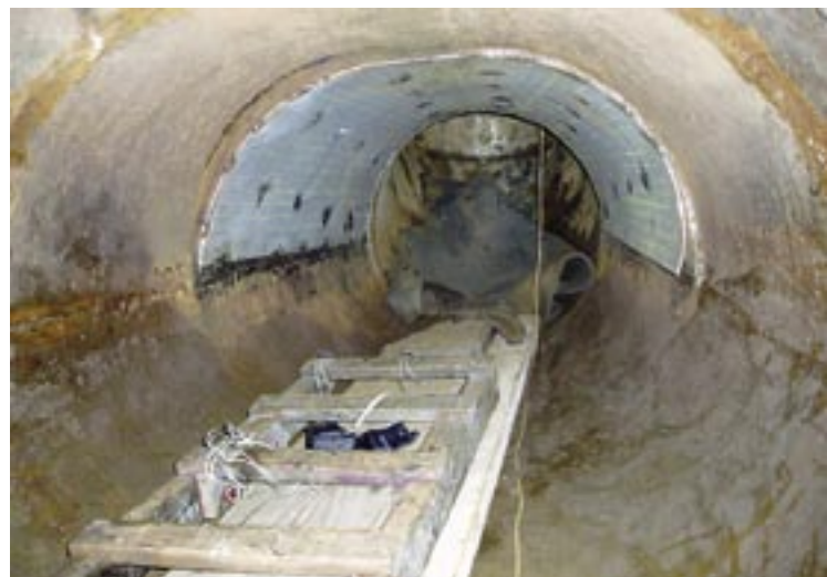
Duboko u utrobi strojarnice, saniraju se izlazne cijevi regulatora tlaka
