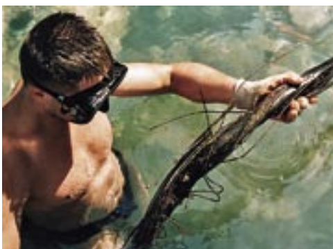
Ronilac pokazuje kabel i mjesto oštećenja nakon podizanja kamena
