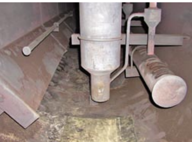
Stanje unutrašnjosti kotlovskog bubnja: promjena načina pripreme napojne kotlovske vode, odnosno izbacivanje hidrazina iz upotrebe, nije prouzročilo vidljive promjene, niti je negativno utjecalo na stanje materijala vodne i parne strane kotla
