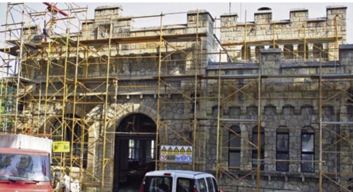
Pročelje zgrade HE Ozalj 1, zaštićenog spomenika kulture
