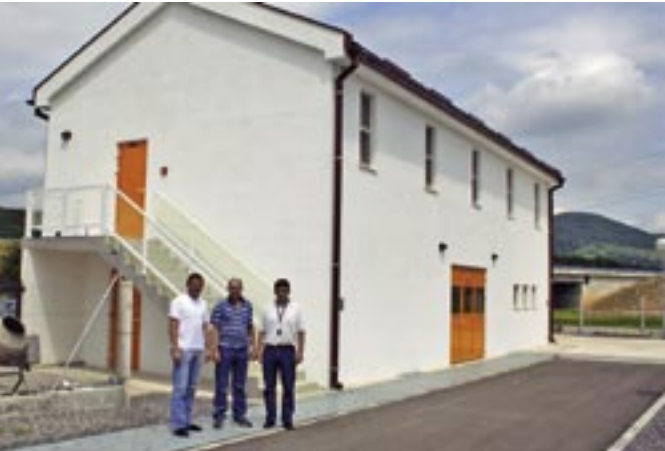
Ivan Radošević, poslovođa u Odjelu održavanja i elekromonter Ive Pejnović iz Elektrolike te Krešo Brkljačić iz Prijenosnog područja Opatija ispred zgrade u kojoj je smješteno 35 kV postrojenje koje se nalazi u krugu TS 220/35 kV Brinje, a 35 kV dio trafostanice preuzet će Elektrolika
