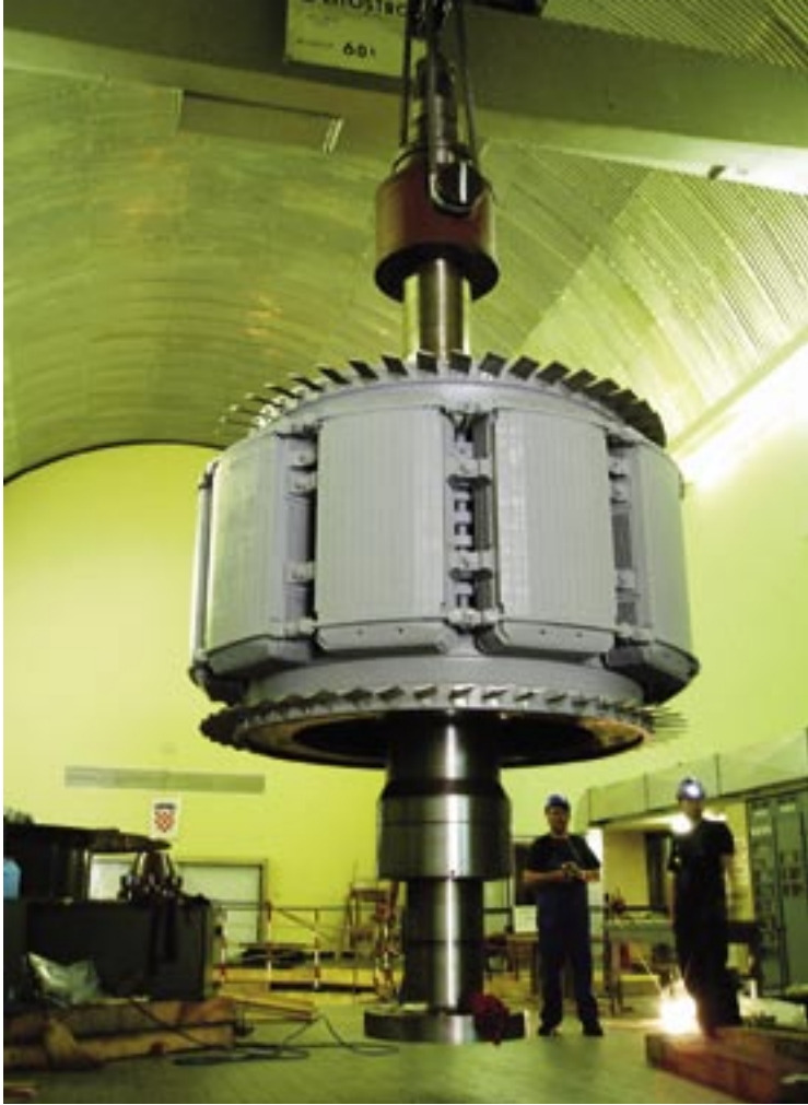
Rotor generatora agregata A2 u fazi postavljanja u stator
