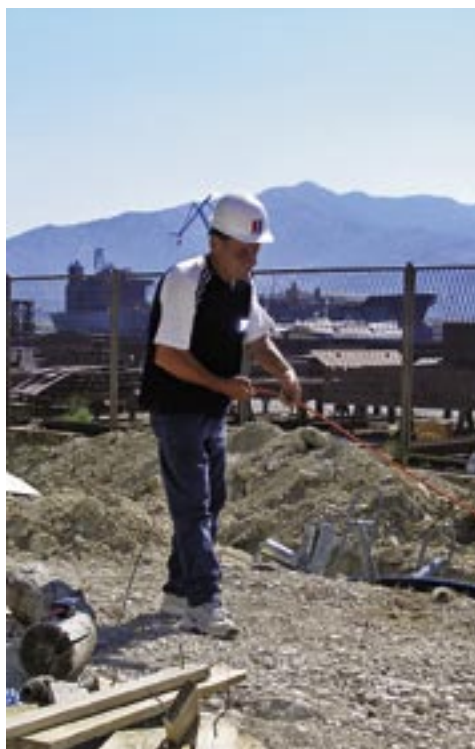
Jozo Čizmić, najstariji elekromonter u Odjelu, prati polaganje optičkog termoosjetljivog kabela
