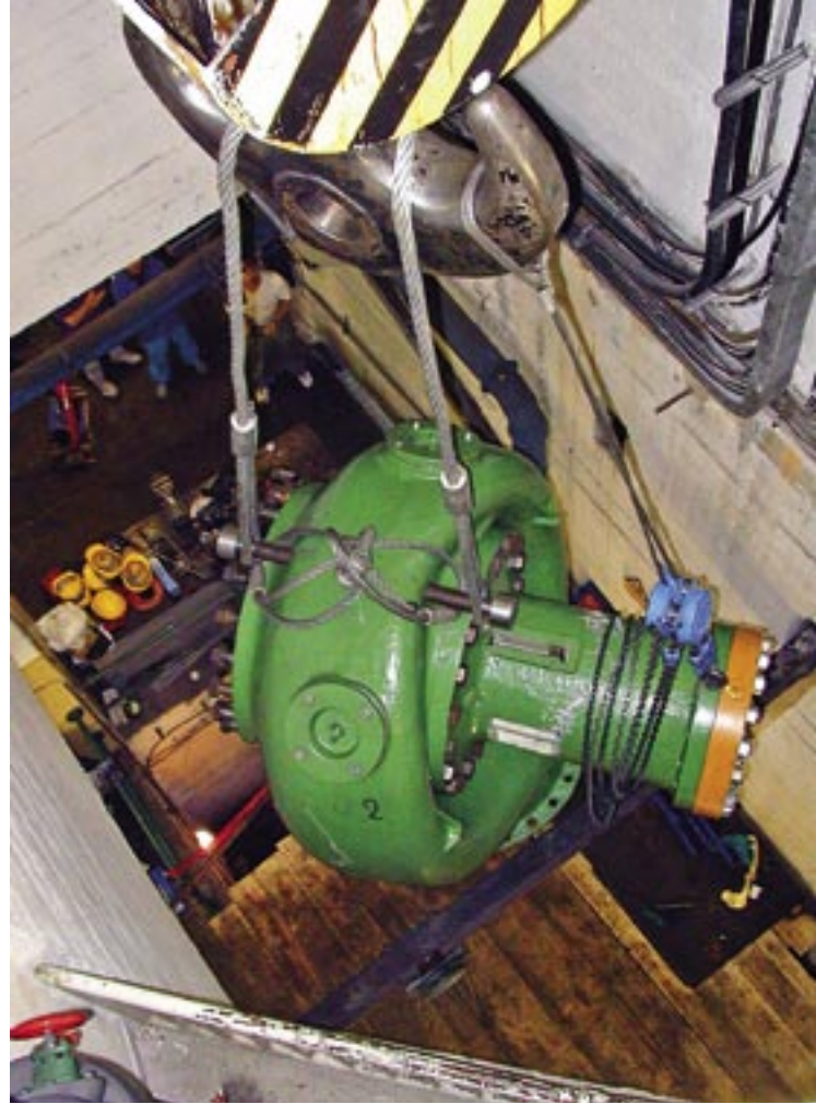
Regulator tlaka agregata A2 na svom putu prema radionicama Energoremonta ...
