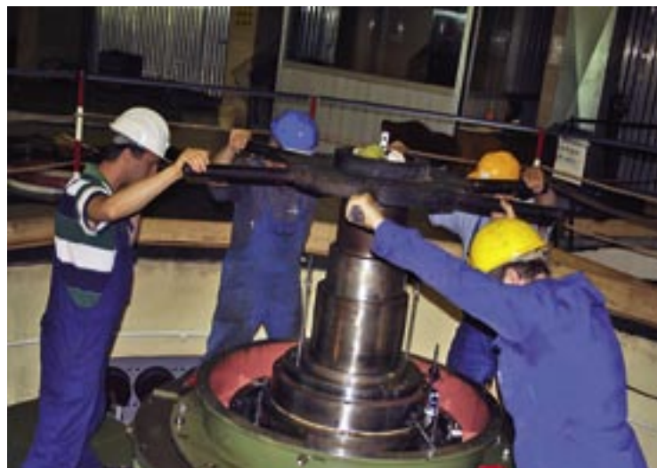
Ručno okretanje rotora i prateće opreme teške samo 70 tona
