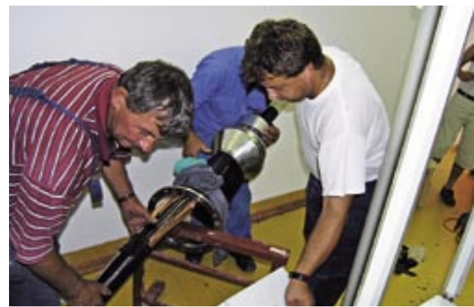
Izrada i montaža 110 kV kablinskih glava za kablensko polje TS Sučidar
