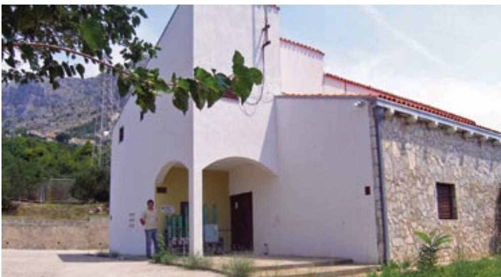
Novoobnovljena TS 35/10 kV Podgora – jedna od najljepših
