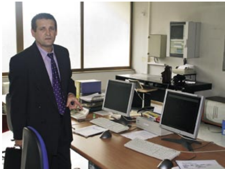
Ante Bilandžić u pogonskom centru za daljinsko upravljanje, koji je povezan s centrom za daljinsko upravljanje u sjedištu DP-a u Puli
