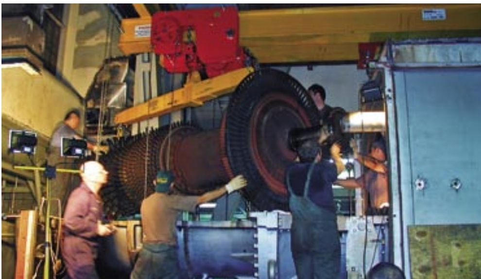
Zahtjevna i složena akcija podizanja rotora, uz nadzor supervizora Iana Boylea (Turbine Services, Škotska) – trebalo je paziti i na razmak od 20 mm!
