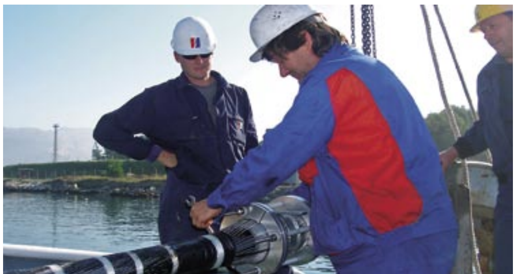
S. Padovan, Z. Čarija i P. Blaić izrađuju spojnicu antikorozijske kabliske zaštite
