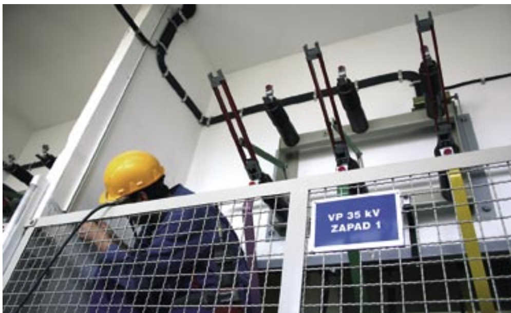
Uz pogon na jednom sustavu sabirnica TS Osijek 1, poslovi rekonstrukcije obavljali su se s povećanom pozornošću i oprezom
