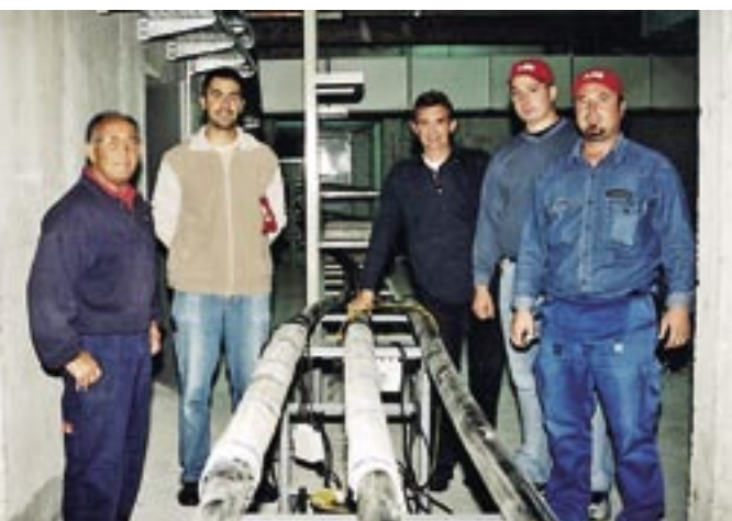
Josip Matić, vodeći monter cjelokupnog radišća, Tomislav Kralj, VKV (kabelci iz Elektre), Dragan Grmača i Mario Cindrić iz Dalekovoda te Simeon Popov, zastupnik ABB-a pokraj kabela, koji se moraju zagrijati da bi se izravnali, a sve je to priprema za izradu kabselske glave u TS Savica
