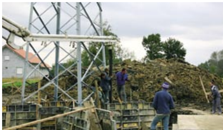
Betoniranje je moguće gdje se voda povukla
