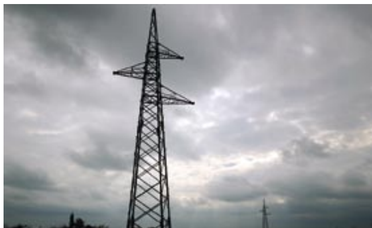
Ipak niču stupovi novog dalekovoda
