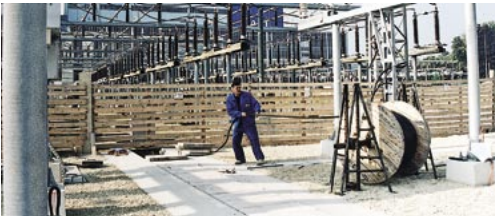
U kabelskom kanalu polaže se signalni kabel
