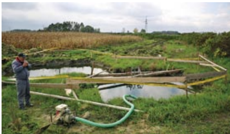
Praženje mjesta pripremljenog za betoniranje stupa blizu Strizivojne crpkama, jer ovdje je voda prešla razinu od tri metra
