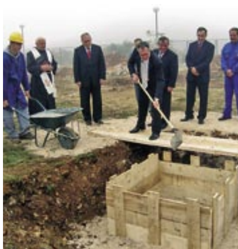
Ministar gospodarstva Branko Vukelić prvi je "učvrstio" temelj izgradnje najvažnijeg drniškog elektroenergetskog objekta...
