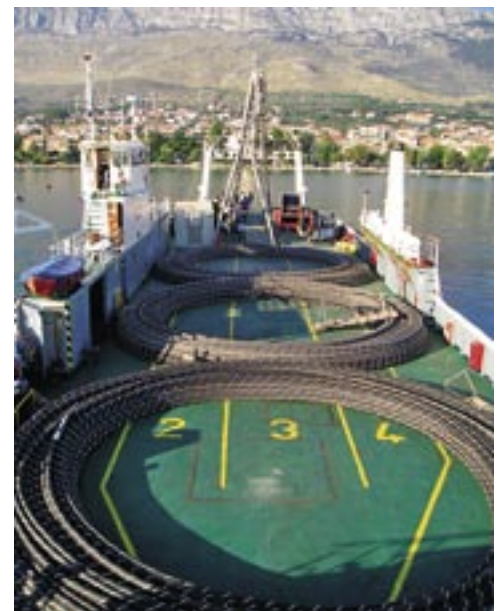
Na trajektu "Prizna" kabele, strojevi i svakojaki uređaji potrebni za ovo polaganje teški su blizu 190 tona
