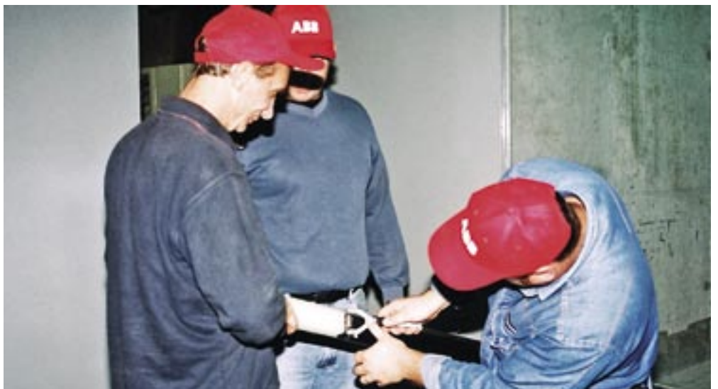
Kratki trening za izradu kabselske glave
