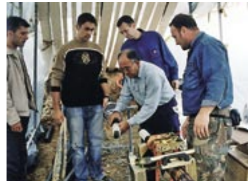
Za izradu jedne 110 kV kabelske spojnice potrebno je šest do osam sati kaže Simeon Popov. Ovo je čist i vrlo pedantan posao, zaključili su dalekovodaši i mladi elektraš Tomislav Sinković
