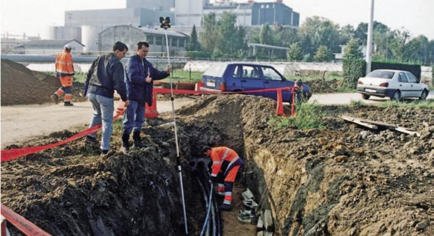
Kabeli su na kraju položeni i na četvrtoj dionici (pokraj TE-T0), gdje posla još imaju i geodeti iz zagrebačke Elektro
