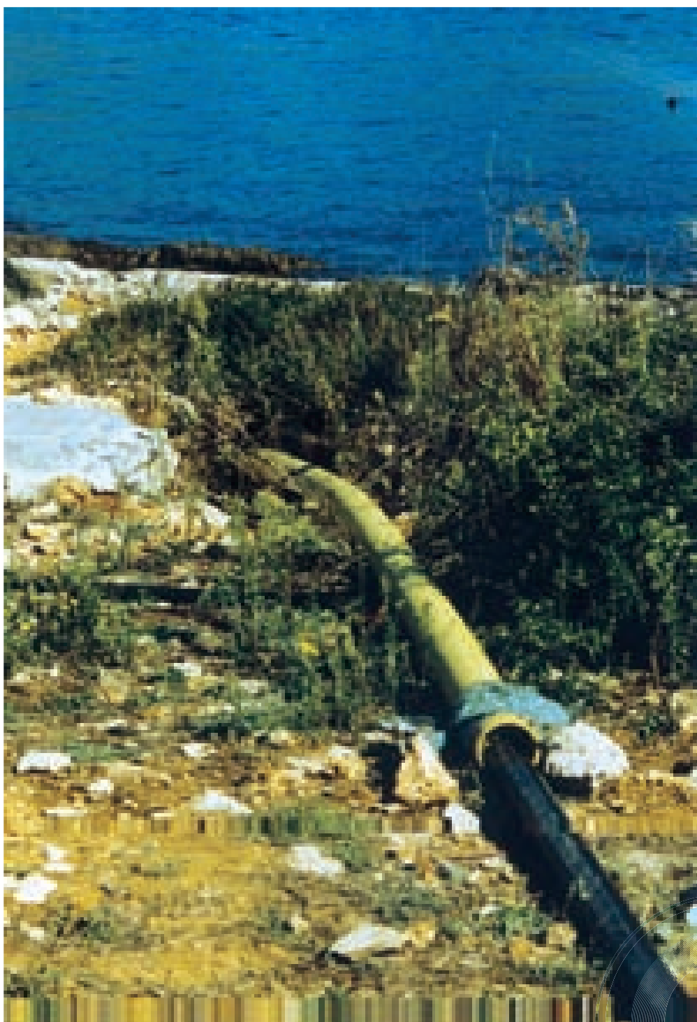
... i izvedba priobalne zaštite strojnim bušenjem – obala je netaknuta
