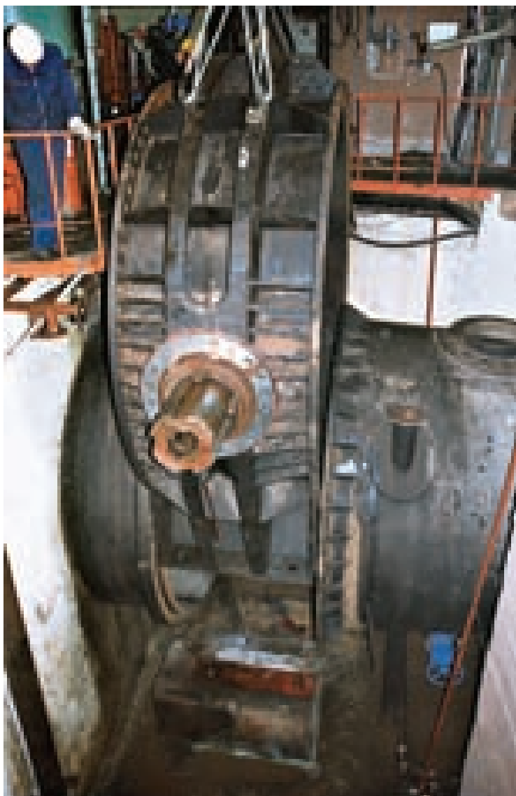
Demontaža predturbinskog leptirastog zatvarača
