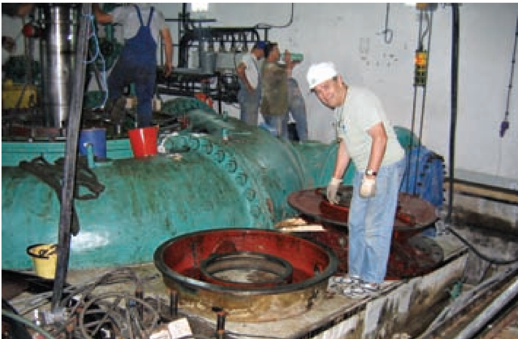
U tijeku je demontaža turbina
