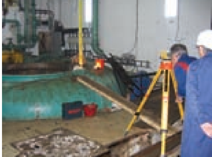
Geodetsko ispitivanje stanja postojećih dijelova turbine
