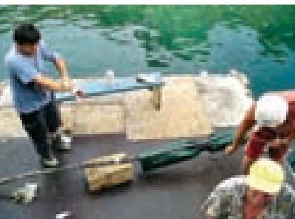
Jedini je dan bez vjetrova, a pri +35 °C u hladu i uz zagrijavanje zaštitne navlake na spojnici kabela Ugljan -Iž - nije lako ostati odjeven!
