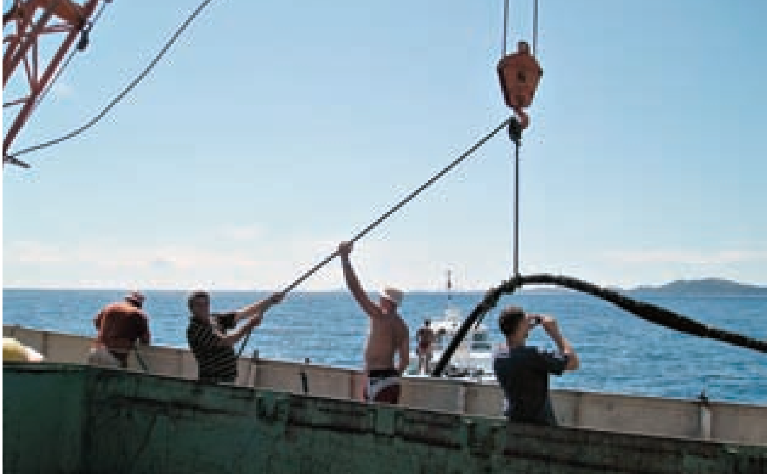
Izvlačenje kabela Silba - Olib na mjestu tvornički izradene spojnice
