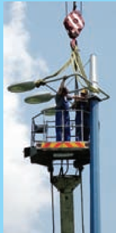
Provedba prve faze Projekta energetske učinkovitosti u sustavu javne rasvjete grada Zagreba – zamjena svjetiljki u Aveniji Dubrovnik i dijelu Zelenog vala
