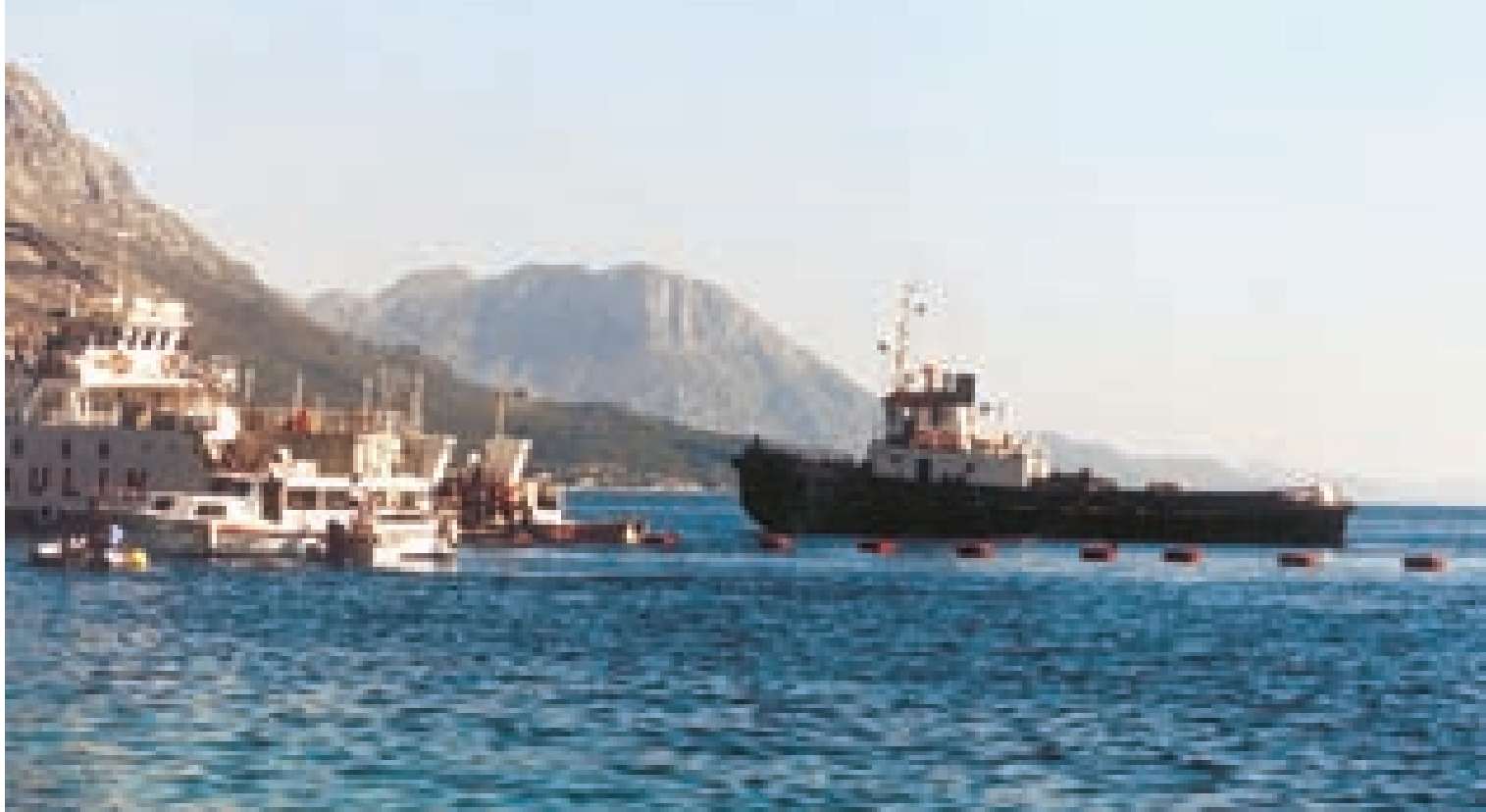
S polaganja podmorskog kabela jedne od najznačajnijih dionica Elektrodalmacije PKB 20 kV Drvenik – otok Hvar
