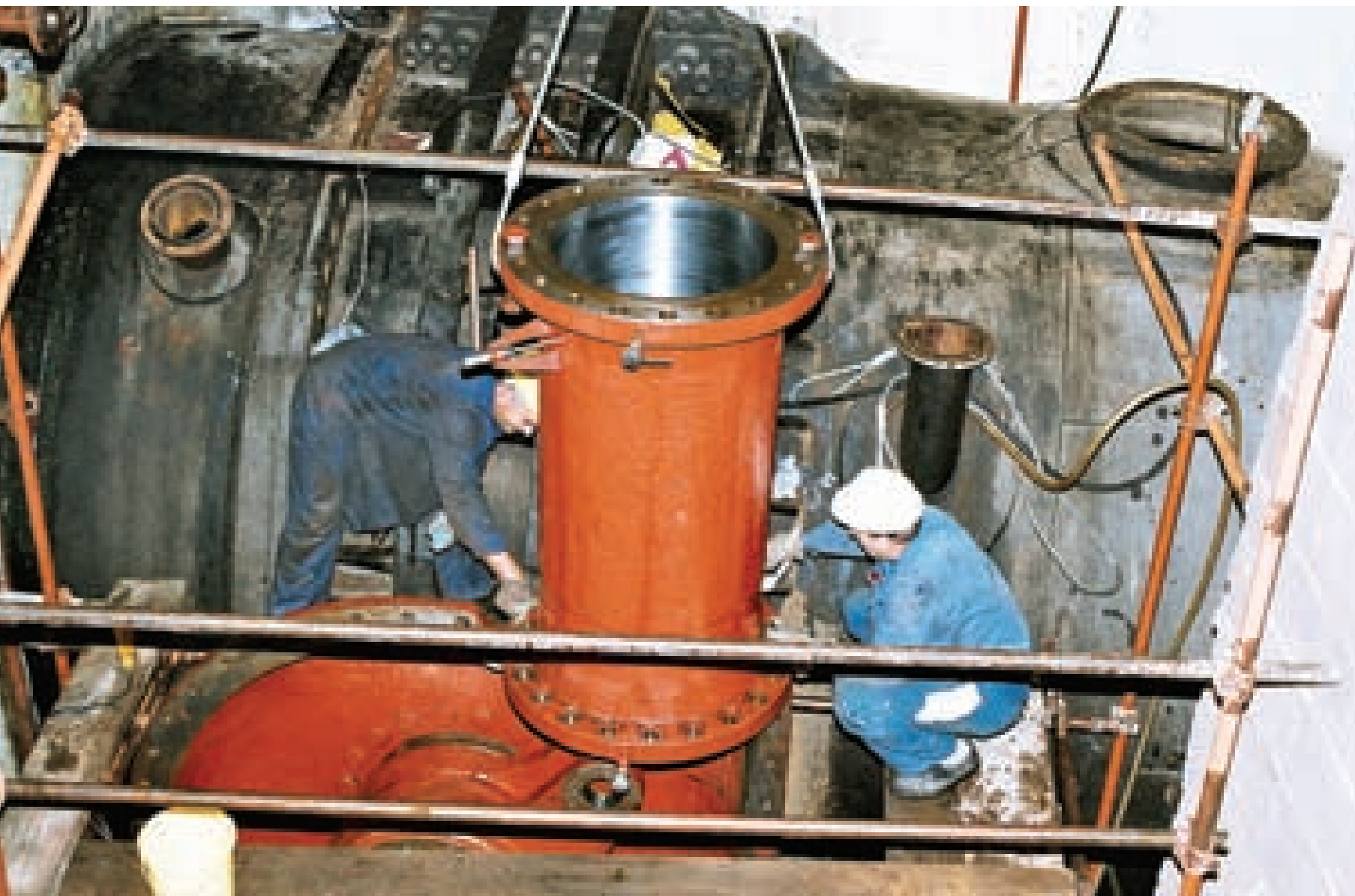
Demontaža hidrauličkog pogona predturbinskog zatvarača agregata B
