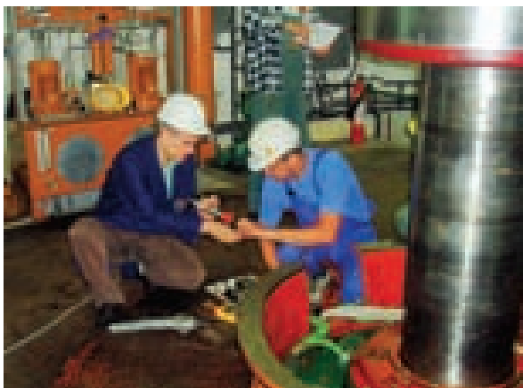
Priprema se demontaža TVL 1
