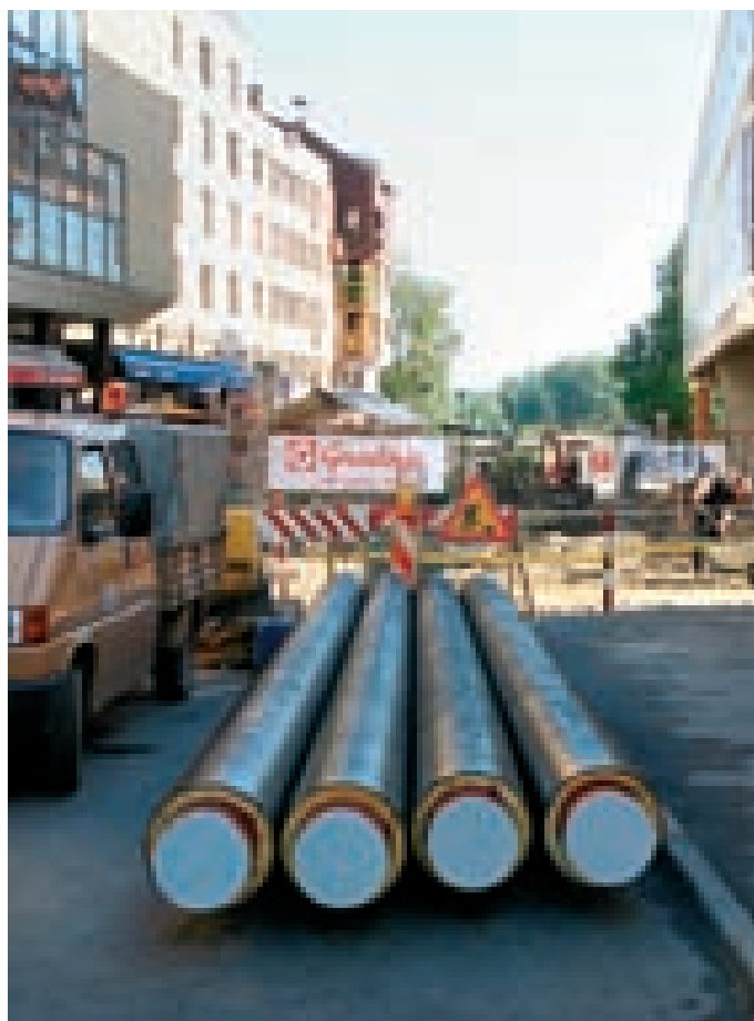
Novom tehnologijom beskanalnog polaganja predizoliranih cijevi i s ugrađenim sustavom za detekciju vlage povećat će se sigurnost opskrbe potrošača toplinskom energijom
