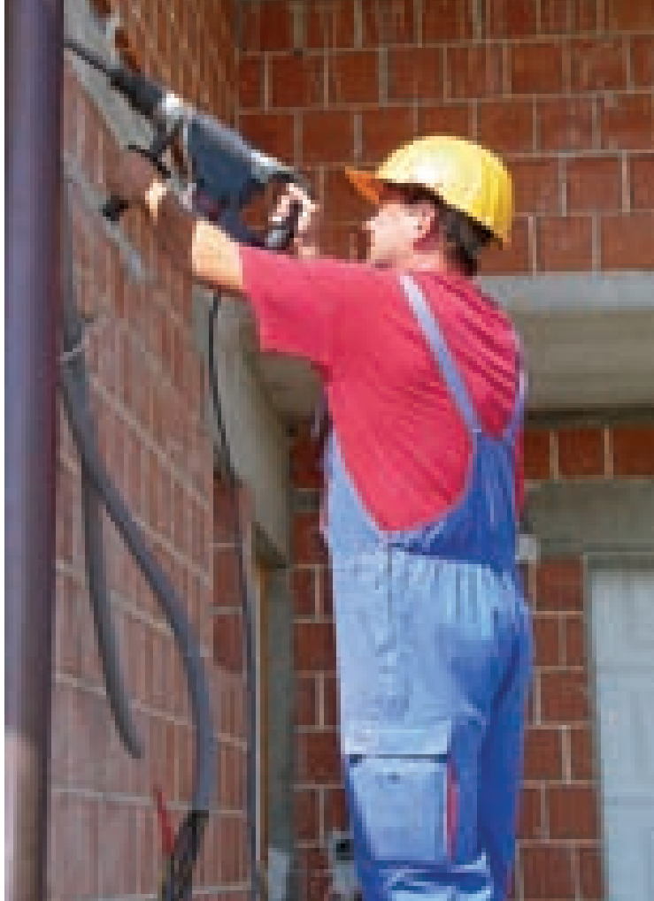
Ivica Koprivnjak (PKV) priprema ugradnju KP ormarića
