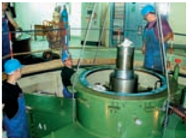
Podignut je gornji nosač križa generatora 1
