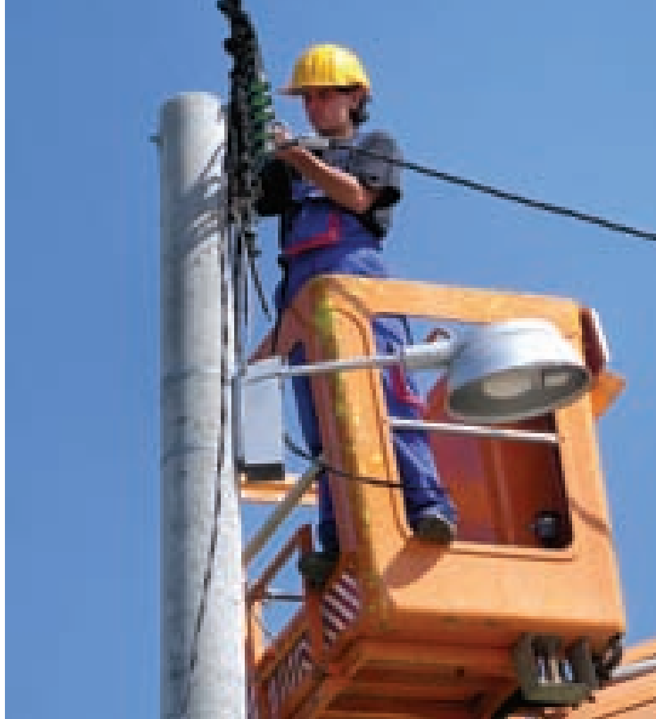
Monter Mario Kušina u elektraškom elementu
