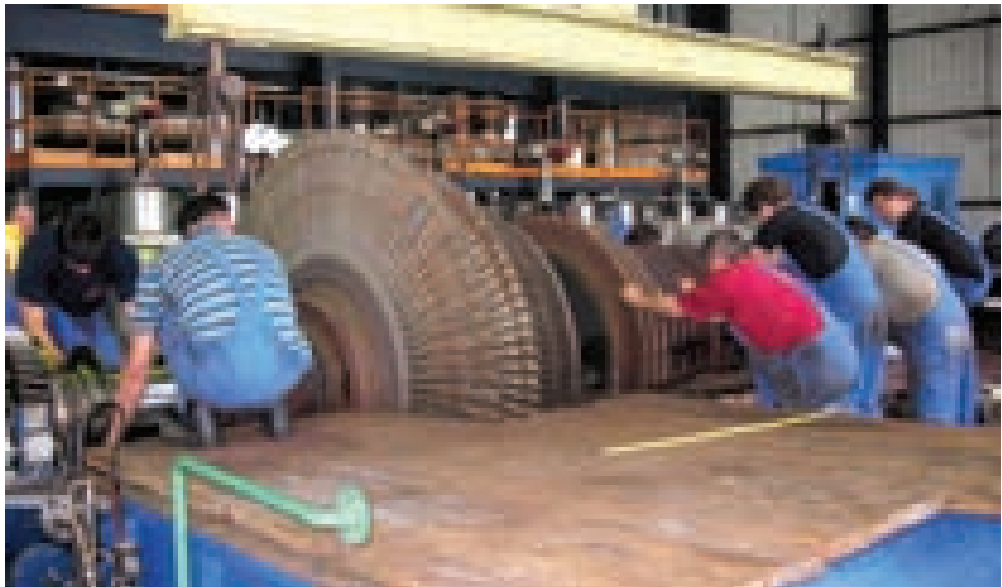
U ovogodišnjem kapitalnom remontu turboagregata 45 MW TE-TO Osijek zamijenjene su i razdjelne stijene statora i statorske lopatice u visokotlačnom umetku
