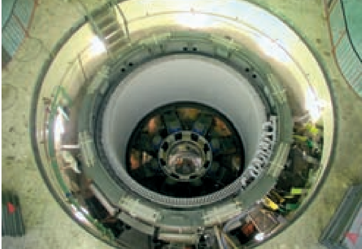
U strojarnici: radovi na generatoru D
