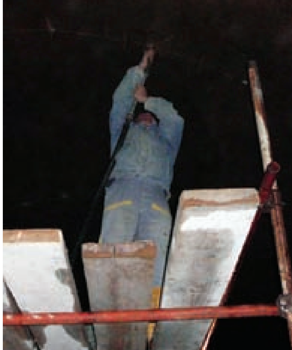
Vrlo osjetljive poslove sanacije oštećenja u tunelu Gusić Polje – Hrmatine i injektiranje betonske obloge valjalo je obaviti brzo zbog ovisnosti mnogih naselja o vodi iz tog tunela
