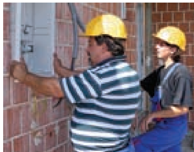
Monteri Mario Kušina i Ivan Fišter postavljaju KP ormarić
