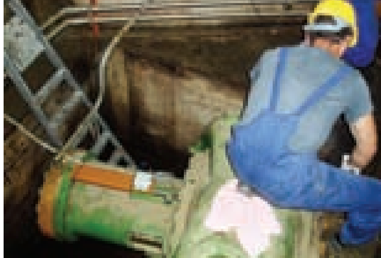
U tijeku je demontaža regulatora tlaka
