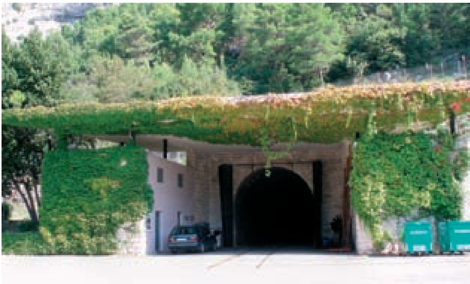
Iza ovog idiličnog i tajnovitog ulaza u pristupni tunel skriva se strojarnica naše najveće hidroelektrane, u kojoj se upravo završavaju remontni zahvati na agregatu D
