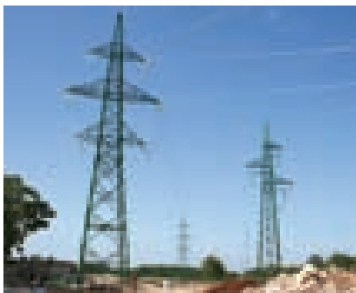
Priključni dalekovod 110/20 kV za TS Vinčent je u potpunosti završen i može uslijediti tehnički pregled
