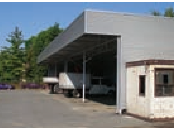
Nova nadstrešnica za teretna vozila
