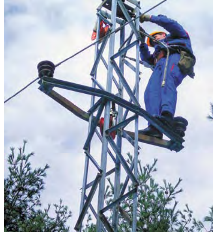
VKV monter Mario Hrnčić sa stupa DV 10 kV skida uništeni izolator
