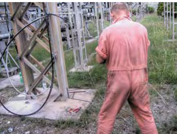
Priprema niti OPGW-a za spajanje u vodni kabel...
