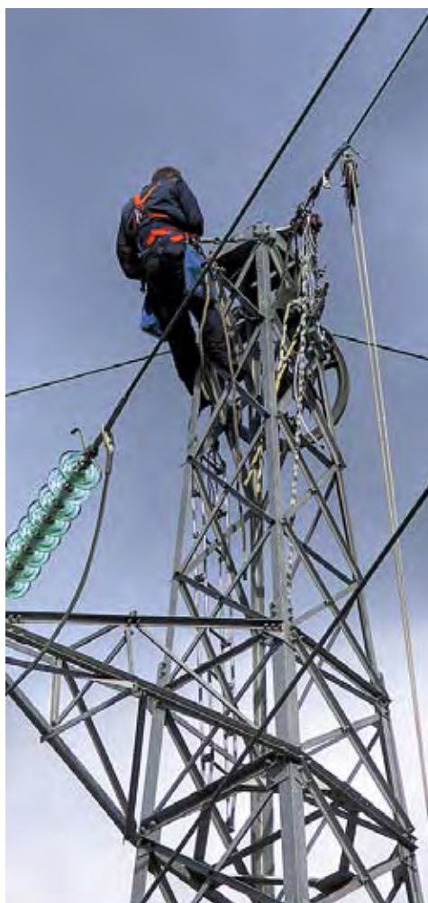
Rad na dalekovodu 110 kV Opuzen – Ploče- Makarska
