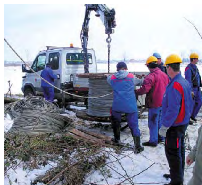
Priprema se razvlačenje novog vodiča
