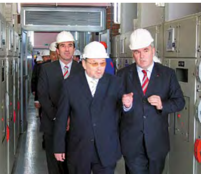
Nakon prigodnih obraćanja i puštanja postrojenja u rad, I. Mravak je predsjedniku Hrvatskog sabora i počasnom građaninu Slatine V. Šeksu pokazao suvremenu opremu Trafostanice
