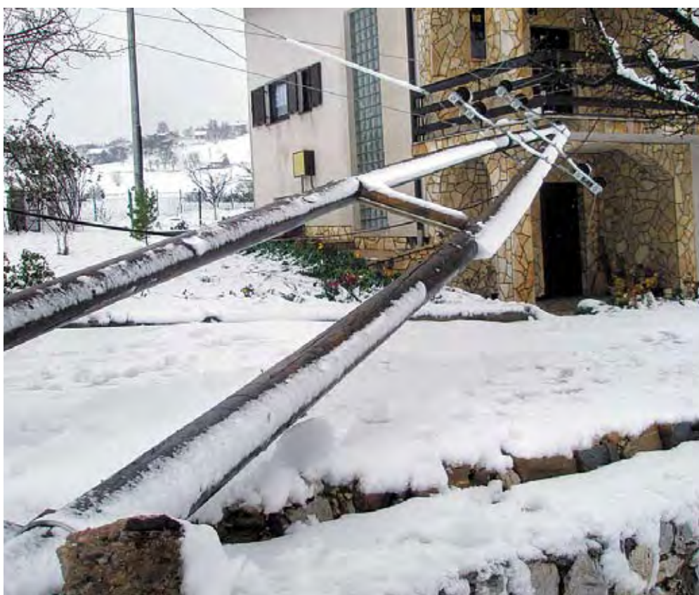
U selu Preseka Petrovska, drveni A stup zamalo se srušio na obiteljsku kuću
