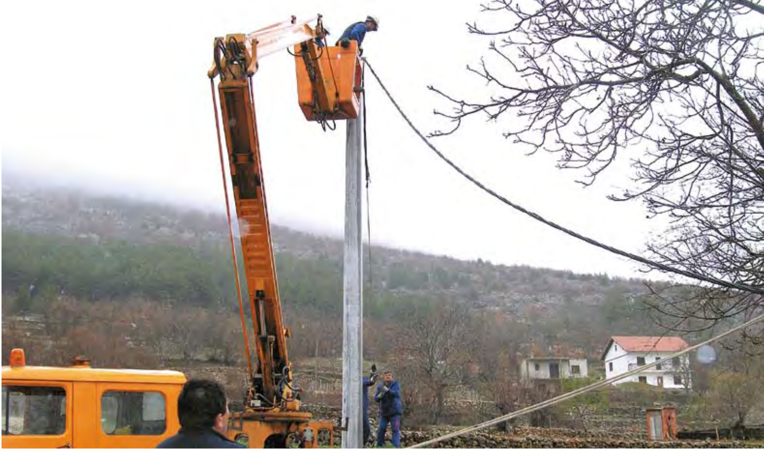
Monteri Odjela gradjenja razvlače vodiče u Svibu
