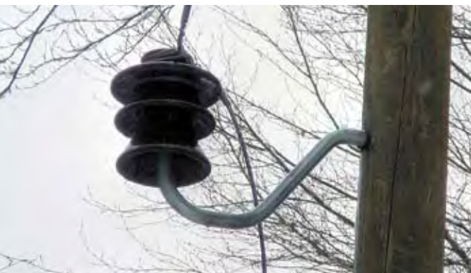
Oštećen izolator
