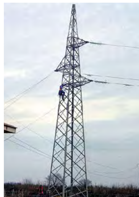
Radovi na dalekovodu Đakovo – Županja su pri kraju
