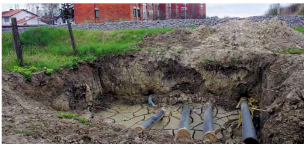
Zbog arheološkog nalazišta u osječkom naselju Filipovica, radovi na polaganju 110 kV kabela od TS Osijek 3 do buduće TS Osijek 4 su usporeni
