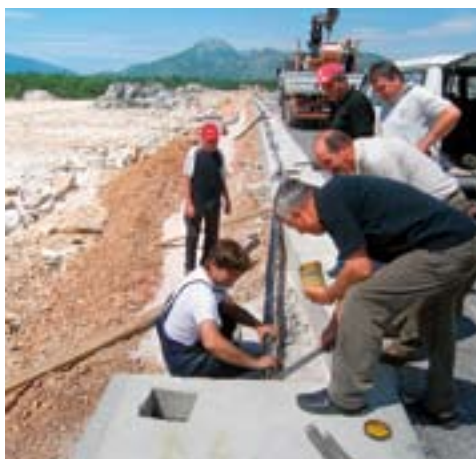
Kabel je trebalo nauljiti kako bi lakše skliznuo kroz cijev
