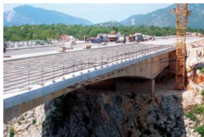
Radovi na mostu - u lijevom uglu je mehanizacija Elektrodalmacije
