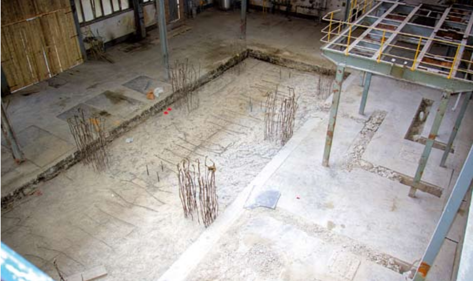
Betonsko postolje za parnu turbinu i generator spremno je za prihvat opreme
