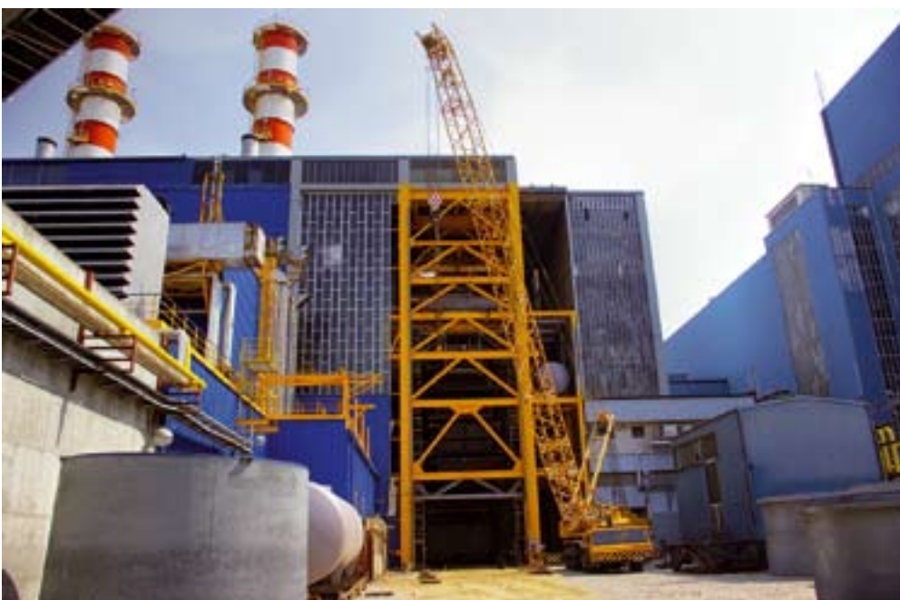
Zgrada parogeneratora i njegovog cijevnog sustava - ispred nje će biti postavljena plinska turbina, koja s pripadajućom opremom uskoro stiže, a potom će se za njih izgraditi i zgrada
