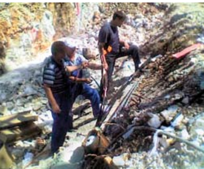
Radovi na čiovskom 20 kV raspletu
