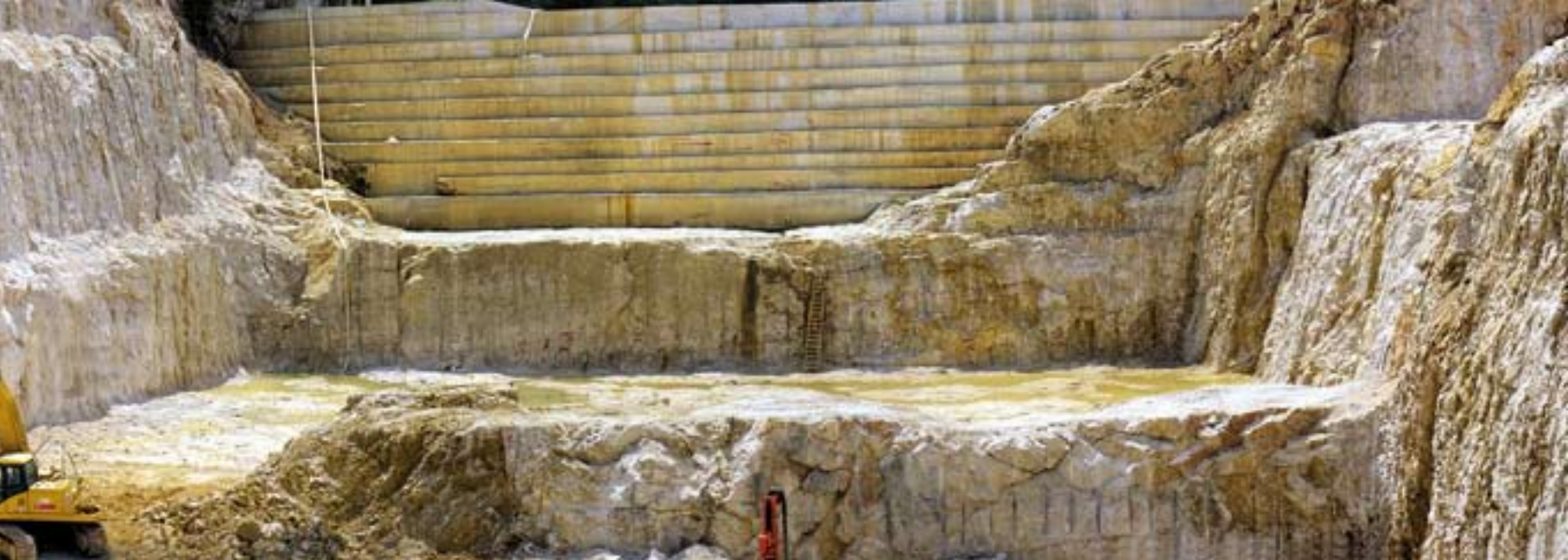
Cijeli potez po širini desne obale kanjona Dobre, odnosno građevne jame – od zagata, koji će početkom rada HE Lešće biti potopljen i neće se rušiti prije potapanja kanjona Dobre
