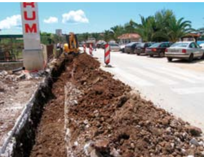
U ovaj će kanal uskoro položiti dvije trojke 20 kV, dva kabela niskog napona i kabel javne rasvjete
