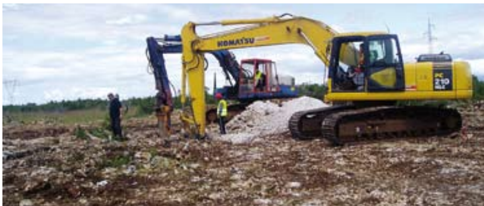
Radovi na iskopu temeljnih jama za stupove priključnog dalekovoda, koji će TS Drniš spojiti s elektroenergetskim sustavom, započeli su odmah nakon dobivanja građevne dozvole
