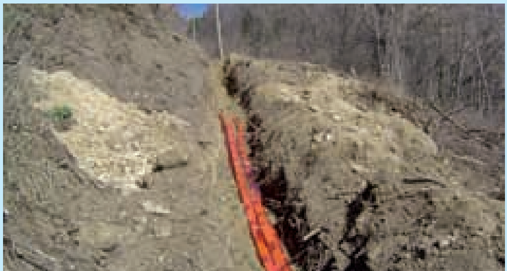
Na Kalniku se zračni 10 (20) kV vod zamjenjuje podzemnim – za RTV Kalnik
