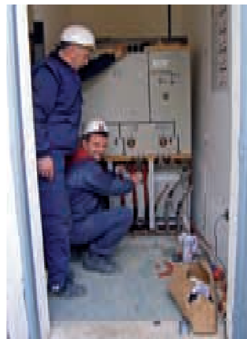
Splitska ekipa, koja je sudjelovala pri većini poslova što ih je Odjel građenja izveo na području imotskog Pogona posljednjih mjeseci – pri rekonstrukciji TS Imotski 1
