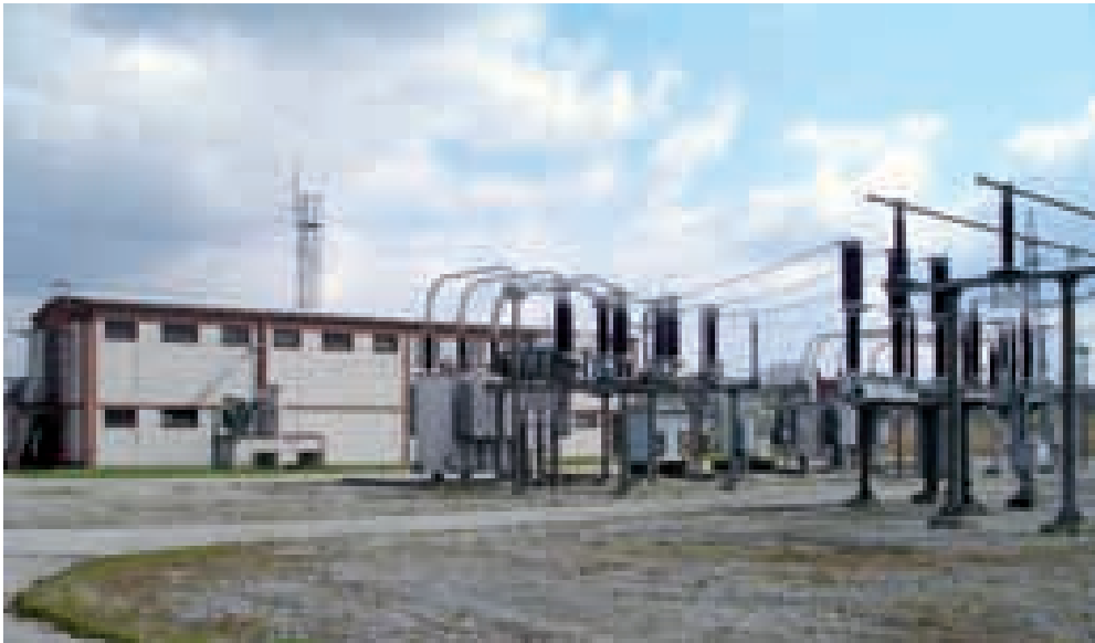
TS 110/10(20) kV Mlinovac izgrađena je 1989., a prošle je godine dograđeno još 20 MVA
