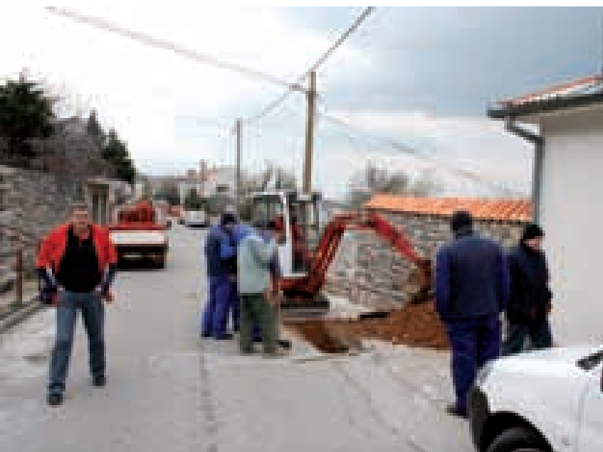
Stiglo je mjerno vozilo iz Rijeke, kvar na podzemnom kabelu je otkriven i može se započeti njegovo otklanjanje
