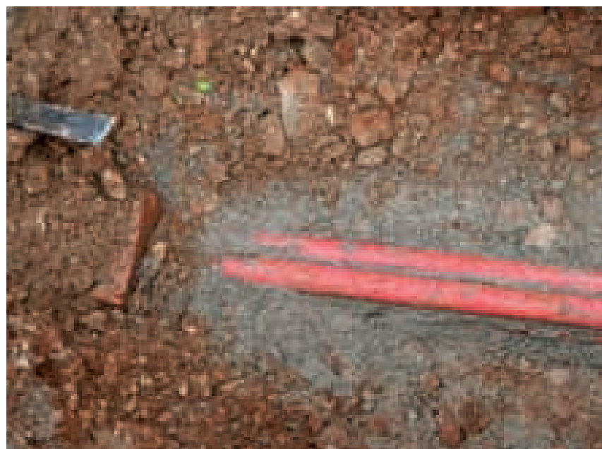
Oštećenje na kabelu jedva je vidljivo, ali zbog njega je sedam trafopodručja ostalo bez napona
