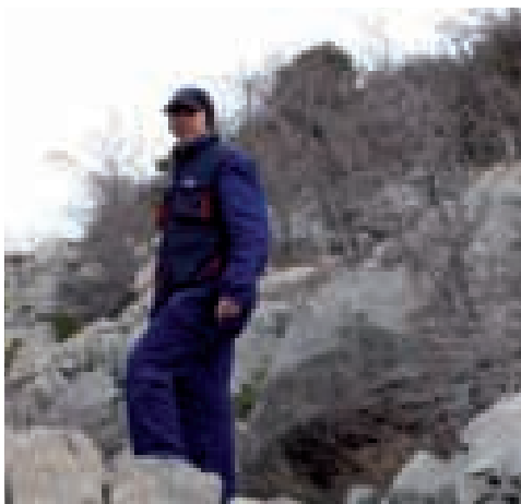
Po ovakvu terenu i olujnoj buri doista se nije lako probijati do srušenoga stupa, a možete li zamisliti kako je još nositi i alat i opremu, pita poslovođa Saša Legac
