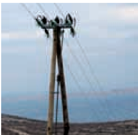
Slomljeni stup poduprt je novim
