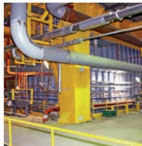
Kotao je montiran i čeka tlačnu probu, dok je tlačna proba dimovodne strane već uspješno provedena
