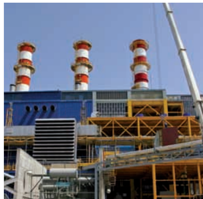
Gradilište novog Bloka L i dežurna 40-metarska dizalica
