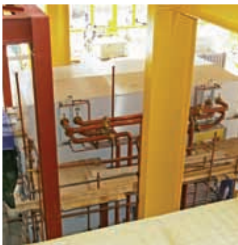
U tijeku je i montaža usisnih kanala plinske turbine
