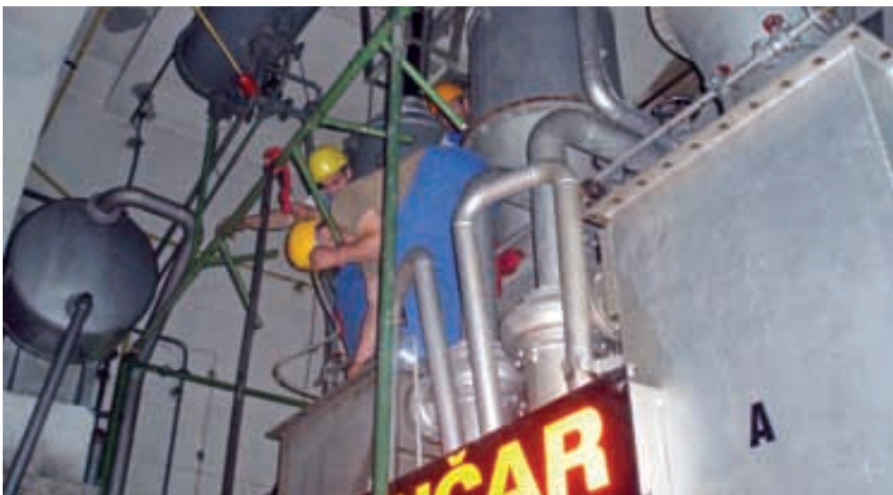
Čišćenje izmjenjivača blok-transformatora agregata A
