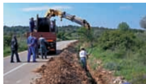
... kabel se sprema u kanal
