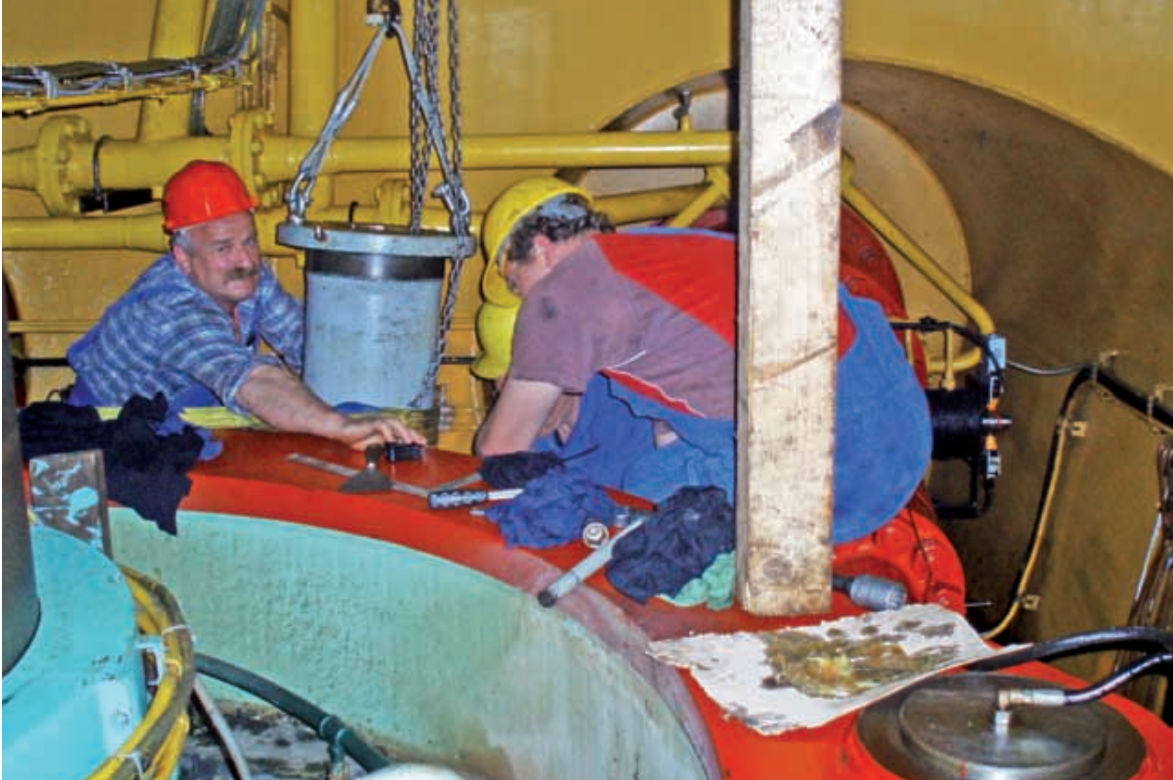
Sanaciju brtvi na čahurama turbinskih privodnih lopatica na agregatu A obavlja Stjepo Matić i njegove kolege
