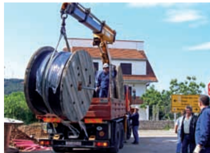
Kabliranje je započelo...
