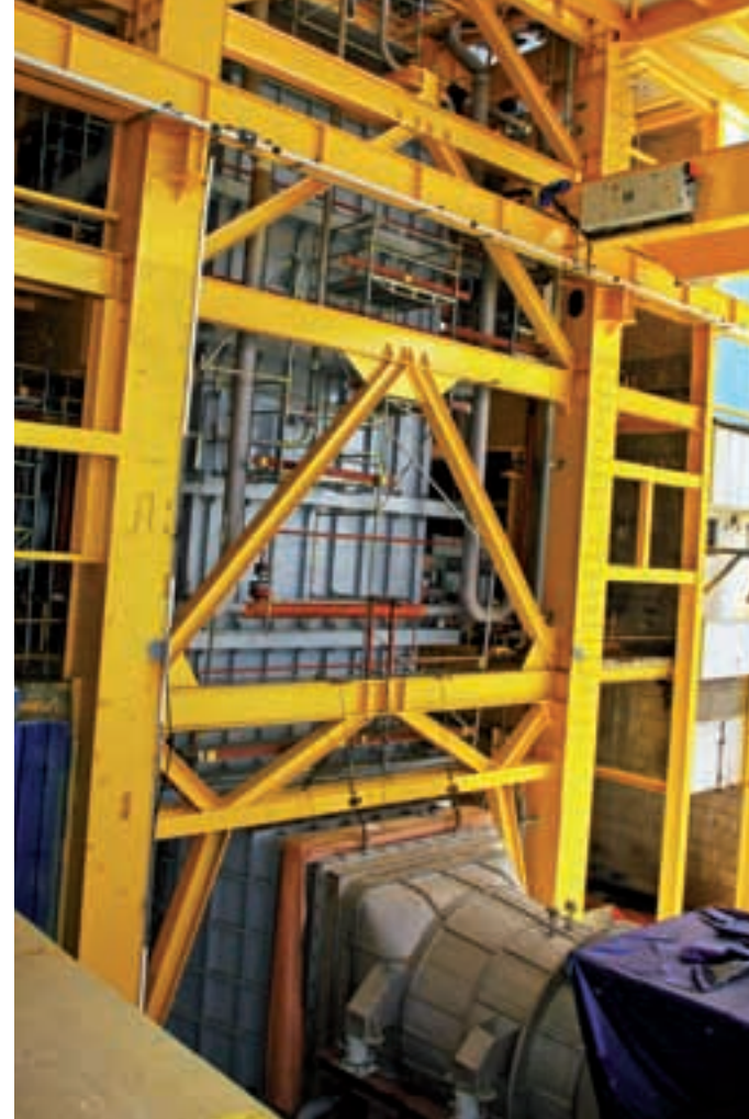
Vanjski pogled na kotlovsko postrojenje
