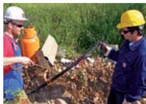
L. Đogaš i J. Peroš izrađuju kabelske spojnice
