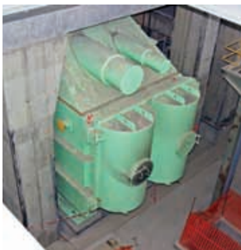
Montiran je i kondenzator
