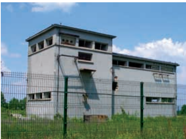
U ratu devastirana TS 35/10 kV Sunja, lokacija budućeg rasklopišta
