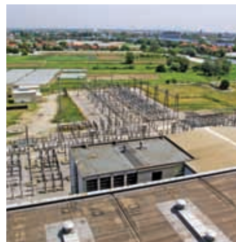
Pogled s krova na dovršeno rasklopište
