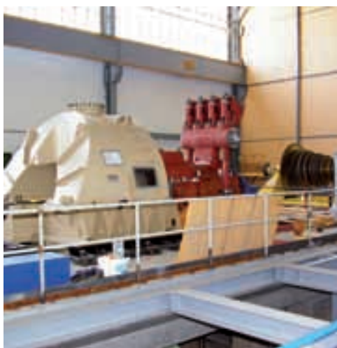
Montira se parna turbina i čeka dostava generatora, a rotor je spreman za ulaganje u turbinu
