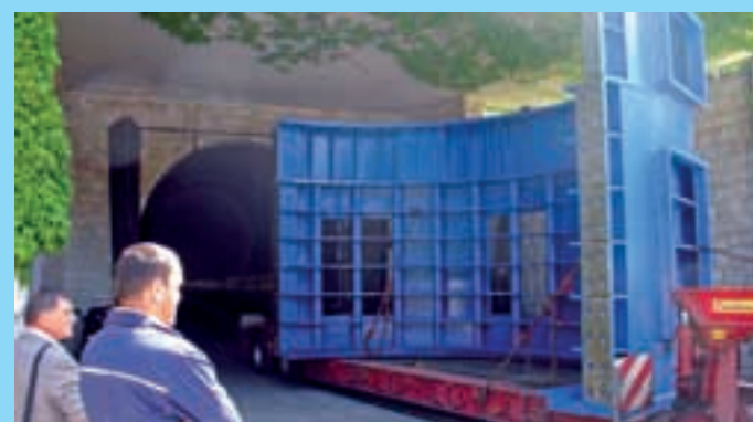
Kućište je na odredištu, a prepolovljeno ulazi u tunel na putu ka strojarnici
