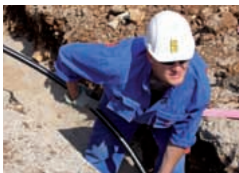
Z. Čarija prati pad kabela u kanal
