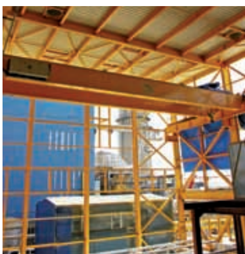
Zgrada strojarnice je pod krovom i započelo je njezino zatvaranje
