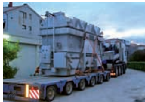
Zamjenski transformator je iz TS Mraclin posebnim prijevozom na novu splitsku adresu stigao 7. veljače...
