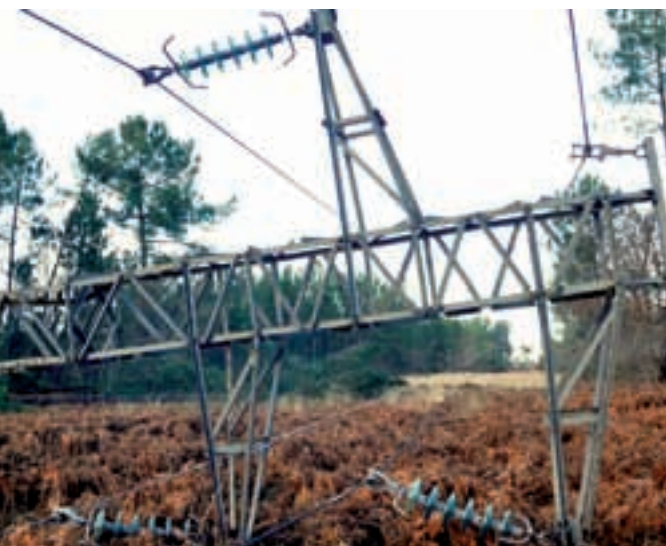
Slomljeni stup 63 kV prijenosnog voda
