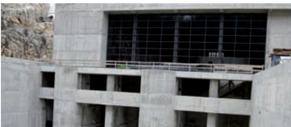
Vanjski dio strojarnice i prostor za difuzorske zatvarače
