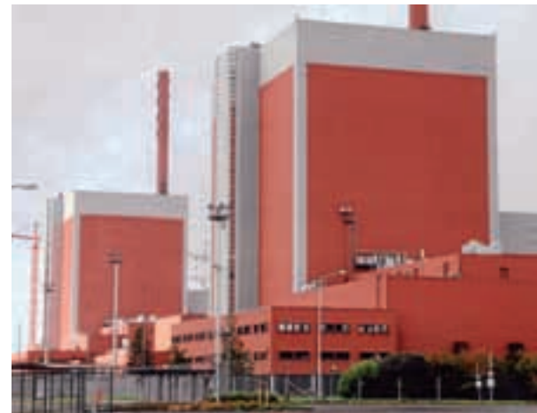
Nuklearna elektrana u finskom Olkiluotu prva je u svijetu u cijelosti zaštićena od napadačkih elektromagnetskih impulsa
