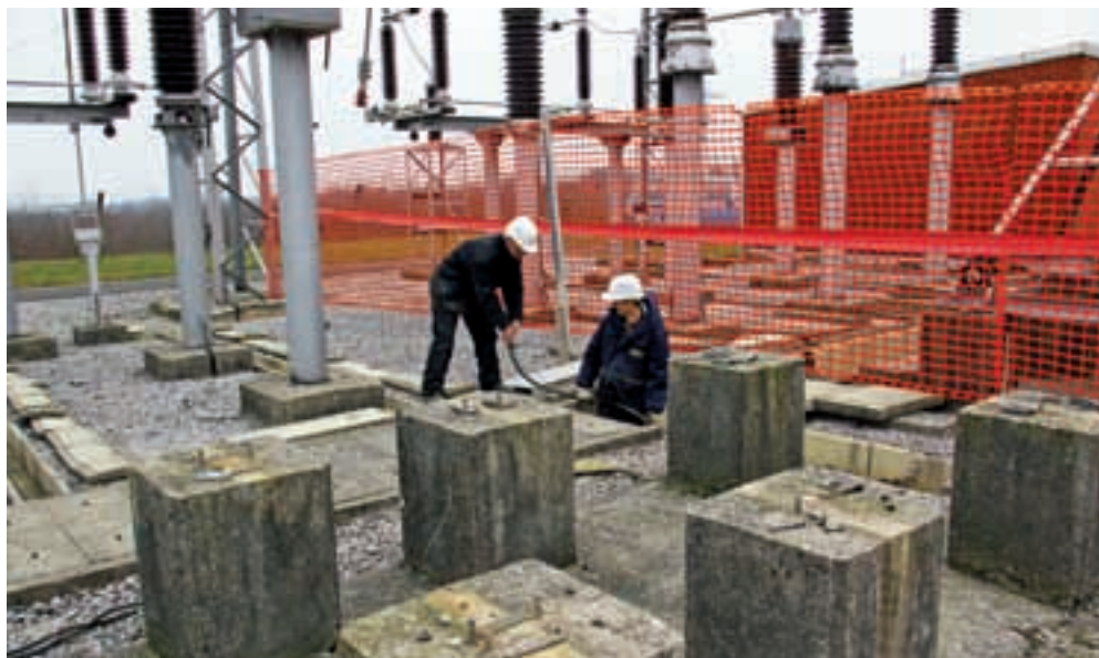
Za iskusnu ekipu Končarevaca zamjena prekidača je rutinski posao, kako na tlu...
