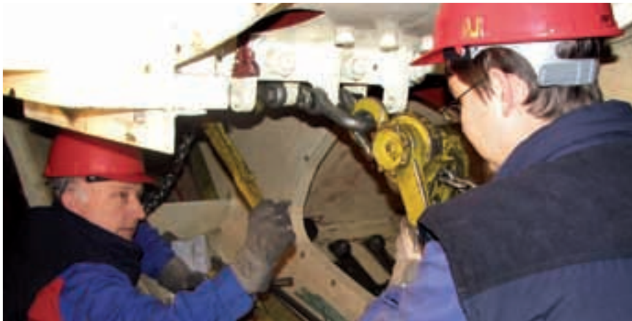
Radove na generatoru – okretanje rotora – izvode majstori HE Čakovec
