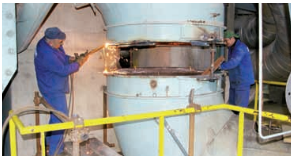
Zamjenjuje se i dotrajali kompenzator na kondenzatoru rashladne vode turbine Bloka 2
