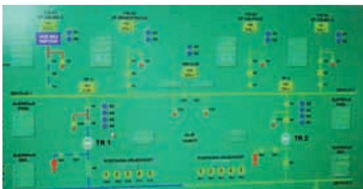
Stanje u mreži neposredno pred puštanje u pogon novog transformatora
