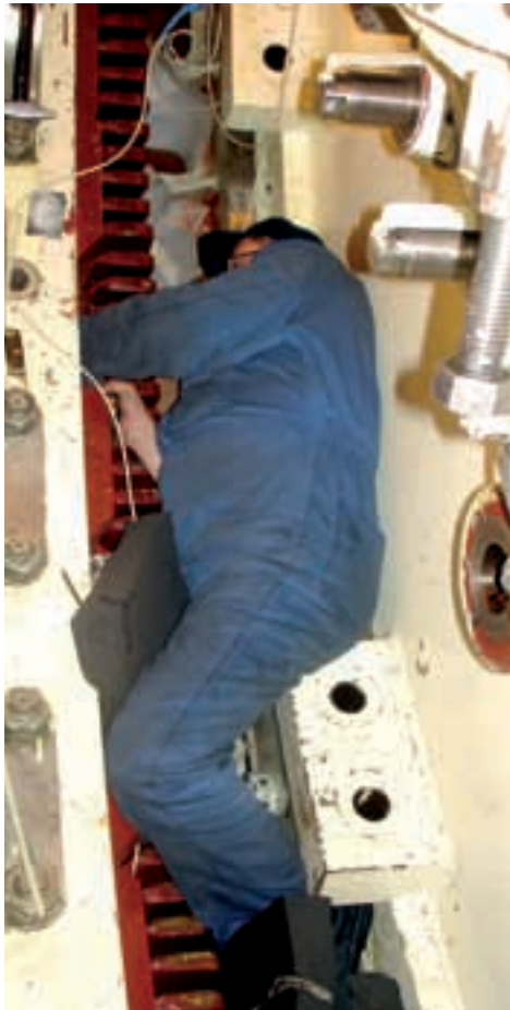
Iznimno fizički teške radove na generatoru agregata B – preklinjavanje statora – izvode zaposlenici Končar GiM-a
