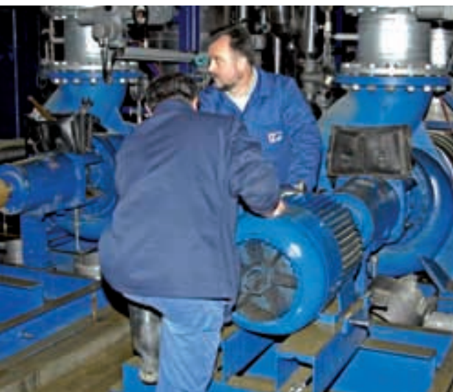
Zaposlenici EL-TO, demontiraju elektromotore, koji su potom otpremljeni na sušenje
