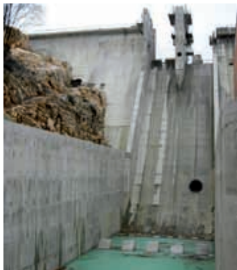
Slapište i preljev - najsloženiji dio brane
