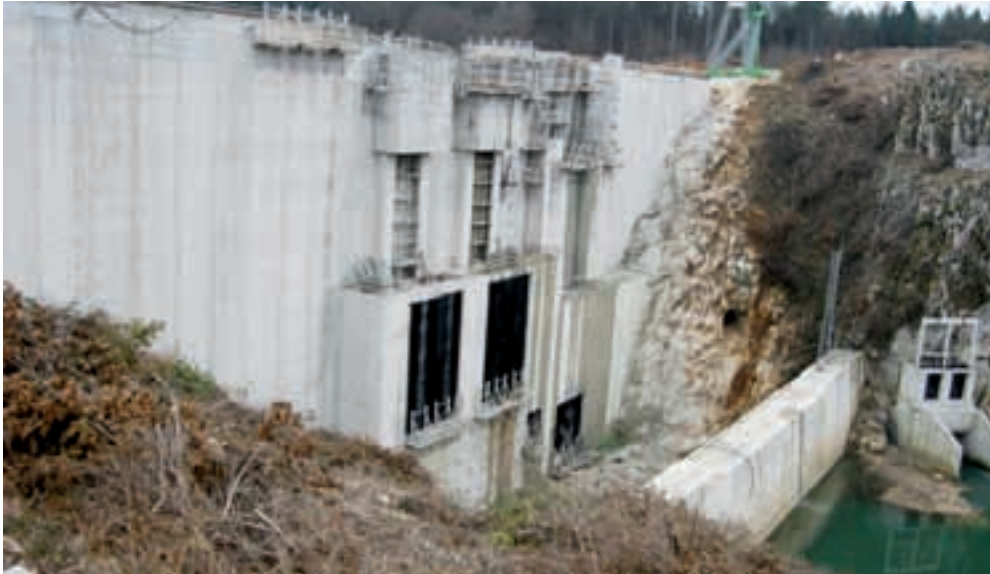
Brana HE Lešće u završnoj je fazi izgradnje
