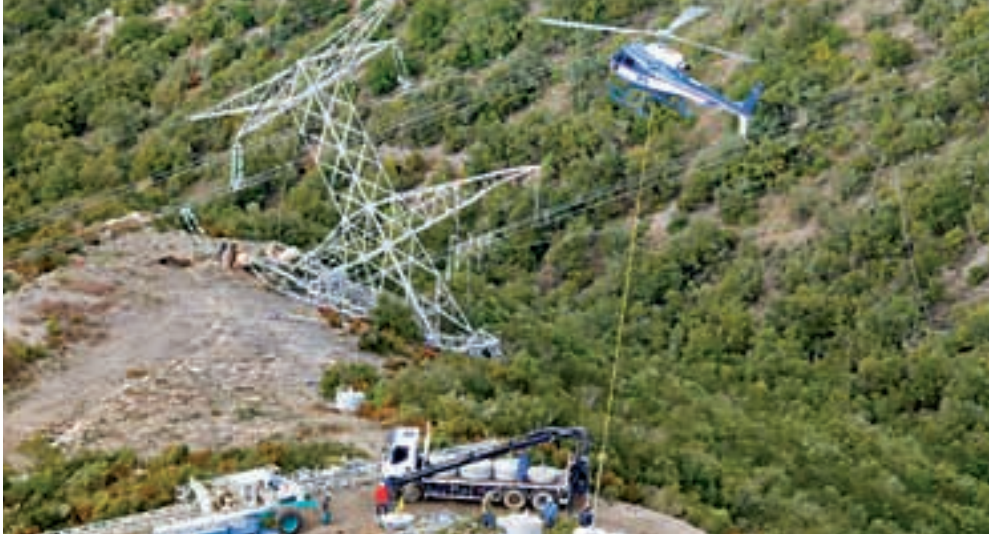
Helikopter RTE- France pri sanaciji stupa 400 kV voda: prenošenje i postavljanje temelja stupa.
