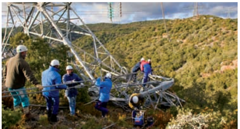
Zaposlenici za prioritetne intervencije na sanaciji stupa 400 kV voda
