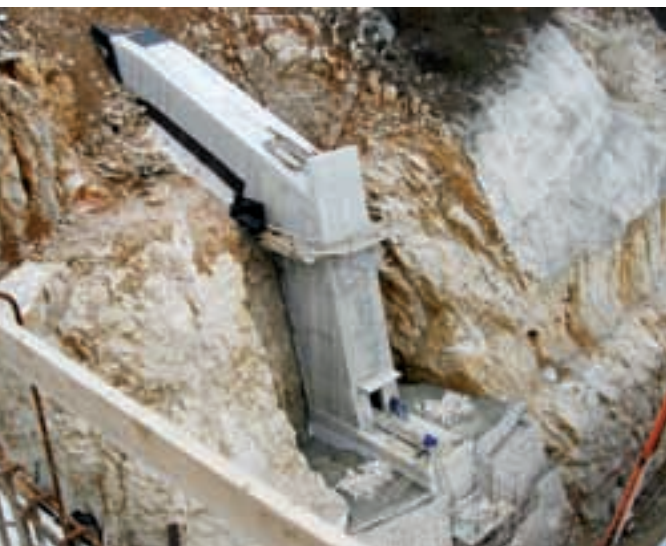
Završen je energetski tunel - u tijeku je njegovo oblaganje te izrada zaštite od odrona zemlje
