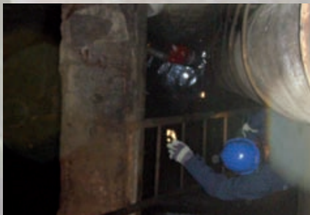
Čišćenje drenažne jame
