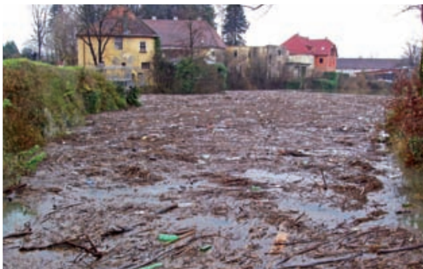
Naplavine koje završavaju na rešetkama ulaznih građevina brana naših hidroelektrana s kojima se bore naši ljudi (primjer rijeke Dobre)
