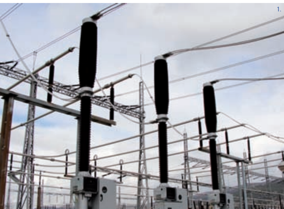
1. Novi siemensov SF 6 prekidač spojnog polja glavnih sabirnica pušten je u rad početkom veljače
