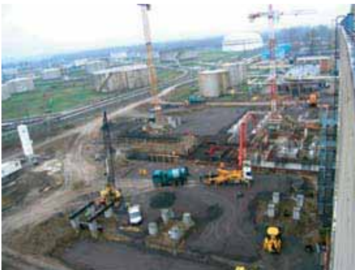
Dok su radovi na mjestu kotlovskog postrojenja odmakli, postavljena je oprema za testiranje pilota plinske turbine (22. ožujak 2010.)
