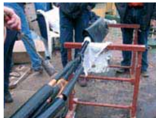
Zagrijavanje izolacijskih cijevi
