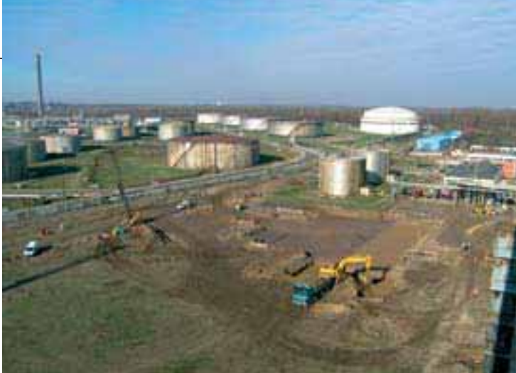
Gradilište Bloka C početkom godine - iskop građevne jame (20. siječnja 2010.)
