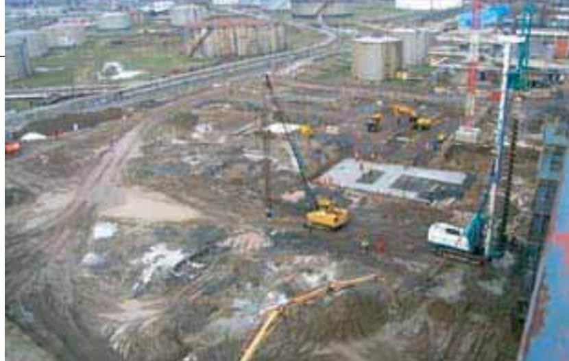
Mjesec dana kasnije na gradilištu je stroj za pilotiranje, postavljen je podložni beton na mjestu kotlovskog postrojenja
