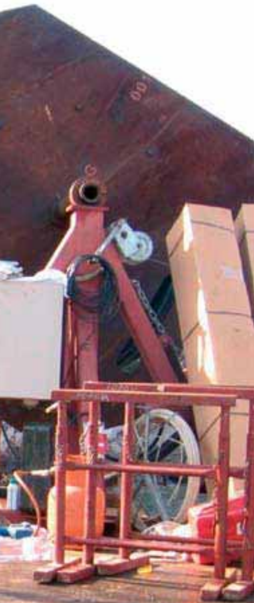
Odmatanje i polaganje kabela na jastuke
