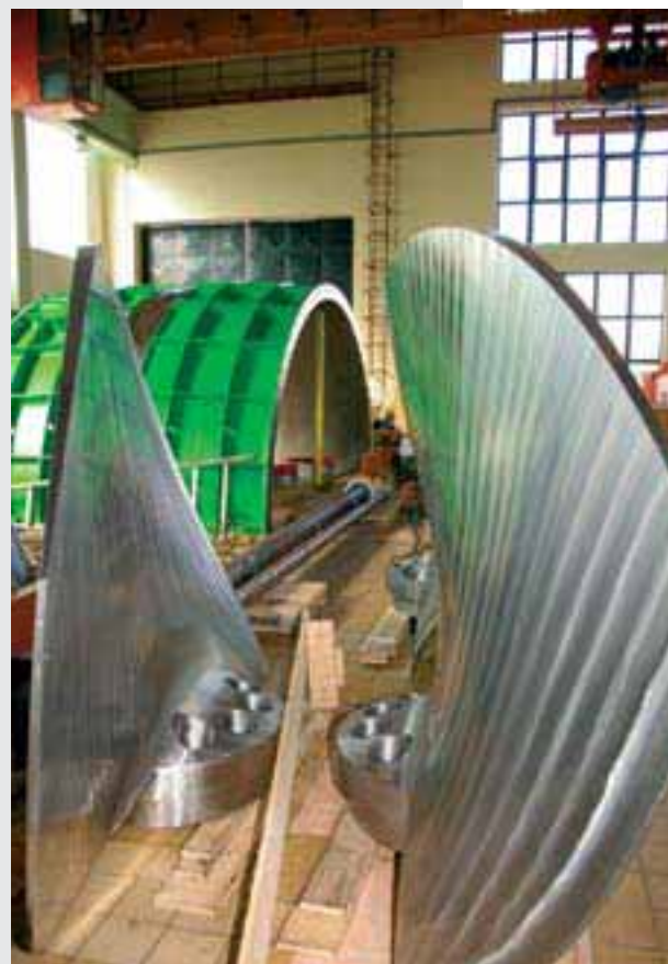
U strojarnici HE Dubrava, nove lopatice turbine spremne su za ugradnju
