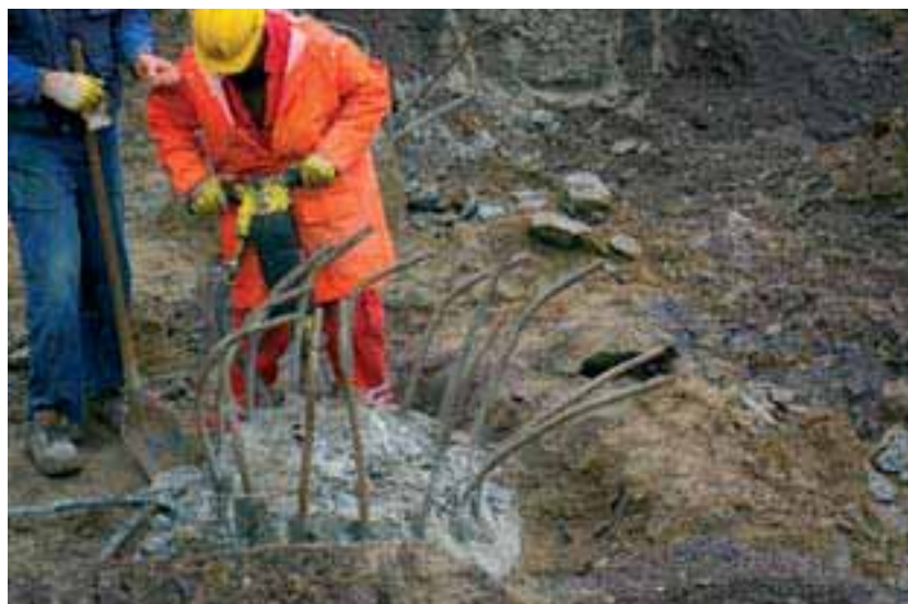
Nakon testiranja, testni piloti se ruše i nastavlja se s izvođenjem velikog broja radnih pilota u polju
