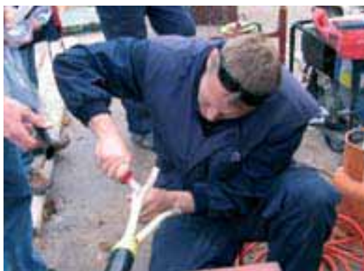
Z. Čarija uređuje stari kabelski dio za pripajanje na novi kabel
