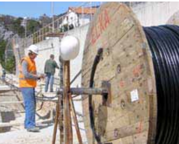
Kabliranje je započelo u TS 110/35/10 kV Veliko Brdo
