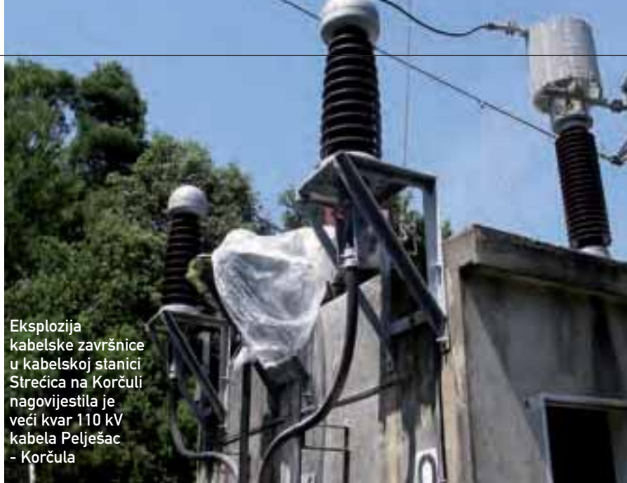
Ronilačke ekipe pronašle su oštećenja kabela blizu pelješke i korčulanske obale
