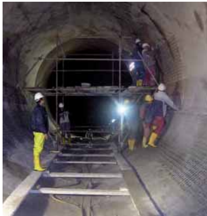
Reprofiliranje dionice urušnja mlaznim betonom s dvostrukom armaturom
