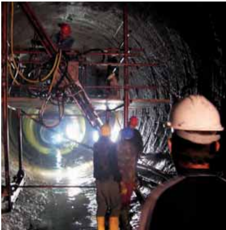
Bušenje za konsolidacijsko injektiranje iza obloge
