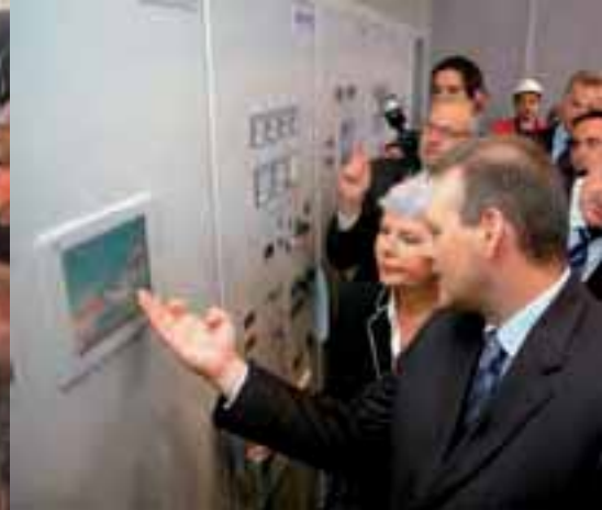
Nakon što je početak rada agregata popratio snažan šum vode, ovdje se na zaslonu u strojarnici moglo vidjeti da su agregati na mreži
