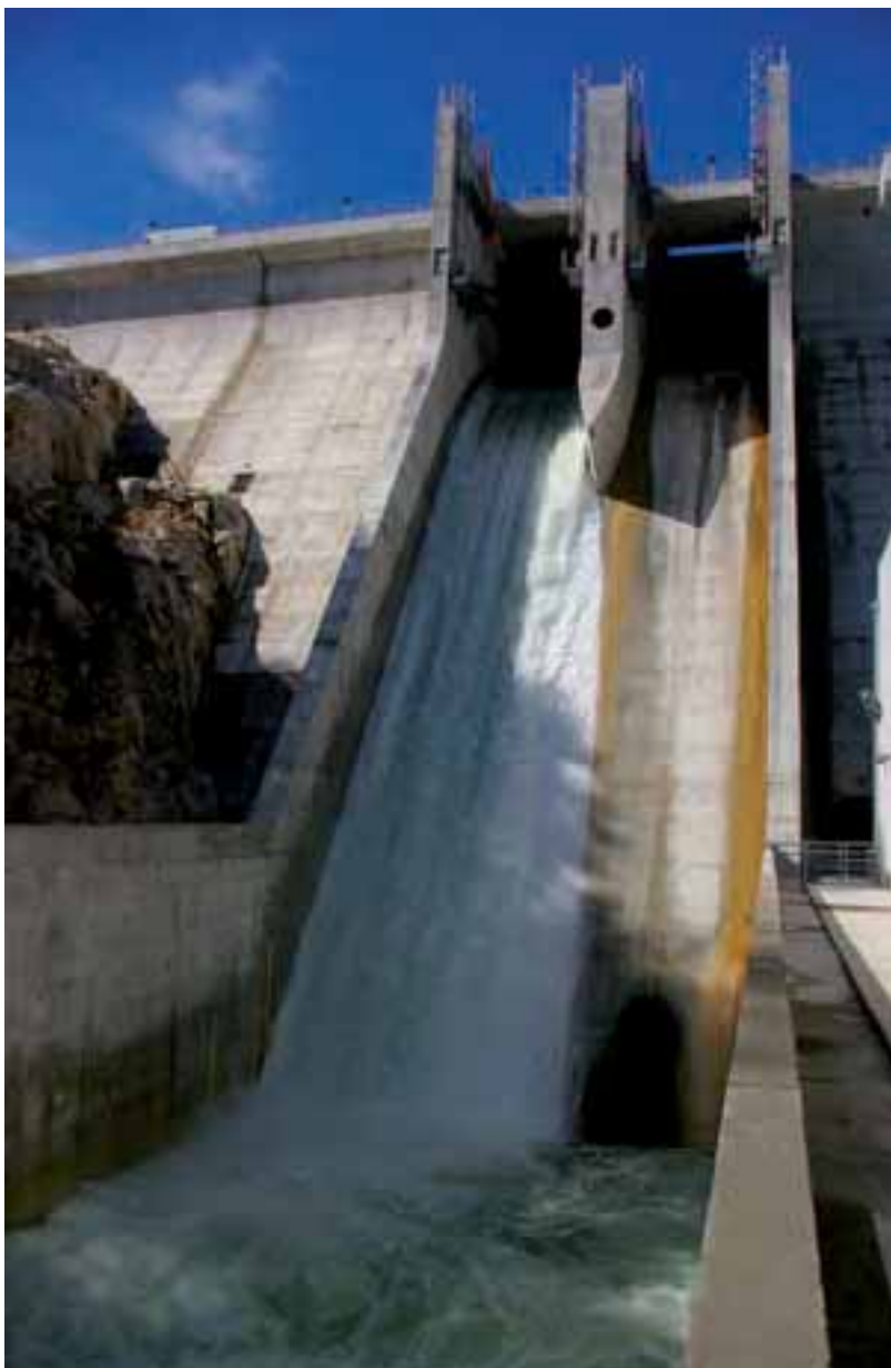
Brana i slapište
