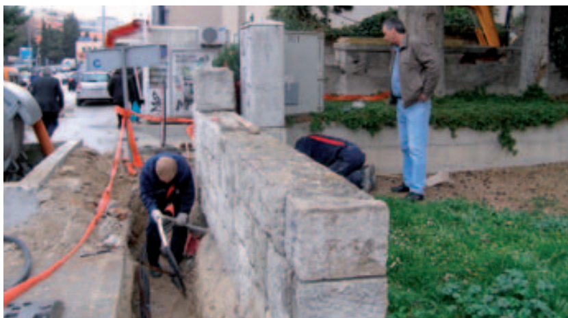
Poslovođa Ivan Plazonić nadgleda vezivanje i uvlačenje kabela u ležište, što kao pripremu za izradu druge spojnice izvode brigadir Nikola Franetović i monter Josip Peroš
