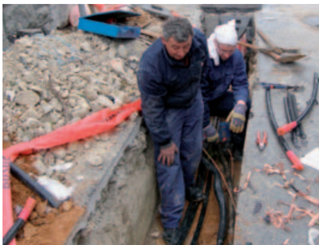
Miro Zebić i Marin Sinovčić na trasi u ulici Puta Plokite izrađuju jednu od spojnika
