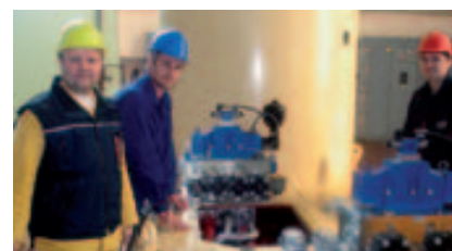
Završna ispitivanja turbinske regulacije
