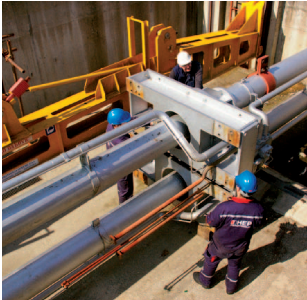
Pavao Sinković, Dražen Orehovec i Danijel Mihalic pregledavaju servomotor nizvodnog turbinskog zatvarača
