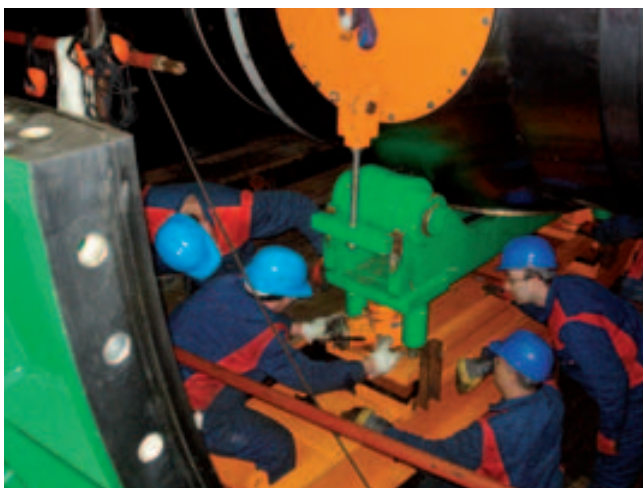
Spajanje nove glavine radnog kola i turbinskog vratila i...
