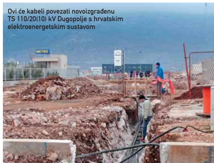
U isti kanal polaže se 110 kV kabel i kablenski raspjet 20 kV iz TS Dugopolje
