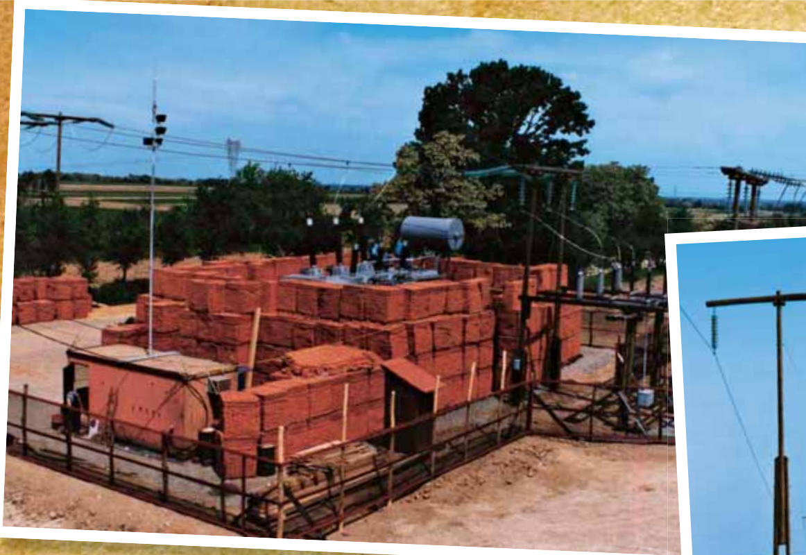
TS 220/110 kV - "1505/2", 150 MVA, izgrađena u 44 dana od donošenja konačne odluke o njenoj uspostavi, što je bio doista veliki uspjeh
