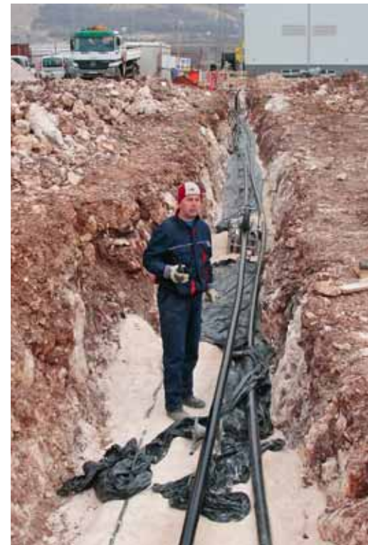
U isti kanal polaže se 110 kV kabel i kablenski raspjet 20 kV iz TS Dugopolje
