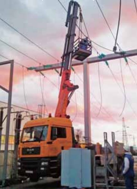
Demontaža linijskog rastavljača DV1 prema TS Nedeljanec
