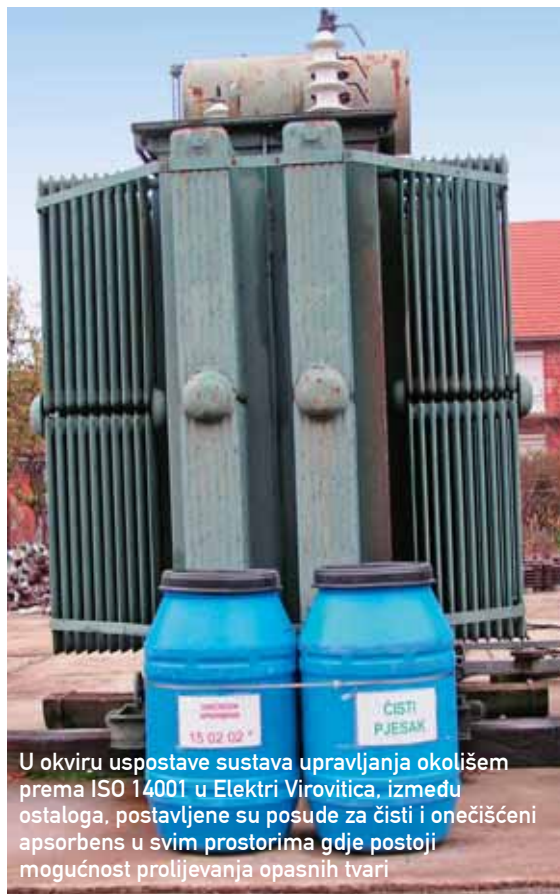
Za mHE Pleternica na području Elektre Požega, u tijeku je izgradnja priključka na mrežu, nakon čega slijedi izdavanje elektroenergetske suglasnosti - preduvjeta njena pokusnog rada
