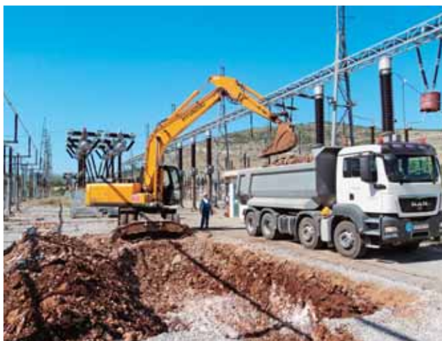
Kopanje temelja za nove prekidače
