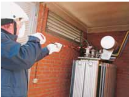
Provedba praktičnih zadataka čišćenja: provodnog izolatora suhim postupkom...
