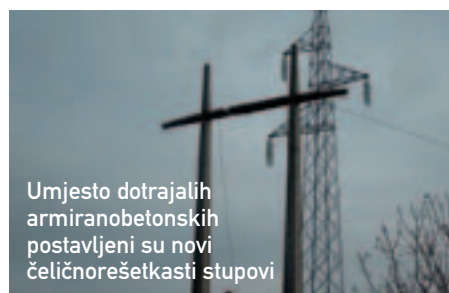
Pojedine dionice dalekovoda 110 kV Bilice - Trogir, izgrađenog prije 60 godina, bile su u iznimno lošem stanju i niske pogonske iskoristivosti pa je bila nužna njegova djelomična obnova i to na trasi između TS 110/35 kV Trogir i TS 12/110 kV Jelinak (od stupa 153 do stupa 167 (936))
