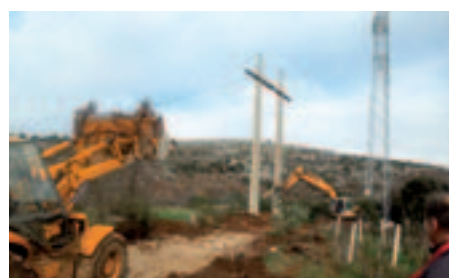
Pojedine dionice dalekovoda 110 kV Bilice - Trogir, izgrađenog prije 60 godina, bile su u iznimno lošem stanju i niske pogonske iskoristivosti pa je bila nužna njegova djelomična obnova i to na trasi između TS 110/35 kV Trogir i TS 12/110 kV Jelinak (od stupa 153 do stupa 167 (936))
