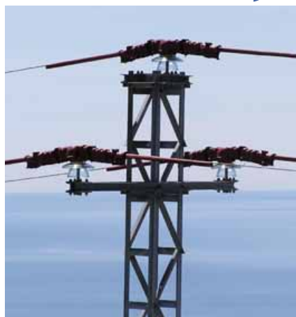
Stupovi Elektroprimorja s izlolačijskom opremom koja sprječava stradavanje ptica
