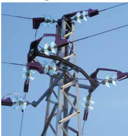
Stupovi Elektroprimorja s izlolačijskom opremom koja sprječava stradavanje ptica
