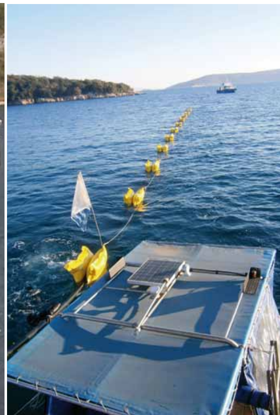
Nakon temeljitih dvotjednih priprema, kabel Krk-Cres položen je uz pomoć trajekta Prizna riječke Jadrolinije tijekom samo jednog dana
