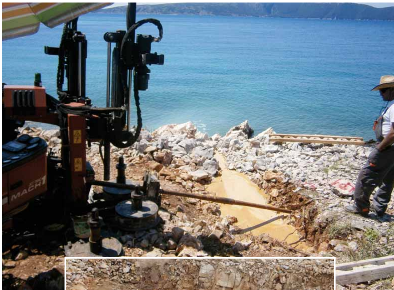
Prvi put na ovim prostorima primijenjena je metoda bušenja bez raskopavanja i devastacije obale
