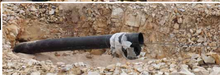
Prvi put na ovim prostorima primijenjena je metoda bušenja bez raskopavanja i devastacije obale
