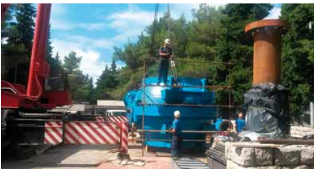
Priprema za utovar kuglastog zatvarača i prijevoz u tvornicu Litostroj, gdje će ga obnoviti
