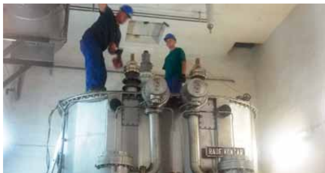
Demontaža bloktransformatora
