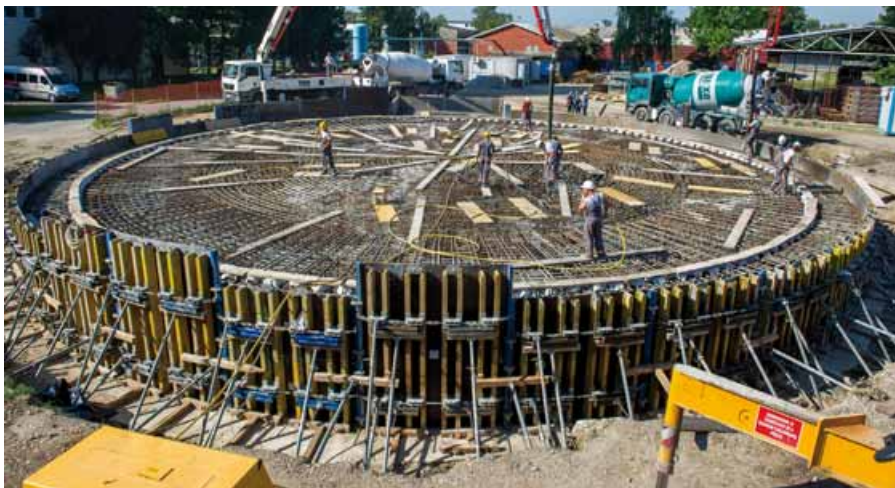
Betoniranje temeljne ploče (srpanj 2014.)
