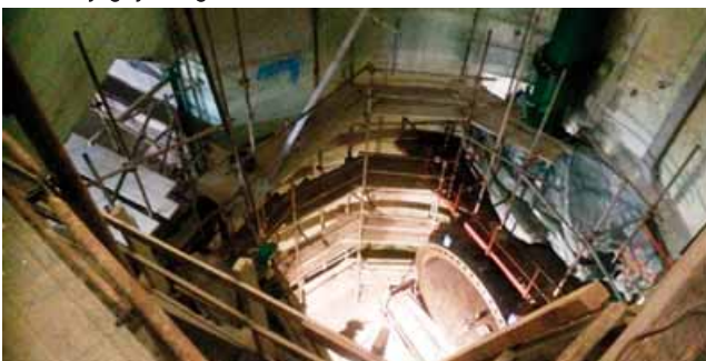
Građevinska skela u turbinskom prostoru agregata C
