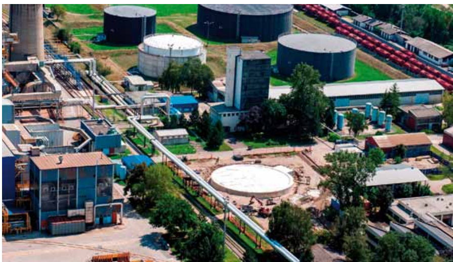
Završetak glavnih građevinskih radova (kolovoz 2014.).
