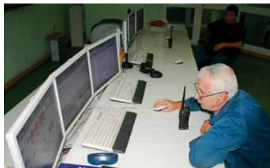
Edi Dizdar, turbinovođa, na zaslonima prati sve parametre turbine prvog Bloka
