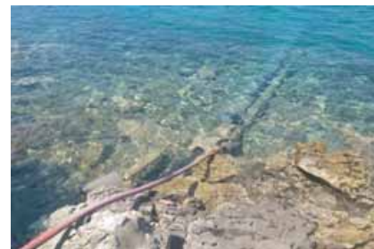
Stari, na nekoliko mjesta oštećeni 10 kV kabel premalog presjeka odlazi iz mora
