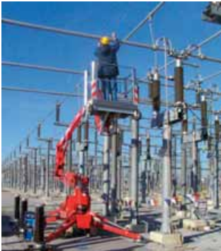
Priprema za ispitivanje sklapanja prigušnice 110 kV u TS Ernestinovo – montaža i priprema mjerne opreme
