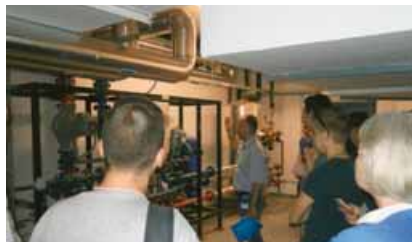
Gostima iz zagrebačke Strojarsko tehničke škole Fausta Vrančića, u termotehničkom postrojenju nove zgrade HEP-a predstavljena je oprema za praćenje potrošnje električne i toplinske energije
