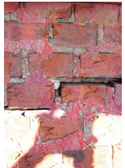
Beton je trebalo očistiti do zdrave podloge pa potom sanirati i bojati
