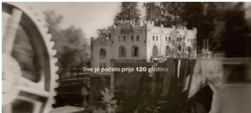
Hidroelektrana Ozalj simbolizirala je našu prvu elektranu - HE Krka
