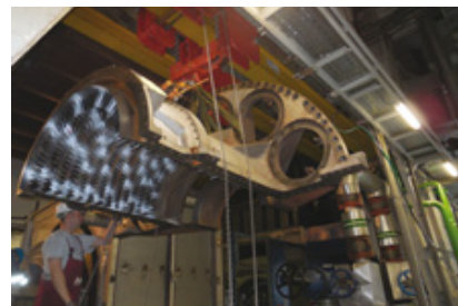
Montiranje statora kompresora nakon remonta
