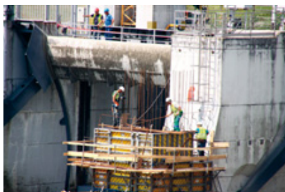
Obavljene su prilagodbe sustava optočne rashladne vode te brane na Savi
