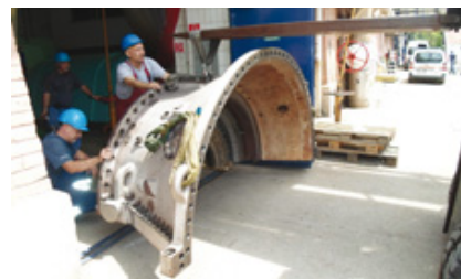
Manipulacija teškim dijelovima turbinskog statora prilikom ponovne ugradnje nakon remonta
