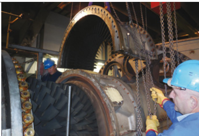
Demontaža statora kompresora plinske turbine
