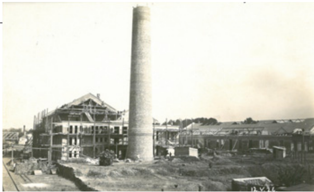
Gradilište osječke elektrane, 12. svibnja 1926.
