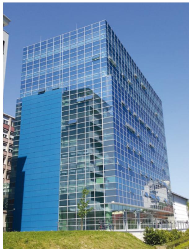
Predstavljen je projekt napredne regulacije KGH sustava, koji se provodi na novoj upravnoj zgradi HEP-a u Zagrebu
